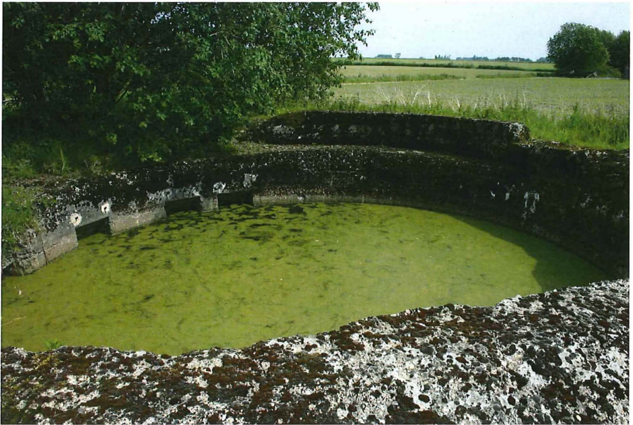
Foto 3: De met water gevulde betonnen geschutsbedding.
