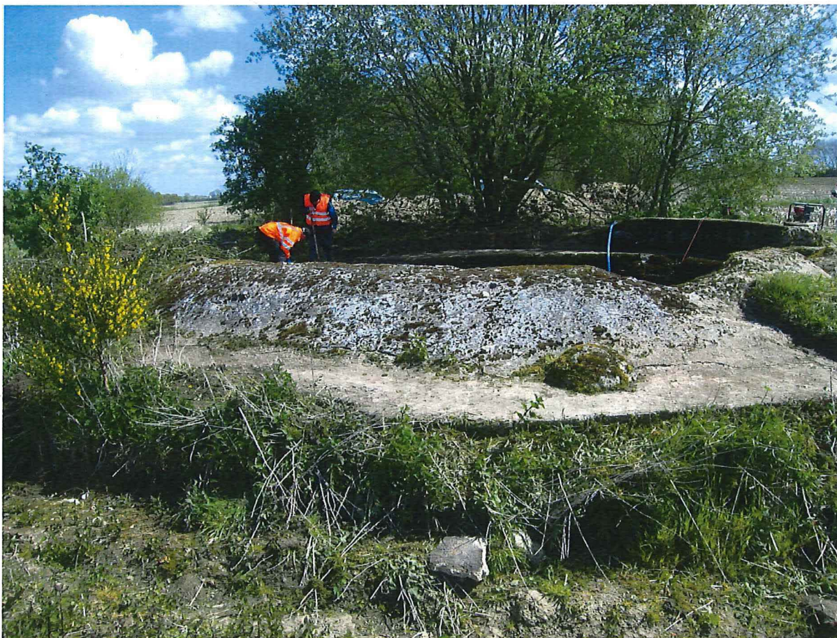
Foto 1: De betonnen geschutsbedding.
