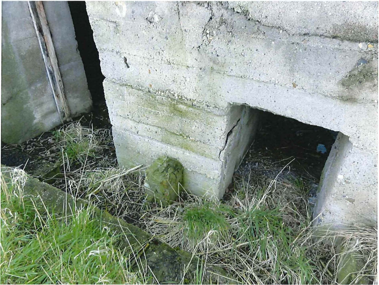
Foto 3: Betonnen muurtje bij de rechtersingang en toegang tot het mangat.
