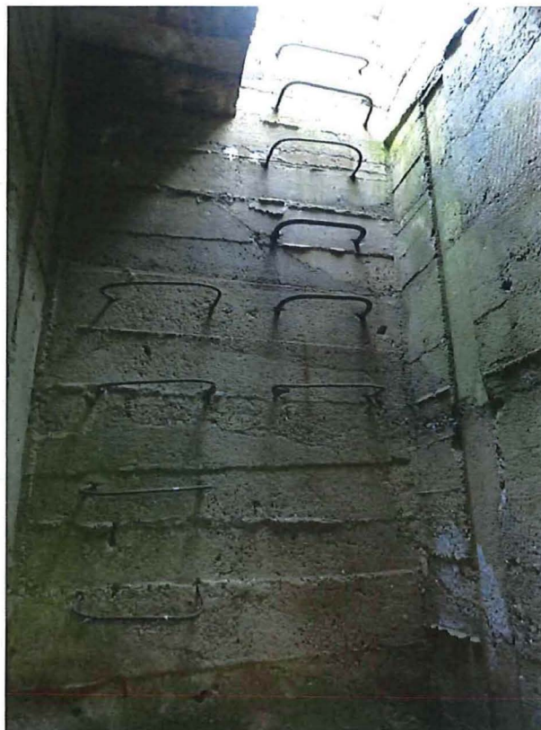
Foto 4: Mangat met klimijzers.
