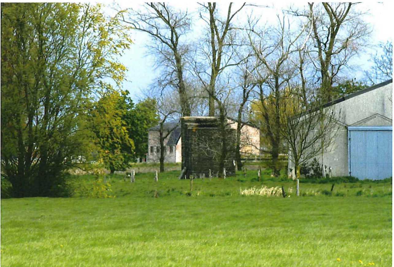
Foto 2: Zicht op de frontzijde van de artillerieobservatiepost.
