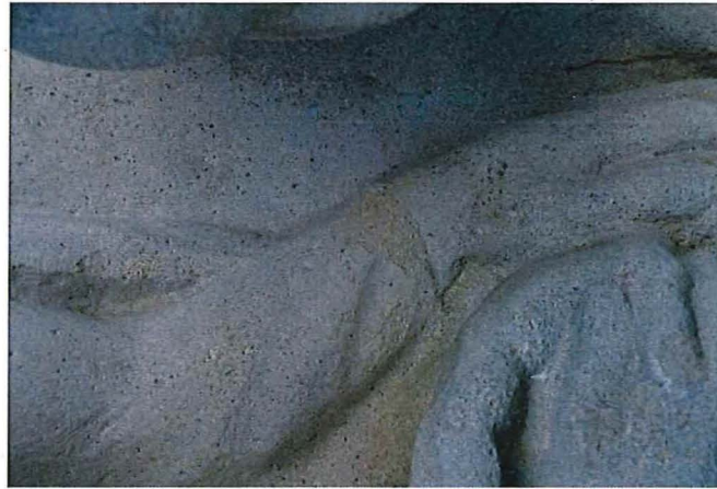
Fig. 15: Oppervlakkig materiaalverlies, 2016
