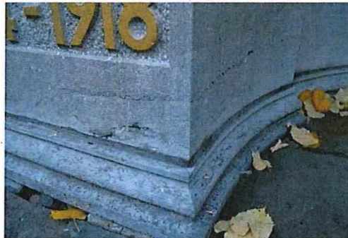
Fig. 18: Uitgespoelde stylolieten met lacunes, 2016
