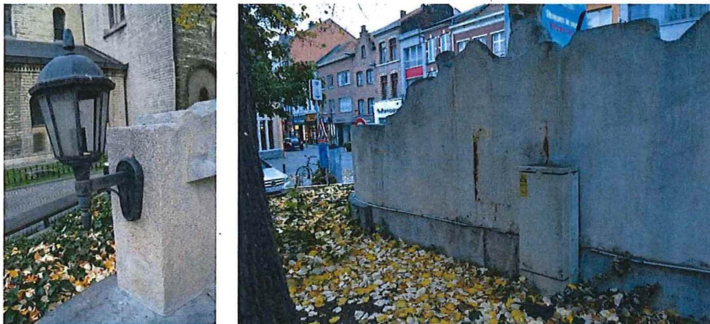
Fig. 13 en 14: Schade aan de lantaarn (links) en achterzijde van het monument (rechts), 2016
