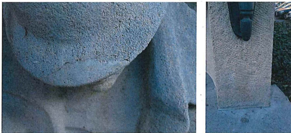
Fig. 12: Oude mortelherstelling aan de helm, 2016
