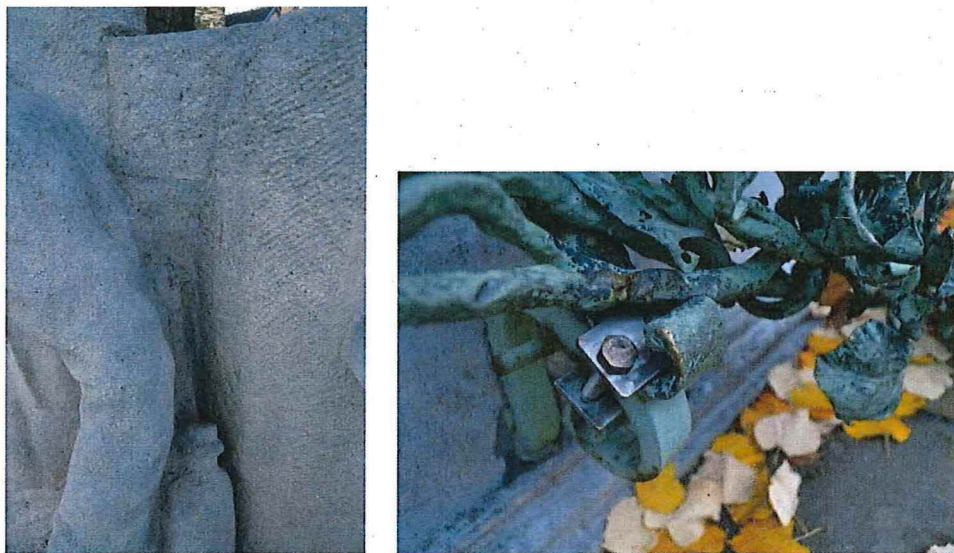
Fig. 22 en 23: Voeg tussen twee blokken en bevestiging van de bloementuil, 2016
