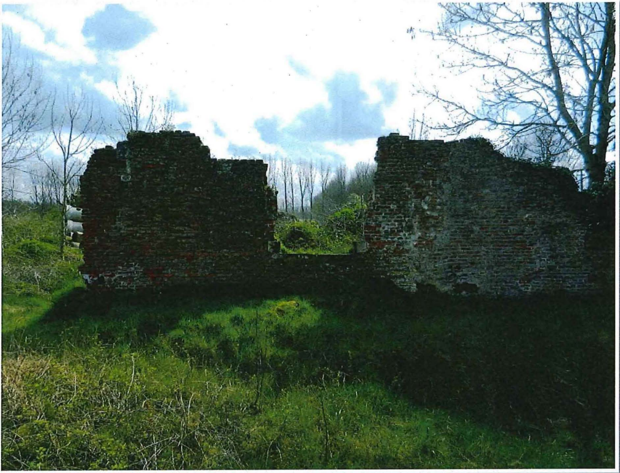
Foto 8: noordmuur van de vroegere zuidvleugel.
