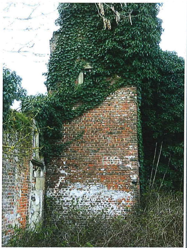
Foto 10: de traptoren, gezien vanuit het oosten.
