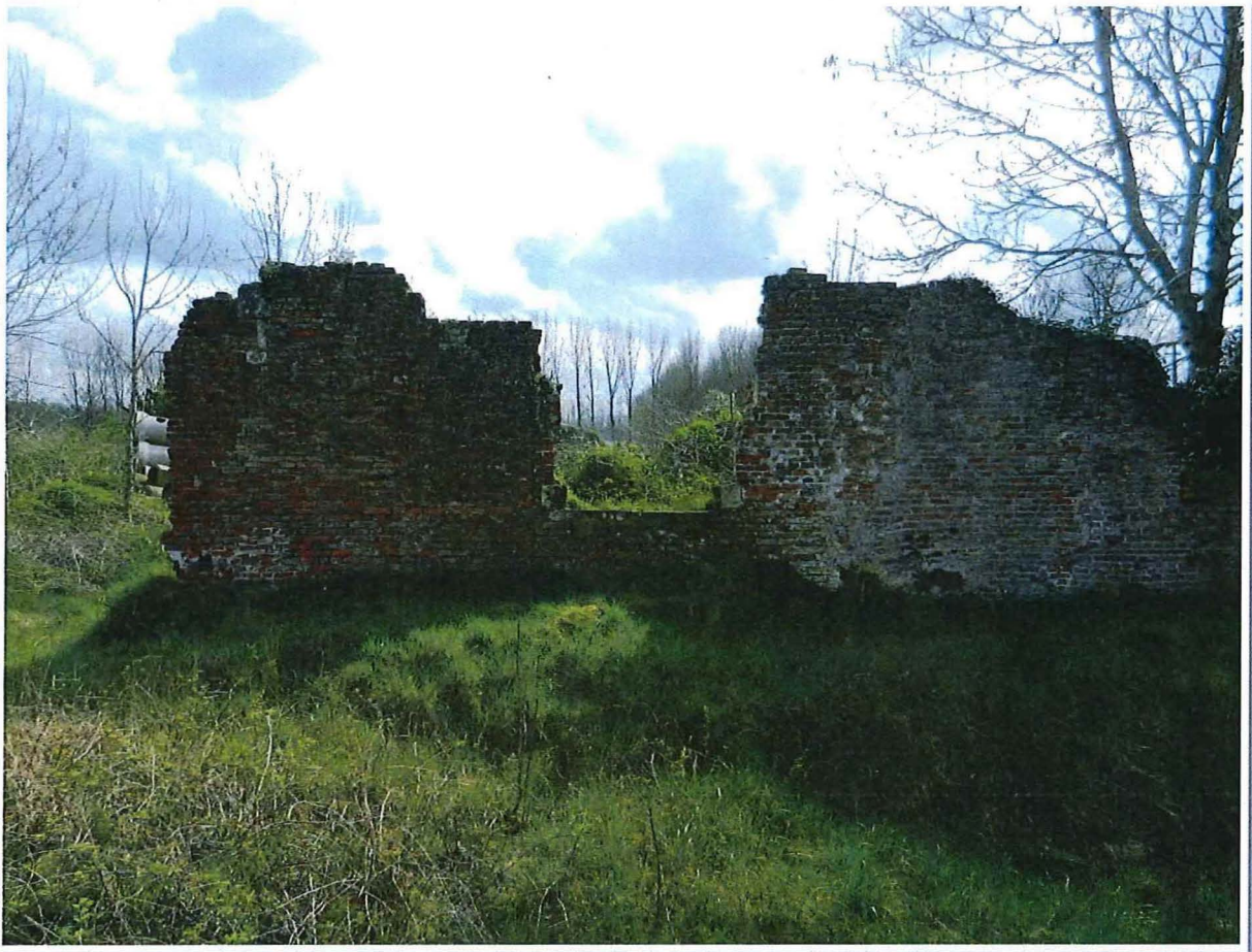
Foto 8: noordmuur van de vroegere zuidvleugel.
