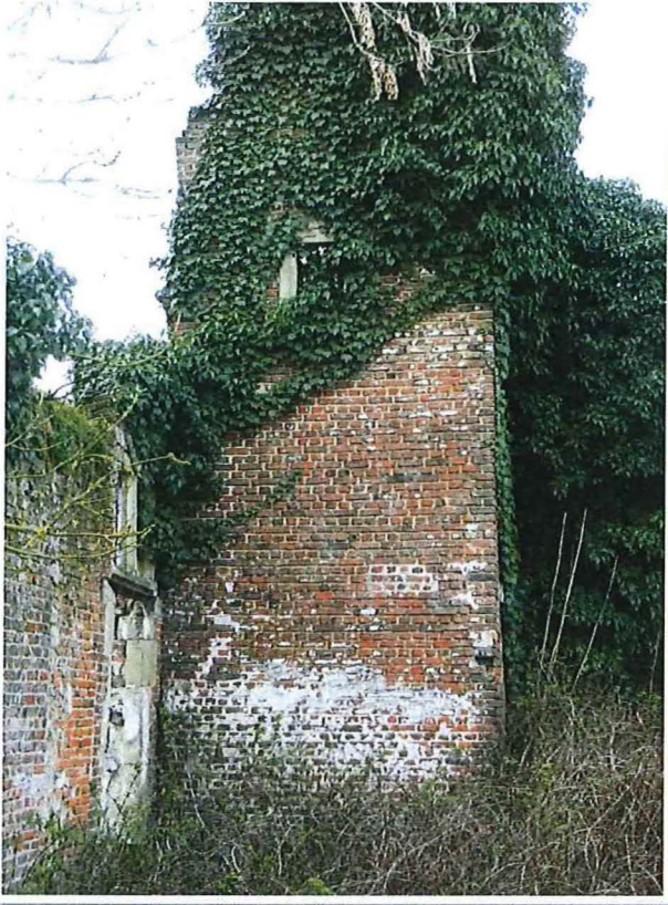
Foto 10: de traptoren, gezien vanuit het oosten.
