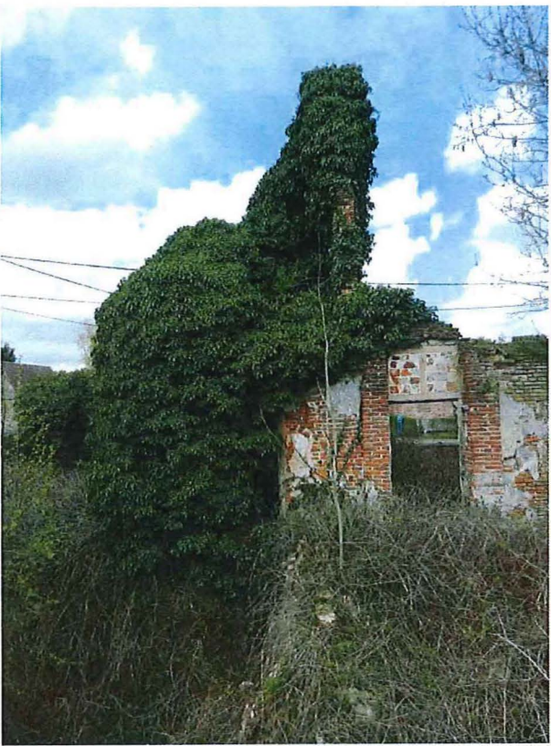
Foto 15: zicht op de traptoren vanuit het zuiden.
