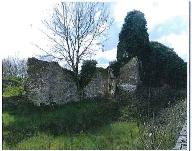
Foto 7: zicht op de traptoren en de noordmuur van de vroegere zuidvleugel.
