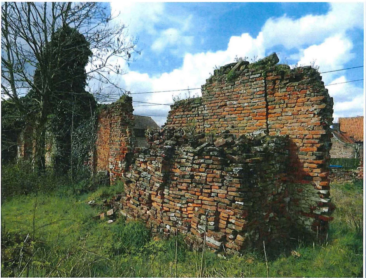
Foto 12: de noordmuur van de vroegere zuidvleugel, gezien vanuit het zuidoosten. Op de voorgrond, stapel bakstenen van het hof van Coudenborn.
