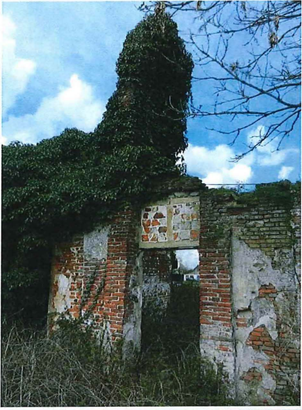
Foto 13: de deuropening naast de traptoren, gezien vanuit het zuiden.
