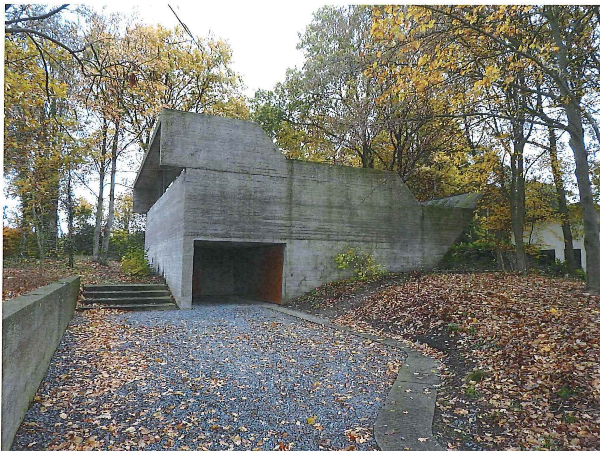
Foto 4: Woning Van Wassenhove. Zuidgevel.
