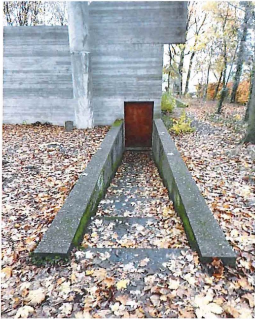
Foto 11: Woning Van Wassenhove. Detail noordgevel met achterdeur en lange trap.
