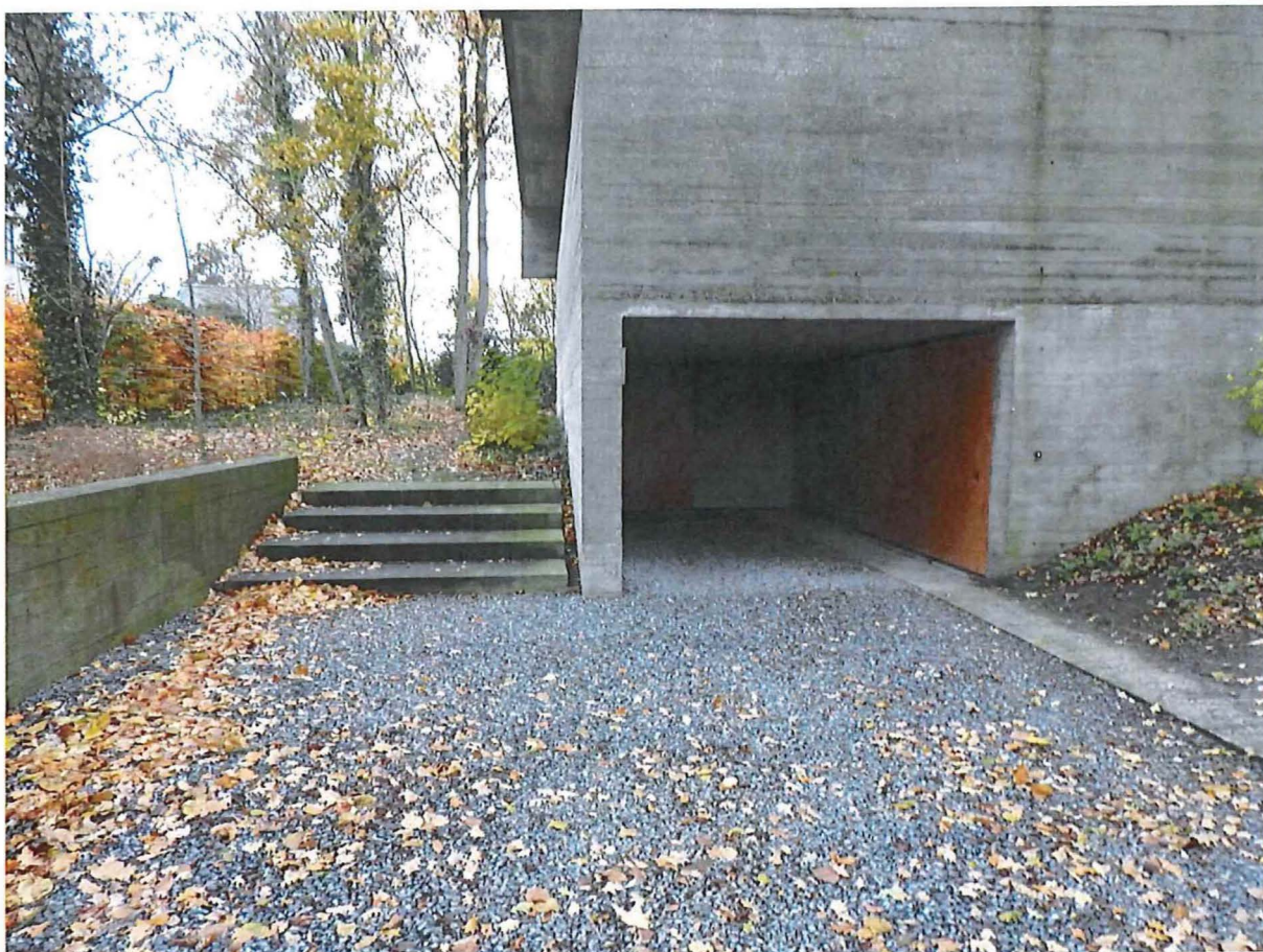
Foto 6: Woning Van Wassenhove. Zuidgevel. Detail carport en trap lang westgevel.
