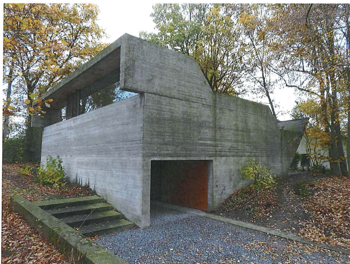
Foto 8: Woning Van Wassenhove. Zuid- en westgevel.
