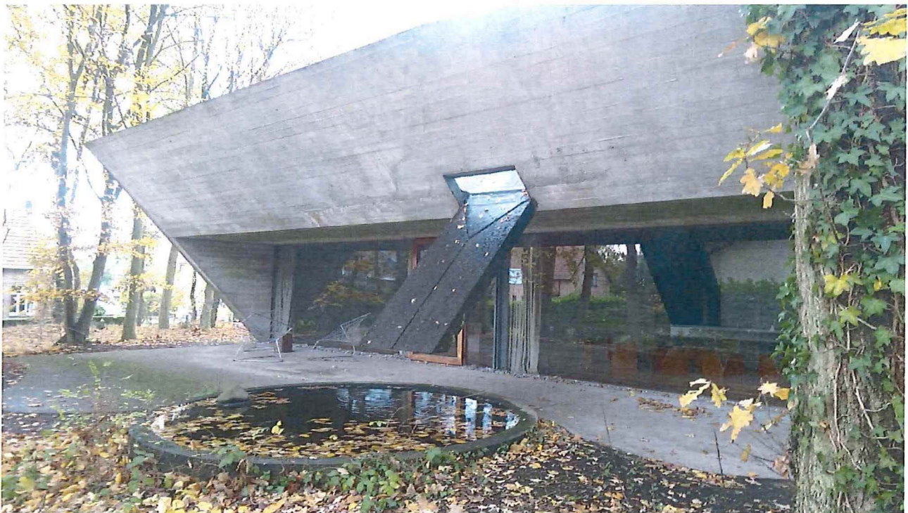
Foto 15: Woning Van Wassenhove. Oostgevel met spuer die uitmondt in waterbassin en betonnen terrasaanleg in een plastische vorm.
