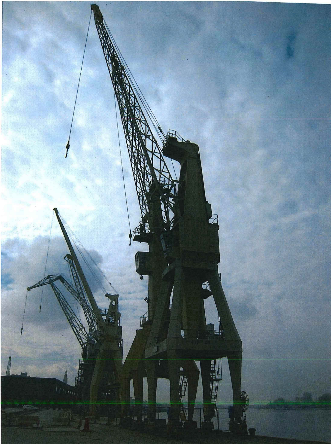
Foto 2: De toren van de 410 KD is een draaizuil die in het portaal rust. De zuil draait onderaan op een taatslager die op kruisvormige platform tussen de poten is geplaatst. Bovenaan het portaal draait de zuil in een ringlager.
