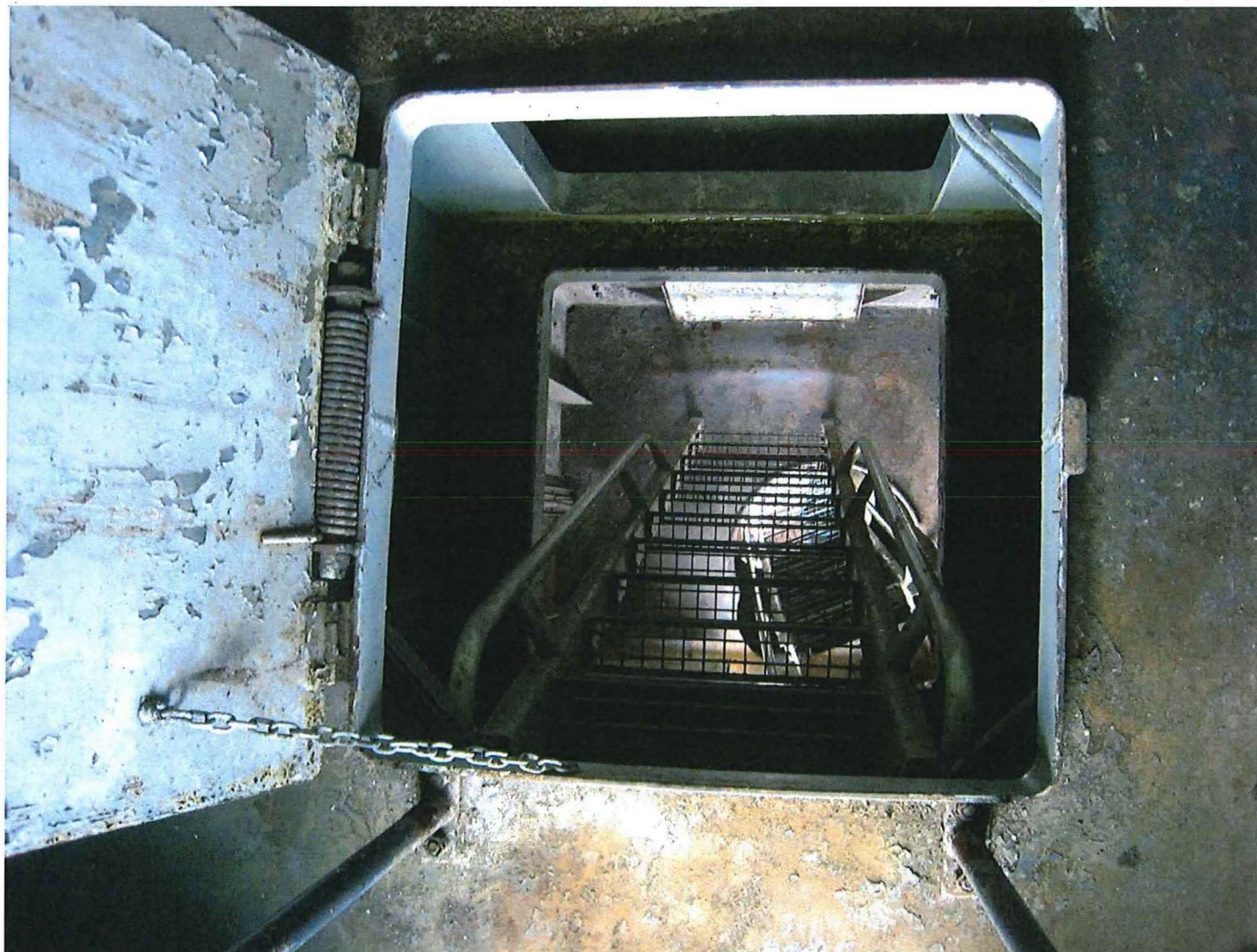
Foto 16: Zicht vanop het niveau van de machinekamer op de trappen naar beneden.
