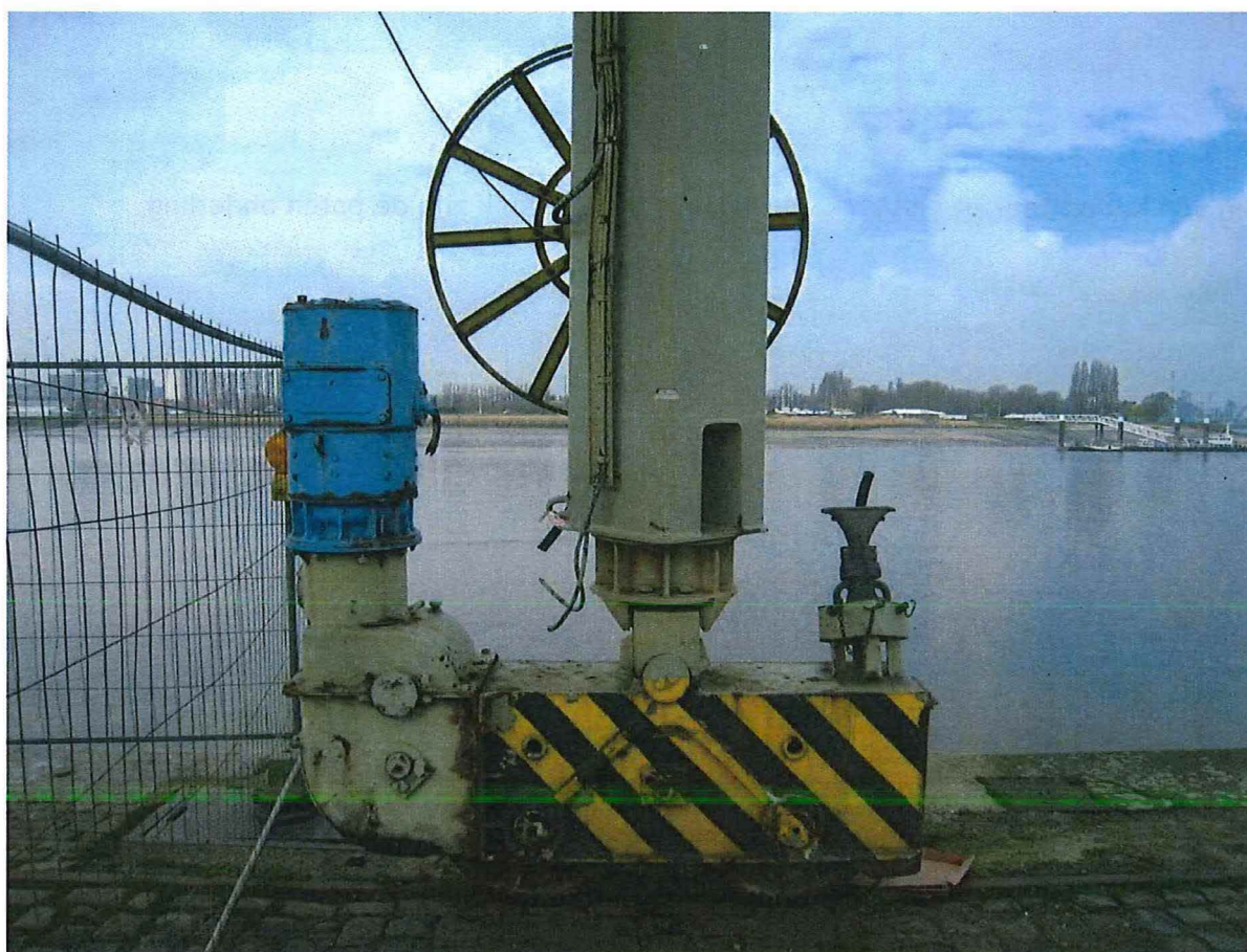
Foto's 6 en 7: De kraan rust op vier bogies. Twee van de vier bogies worden aangedreven door een aangeflenste elektromotor.
