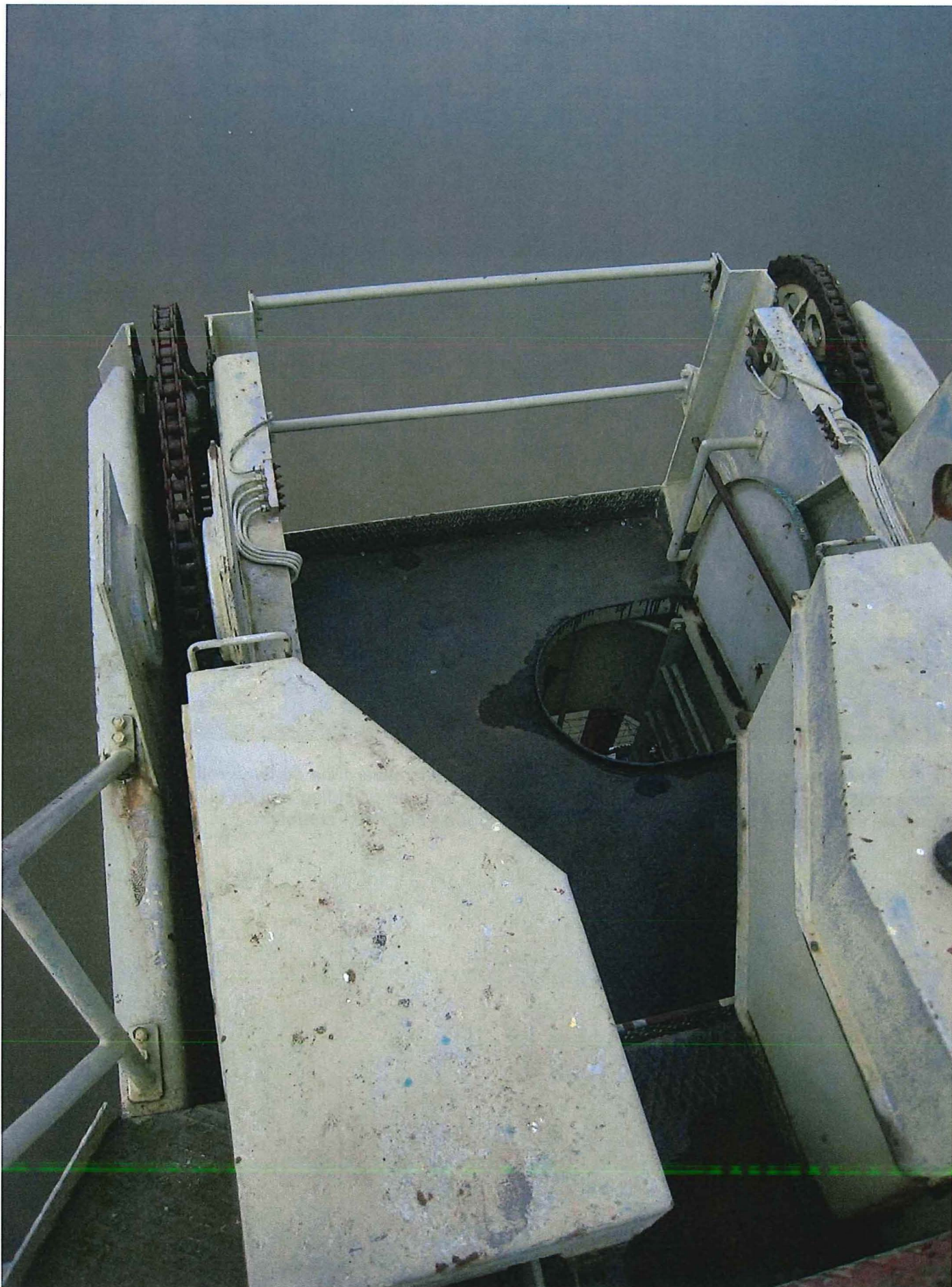
Foto 38: Zicht op het bovenste bordes in de top van de toren met de kettingwielen die de rollenketting van het tegengewicht van de giek geleiden en de kasten waarin de lastmomentbegrenzer geïnstalleerd is.
