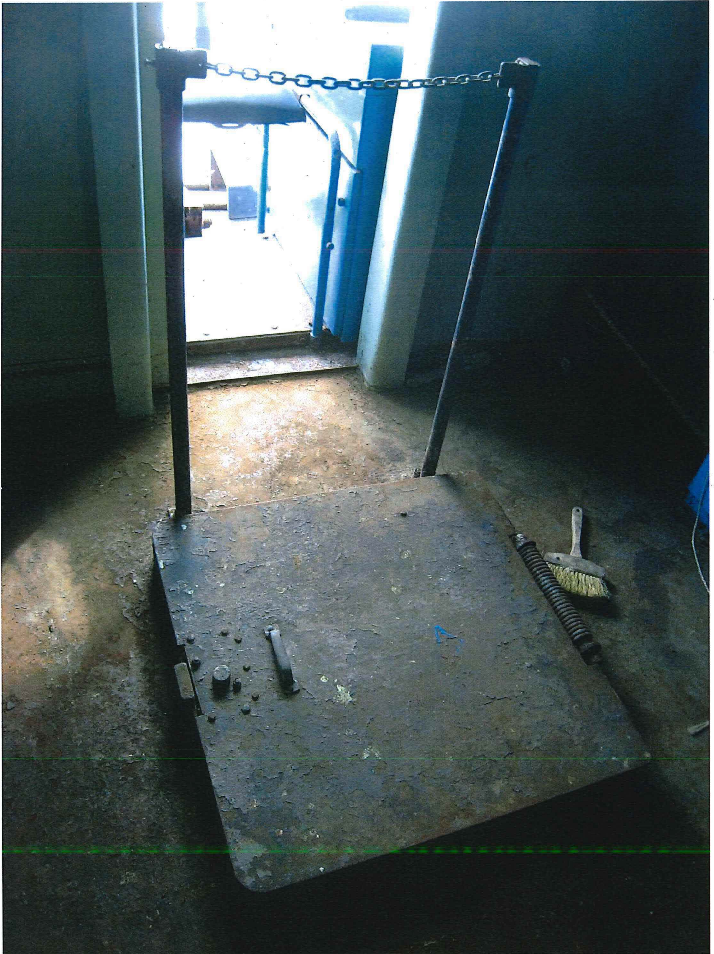
Foto 17: Het mangat met luik waarop de trap op het niveau van de machinekamer uitgeeft.
