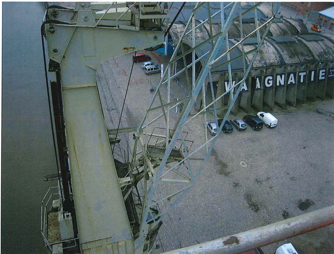
Foto 44: Aan de achterzijde van de toren is het tegengewicht van de giek en de glijbaan zichtbaar.
