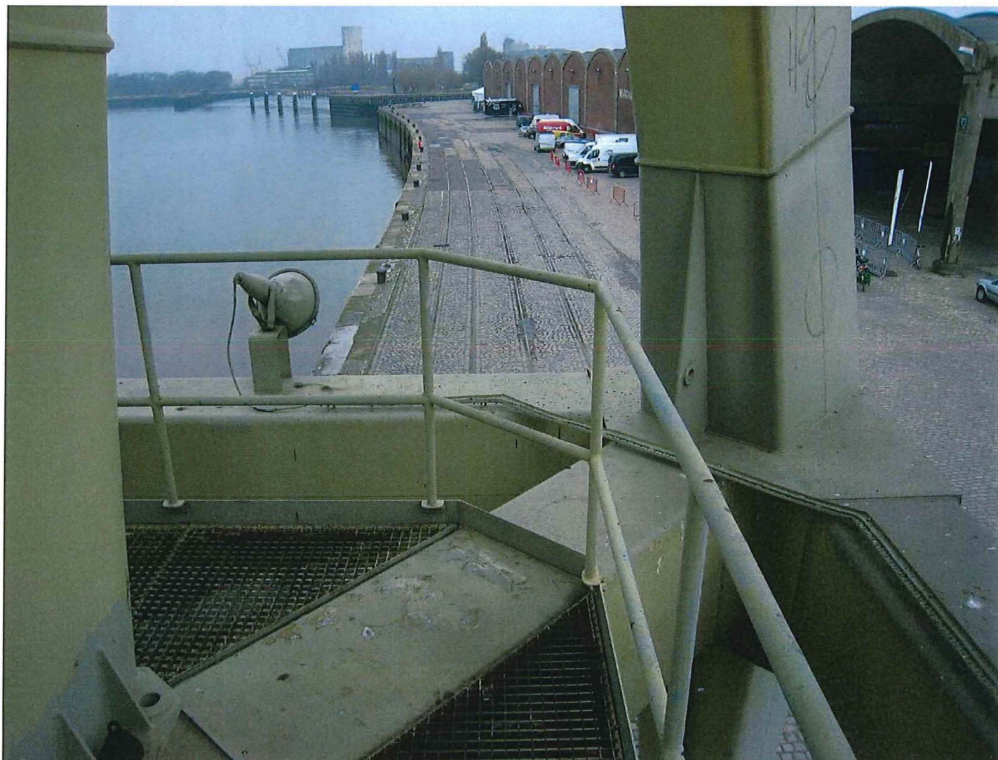
Foto 13: Het bordes op het kruis, met de verbinding met de poten.
