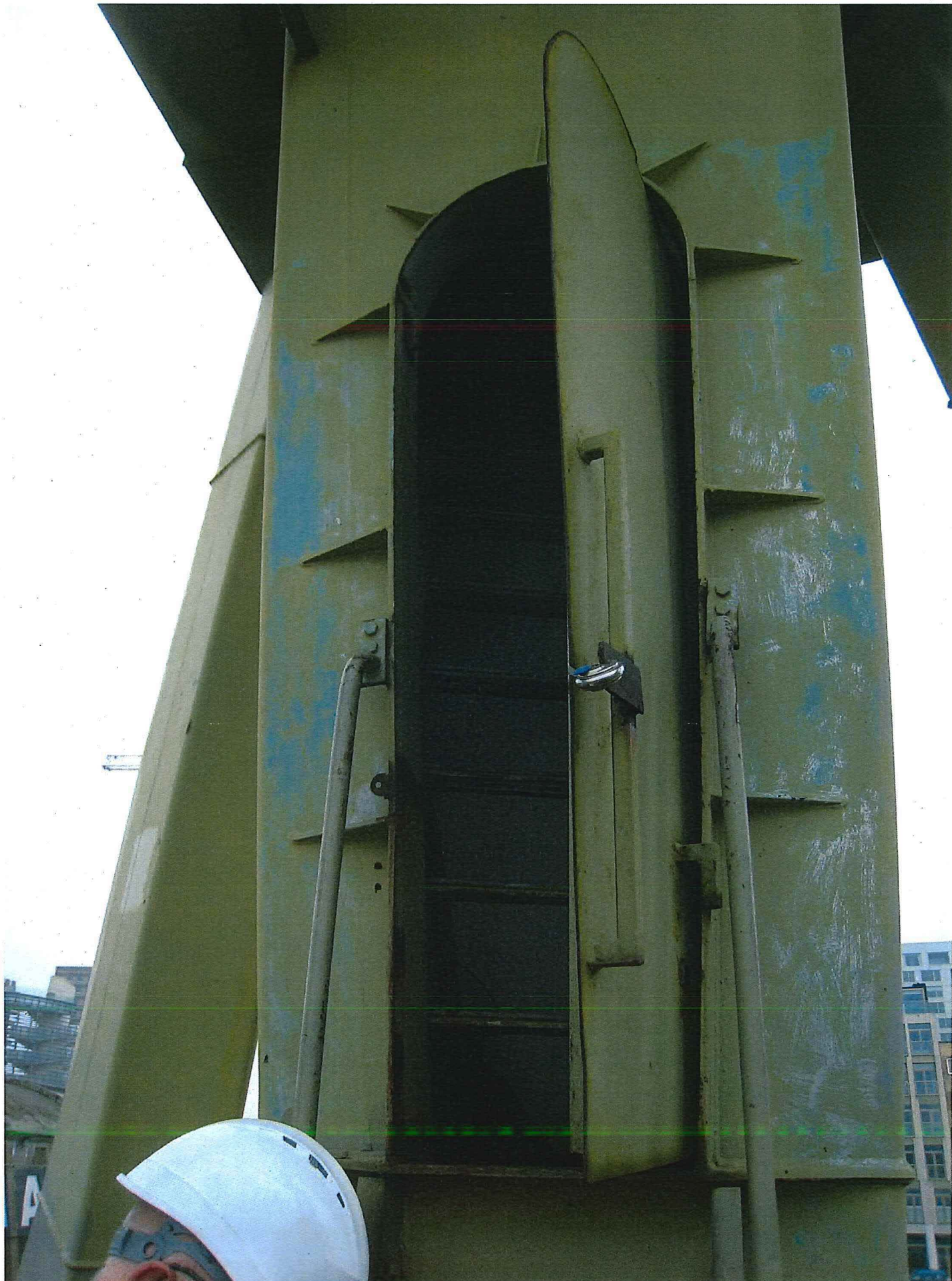
Foto 15: De deur die op het bordes toegang geeft tot de draaizuil.
