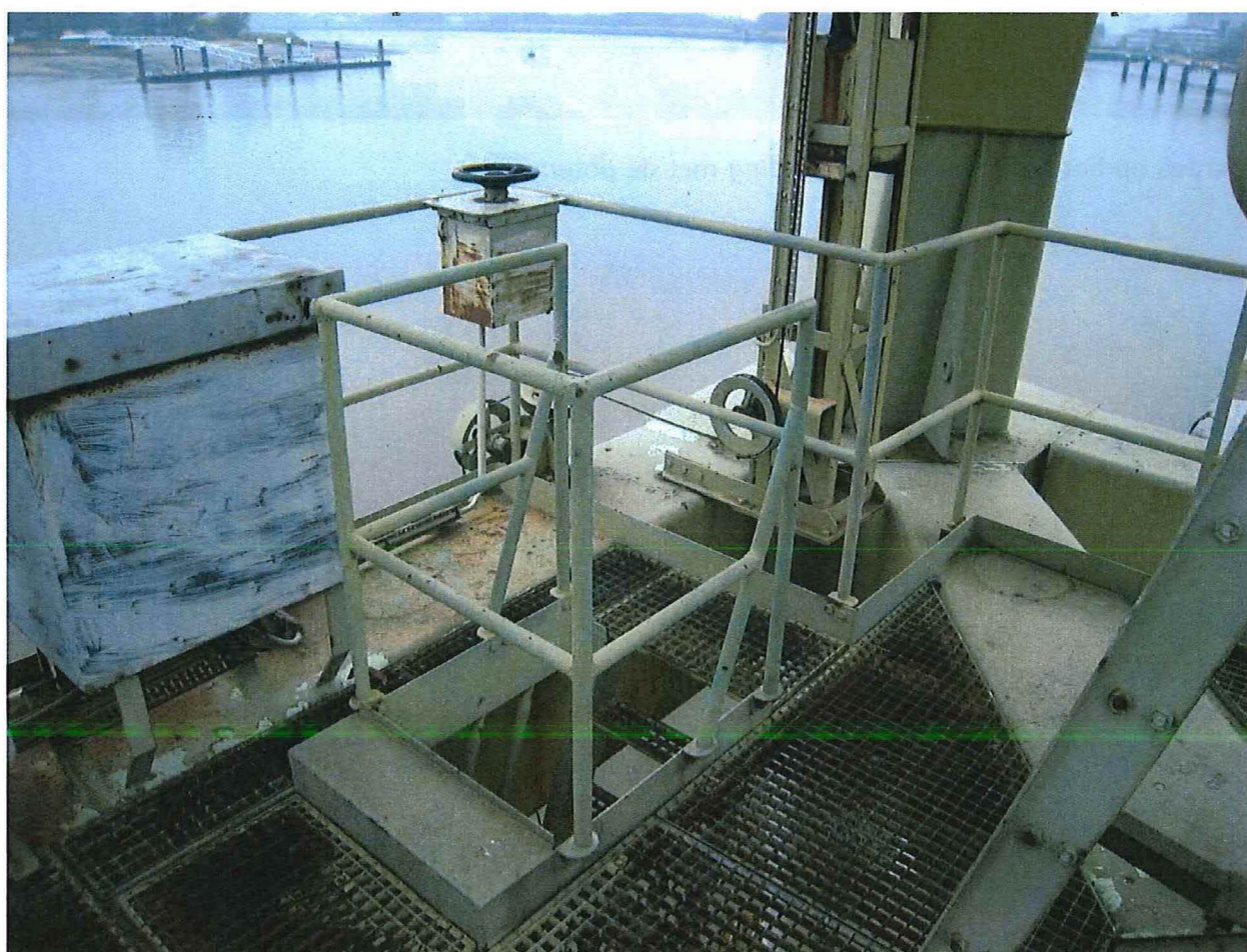
Foto's 11 en 12: De trap komt uit op het bordes bij het kruis. Zicht vanop het bordes op de trap.
