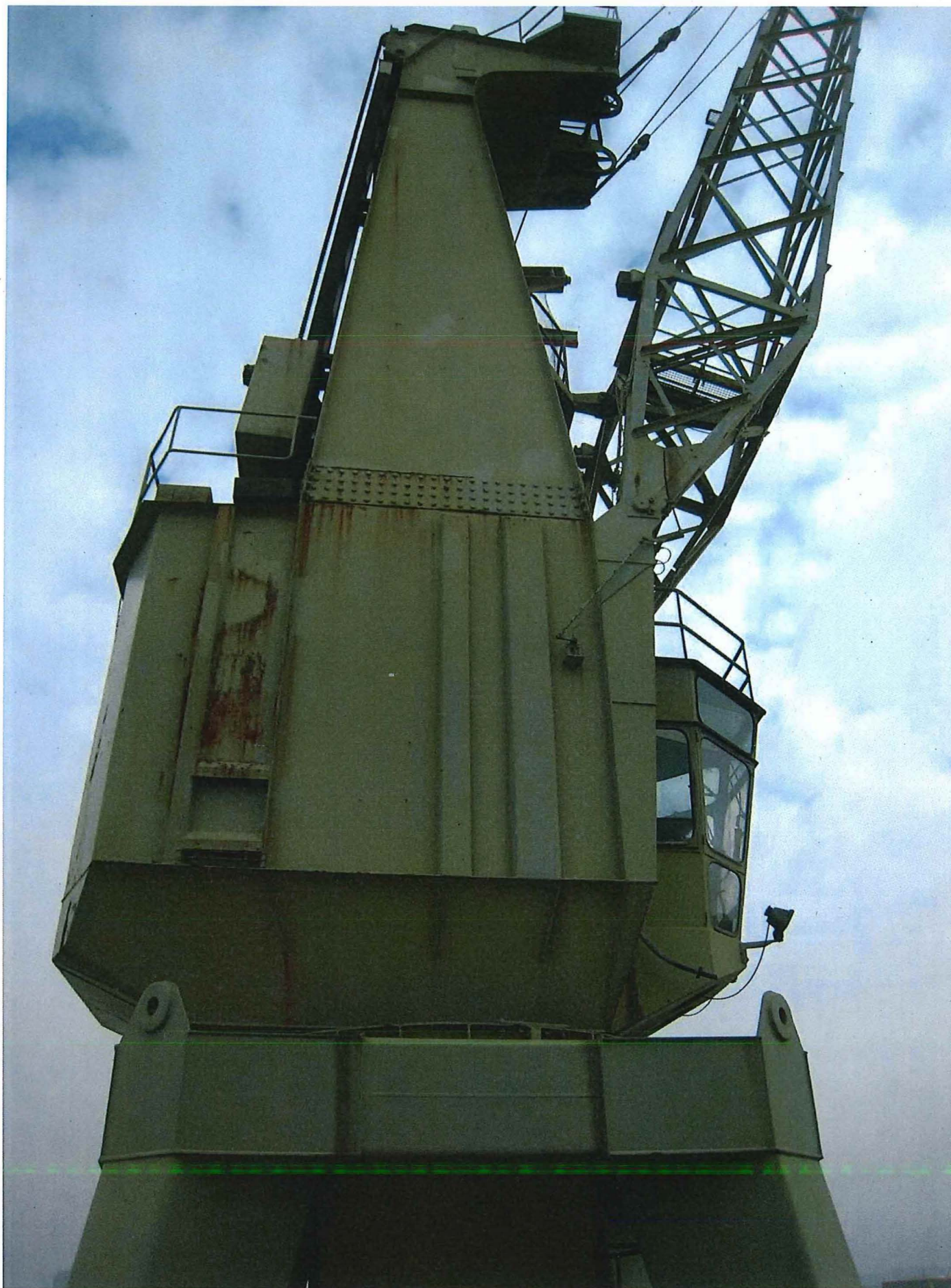
Foto 3: Op het niveau van de stuurcabine is een machinekamer voorzien voor de elektrische schakelapparatuur met weerstanden en schakelingen.
