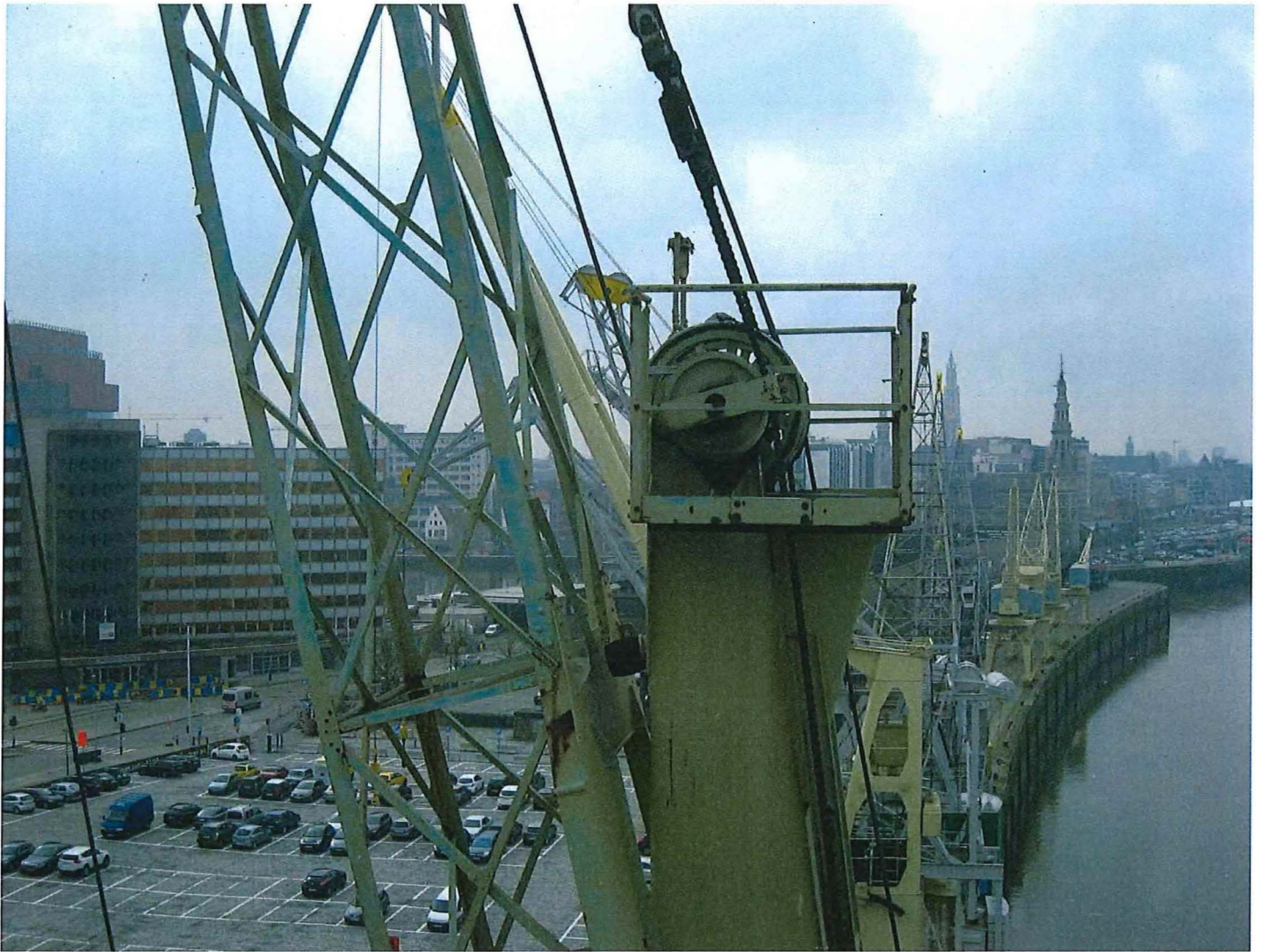
Foto 19: De top van de toren, met de schijven voor de geleiding van de hijskabel en de fleyerkettingen van het tegengewicht van de giek.
