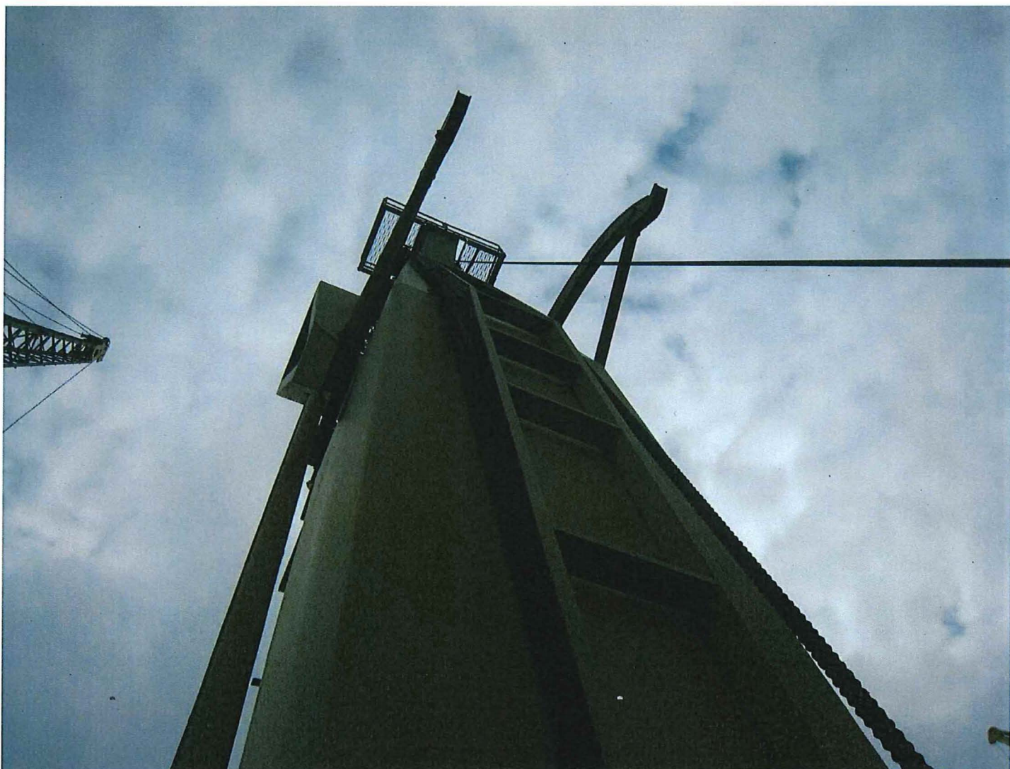
Foto 12: De glijbaan van het tegengewicht met de fleyerkettingen waaraan het tegengewicht is opgehangen.
