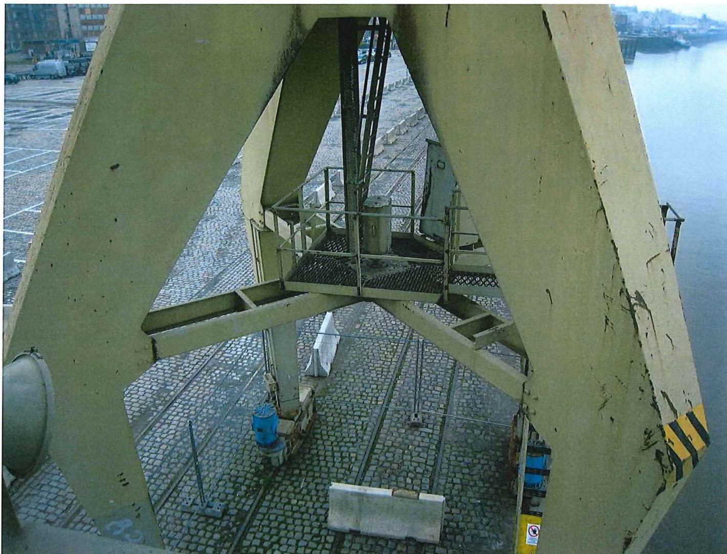
Foto 5: De kruisvormige verstijving van de portaalpoten met het platform dat toegang geeft tot de ladder naar de toren.
