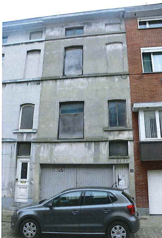
Foto 7: Voorgevel van het woonhuis Weldadigheidstraat 10, met de houten garagepoort die leidt naar de achterliggende danszaal.
