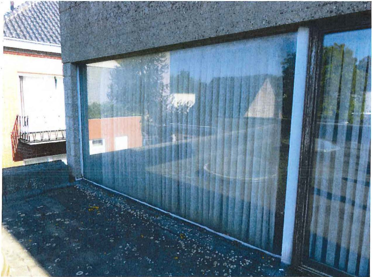
Foto 25: Achtergevel hoofdgebouw, eerste verdieping. Detail vensteropening met vast raam.
