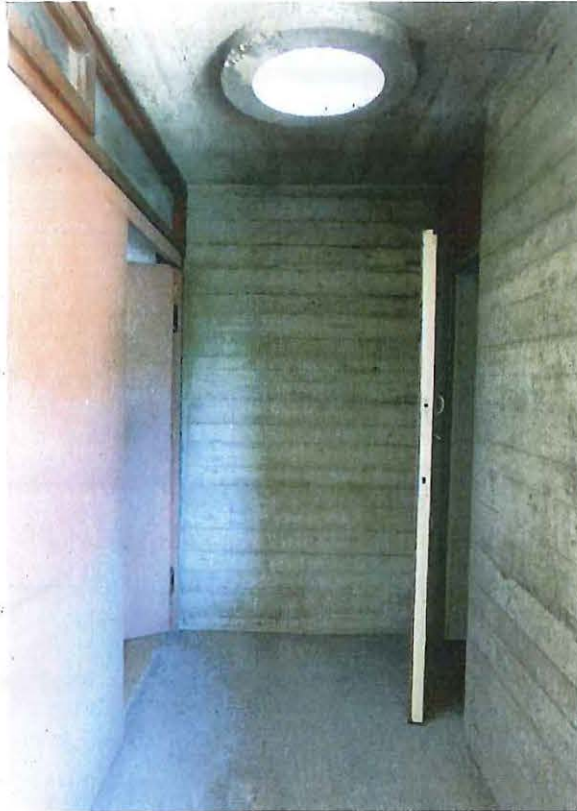
Foto 11: Voorgevel hoofdgebouw. Tweede bordes van de buitentrap met links de toegang tot de jeugdclub en rechts een toilet. Het bordes wordt centraal belicht door een cirkelvormige opening met koepel.
