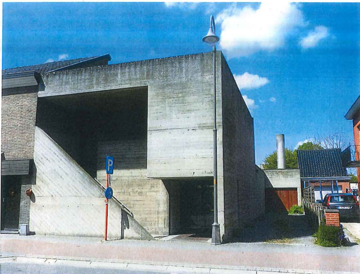
Foto 3: Voorgevel van de voormalige bibliotheek, met rechts de oprit naar de achterliggende garage.
