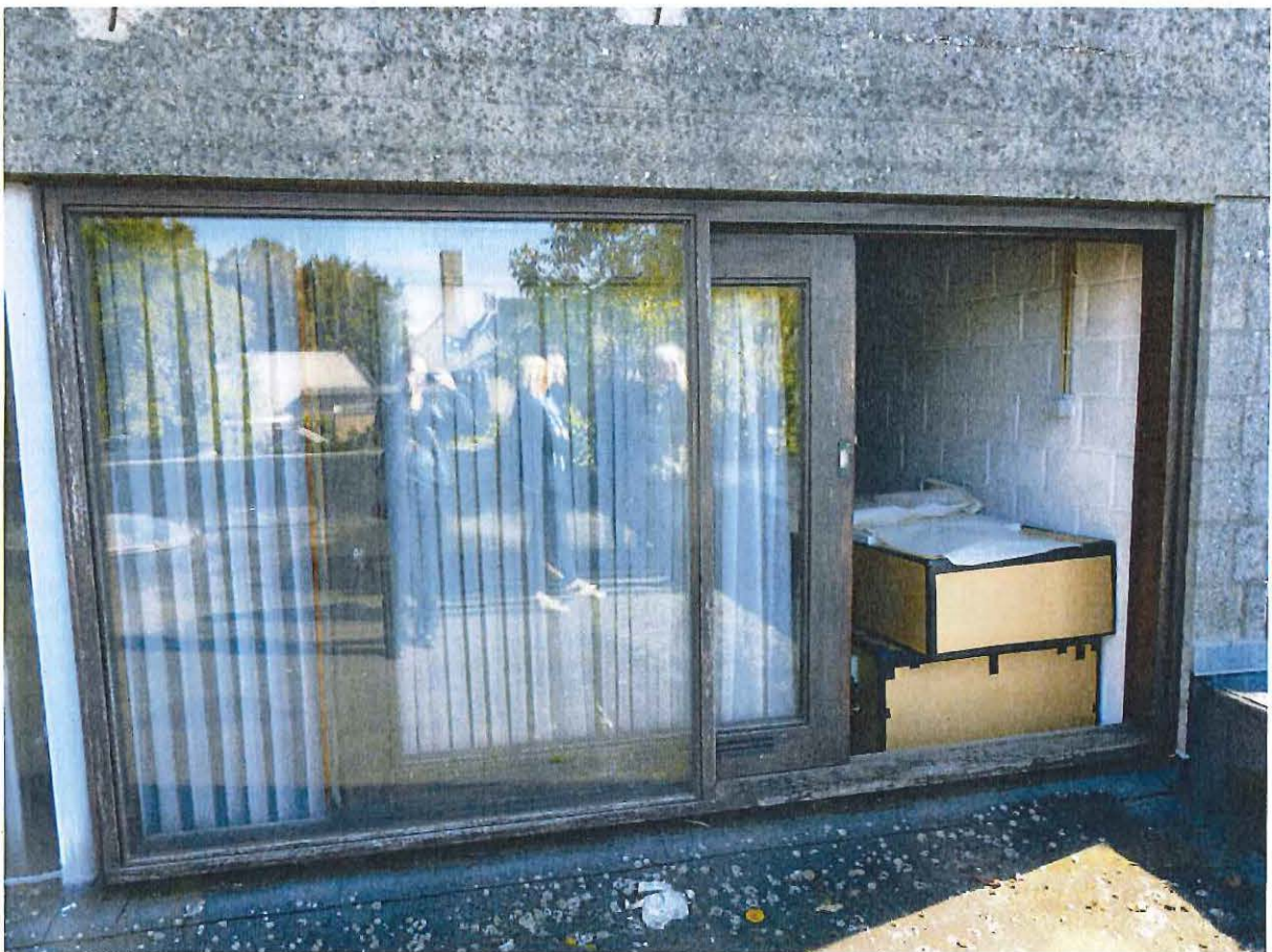
Foto 26: Achtergevel hoofdgebouw, eerste verdieping. Detail vensteropening met schuifraam.
