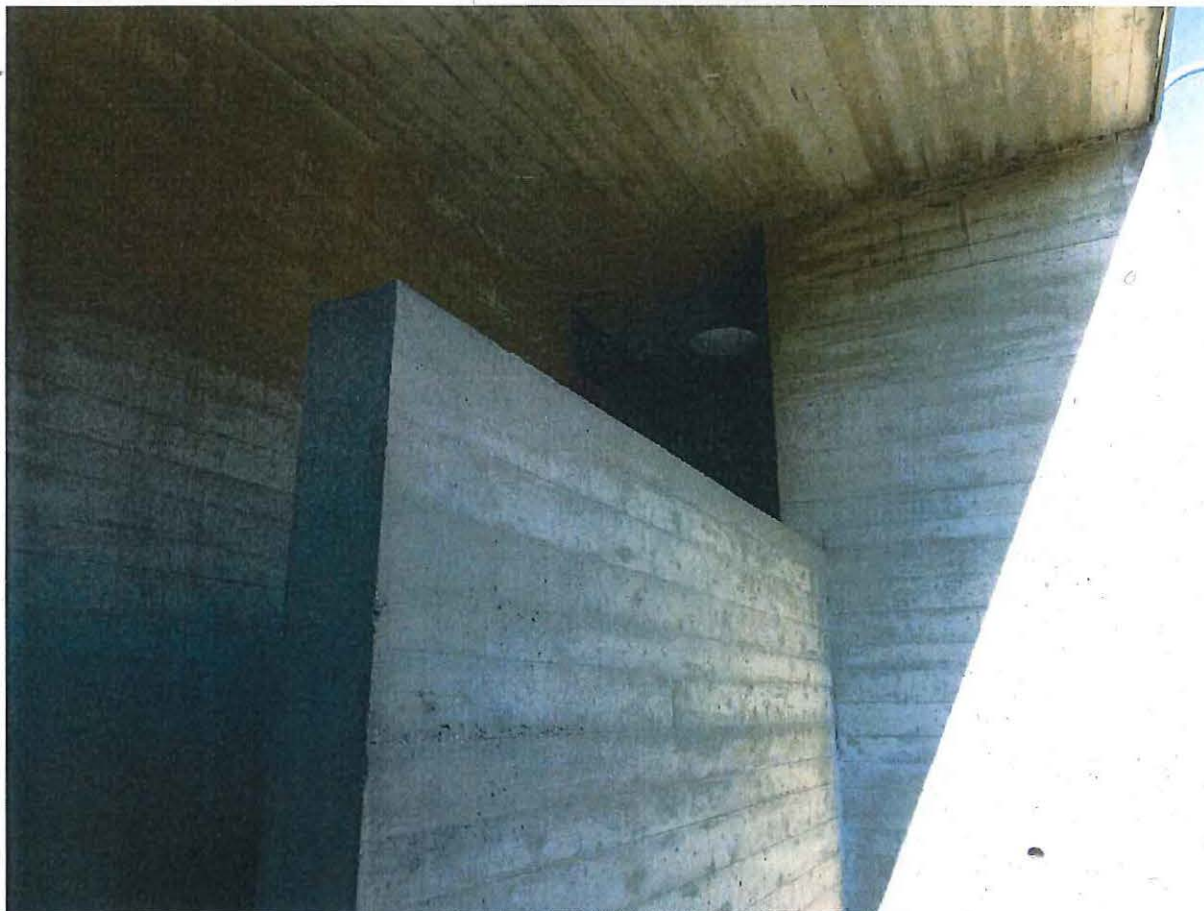
Foto 12: Voorgevel hoofdgebouw. Buitentrap, scheidingsmuur.
