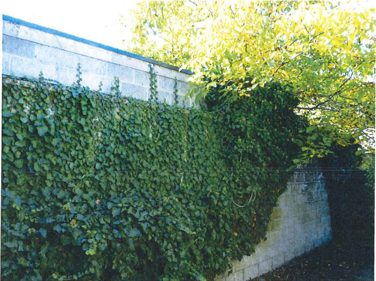
Foto 29: Binnentuin. Zicht op de linker zijgevel, begroeid met klimop.
