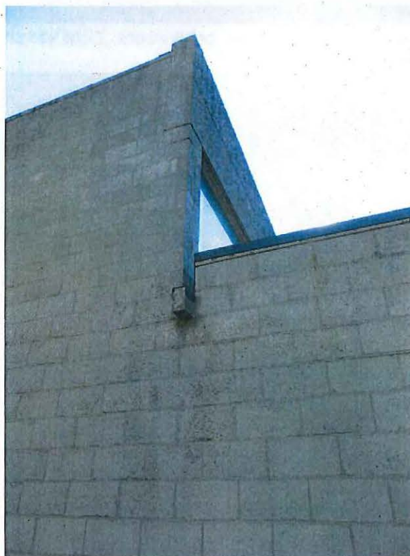
Foto 16: Rechter zijgevel hoofdgebouw. Detail van de overgang tussen de tweede bouwlaag en het platte dak.
