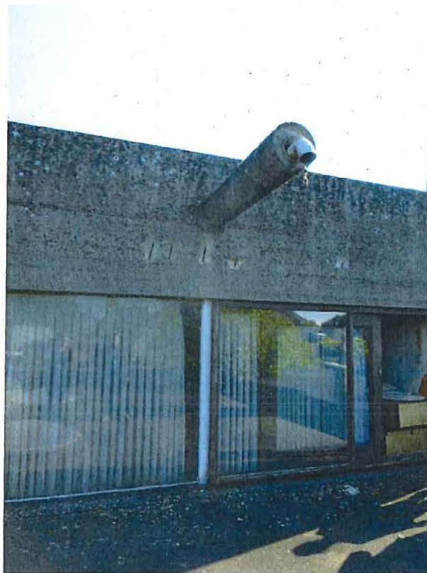
Foto 21: Achtergevel hoofdgebouw, eerste verdieping. Detail waterafvoer.
