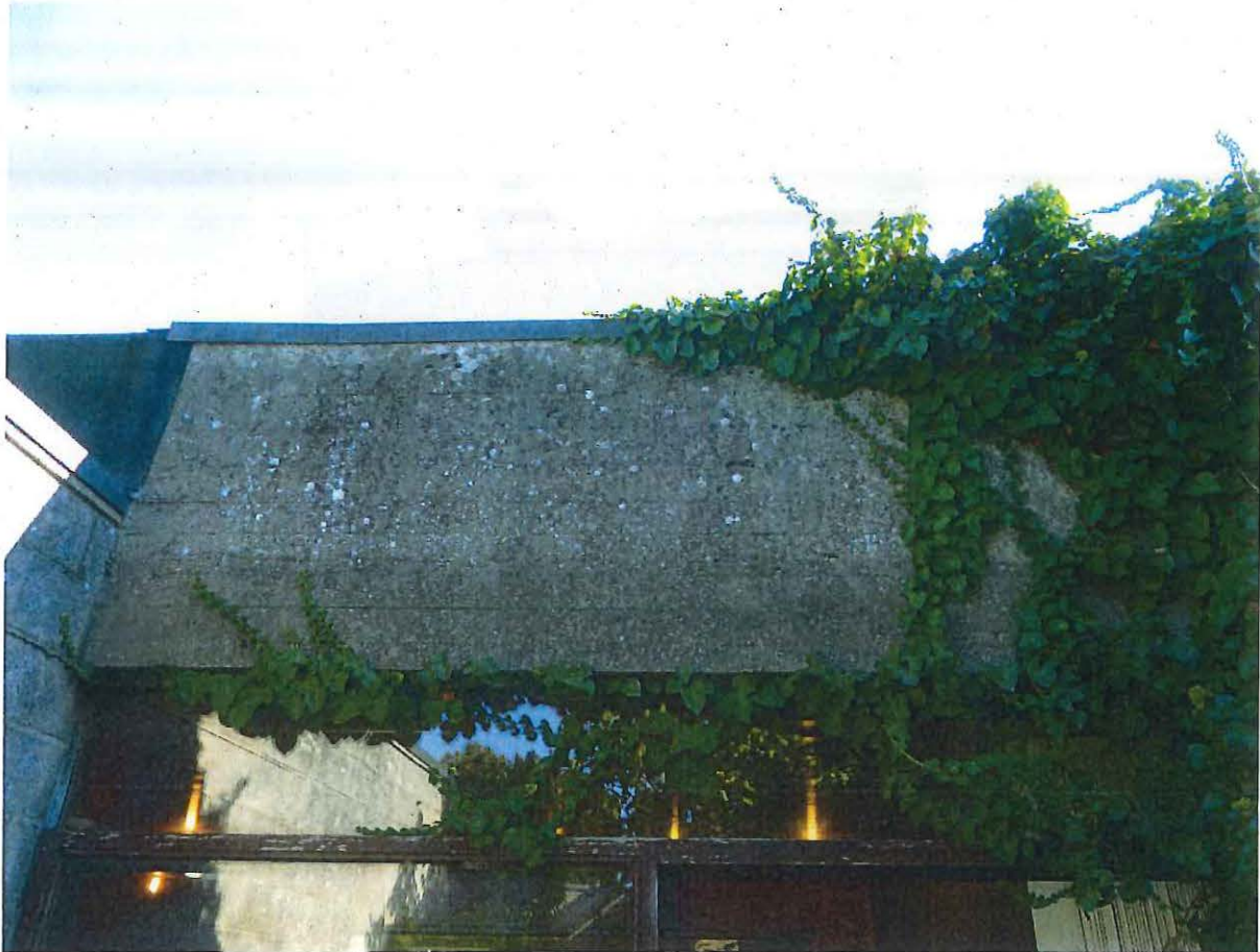
Foto 19: Achtergevel hoofdgebouw, gelijkvloers. Detail van de 'béton brut' boven de vensteropening tussen bibliotheek en de binnentuin.
