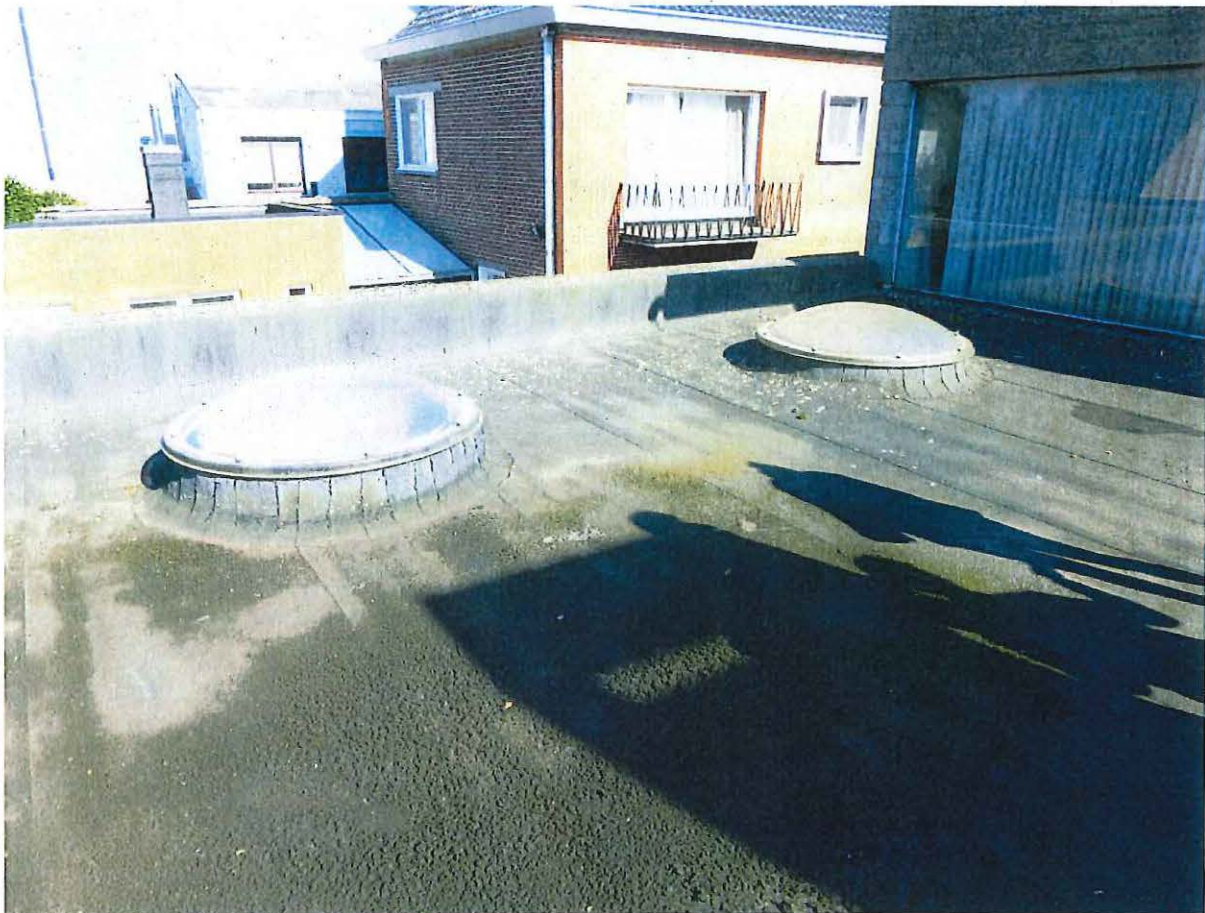
Foto 24: Platte dak hoofdgebouw. Zicht op twee van de vijf koepels die de bibliotheek verlichten.
