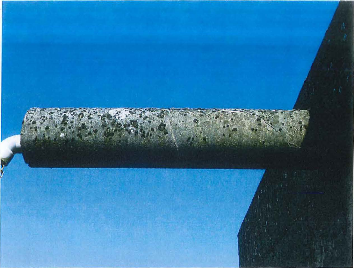
Foto 23: Achtergevel hoofdgebouw, eerste verdieping. Detail van de buis van de waterafvoer met barsten.
