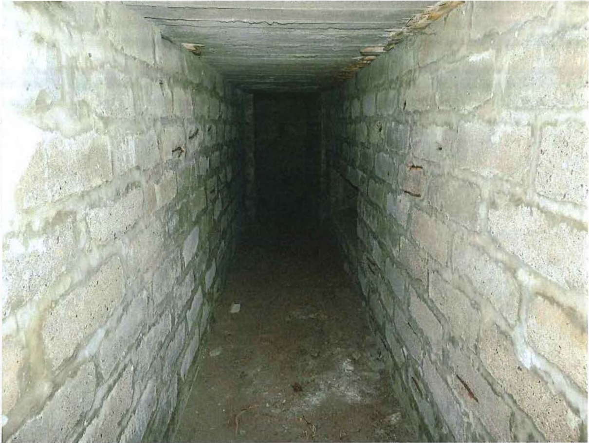
Foto 3: Een toegang tot de bunker via een lange gang
