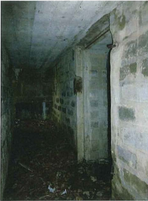
Foto 17: De gang van de bunker.
