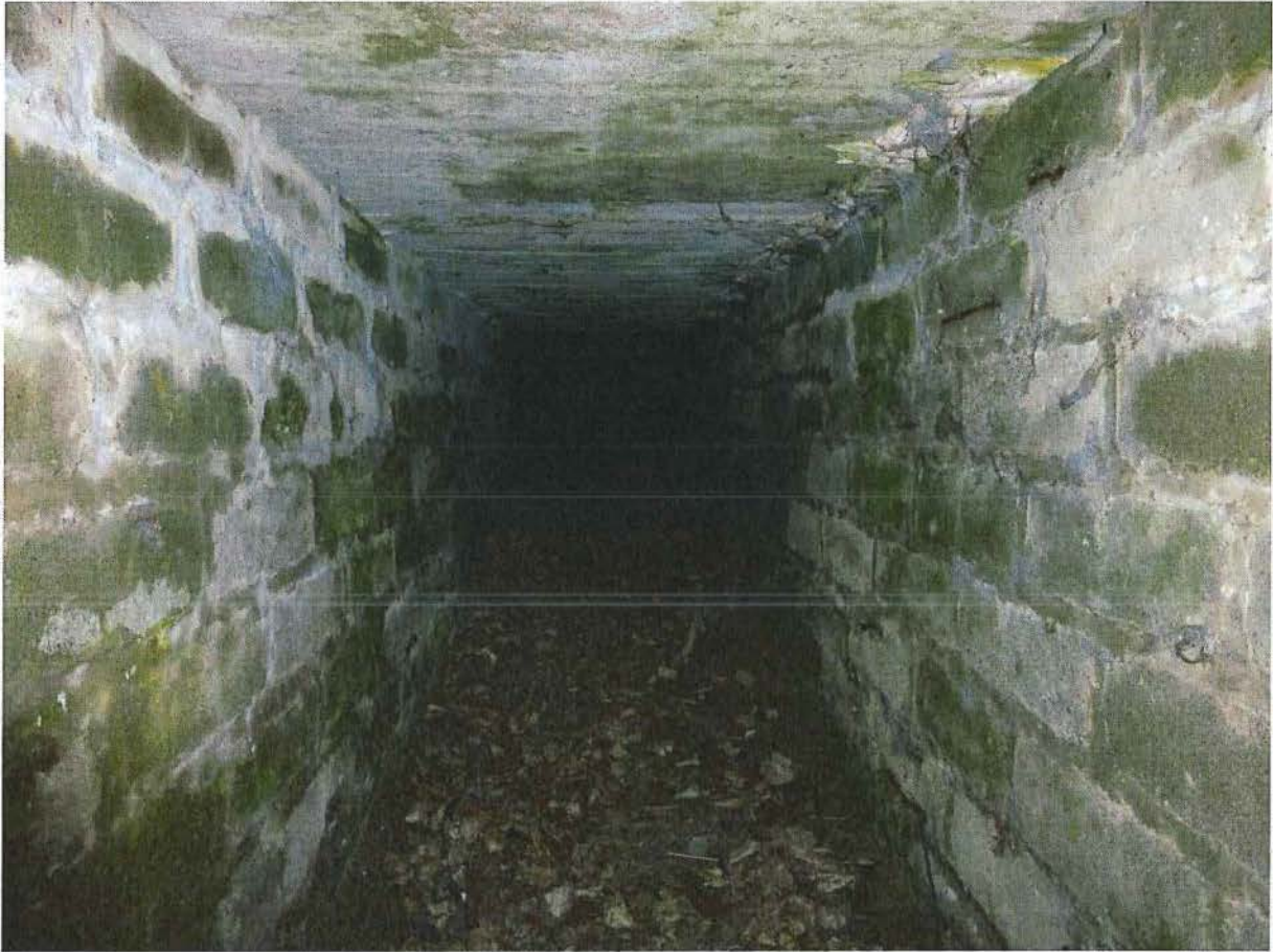
Foto 11: Eén van de twee lange toegangsgangen van bunker 2.
