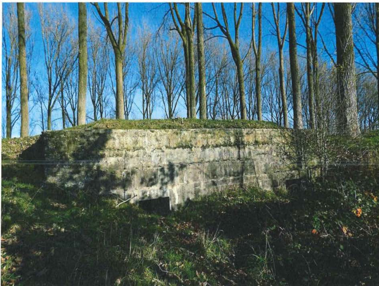
Foto 15: Toegangszijde van bunker 4.
