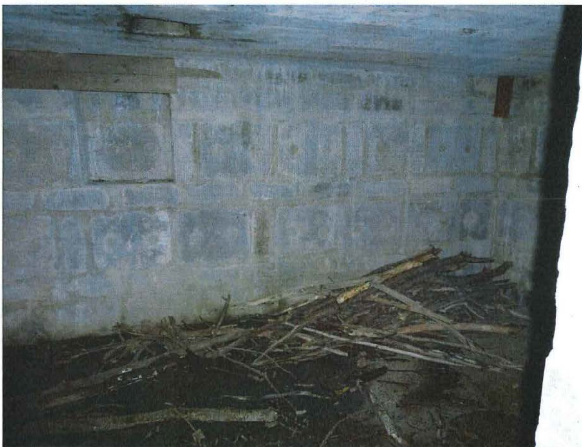
Foto 16: Zicht in de bunkerkamer, met een nis in de muur. Enkele lagen bunkerstenen zijn rechtop geplaatst.
