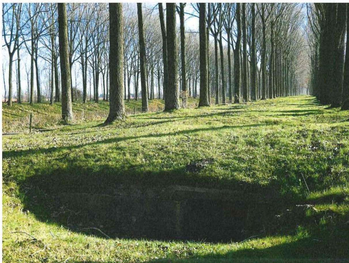
Foto 7: Zijtoegang van bunker 2.
