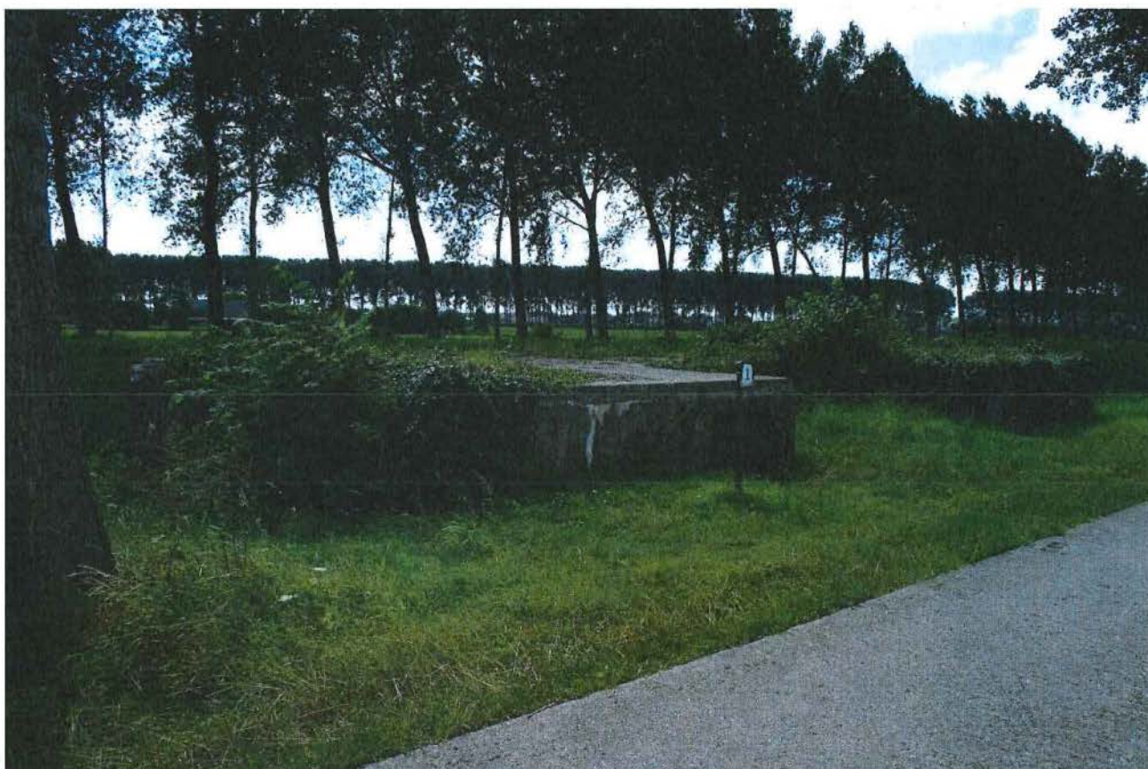
Foto 2: Zicht op de bunker vanaf de Vlotweg.
