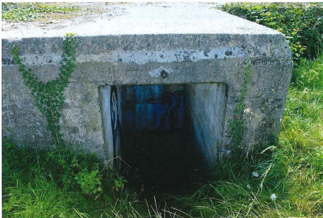
Foto 4: Toegang tot de bunker.
