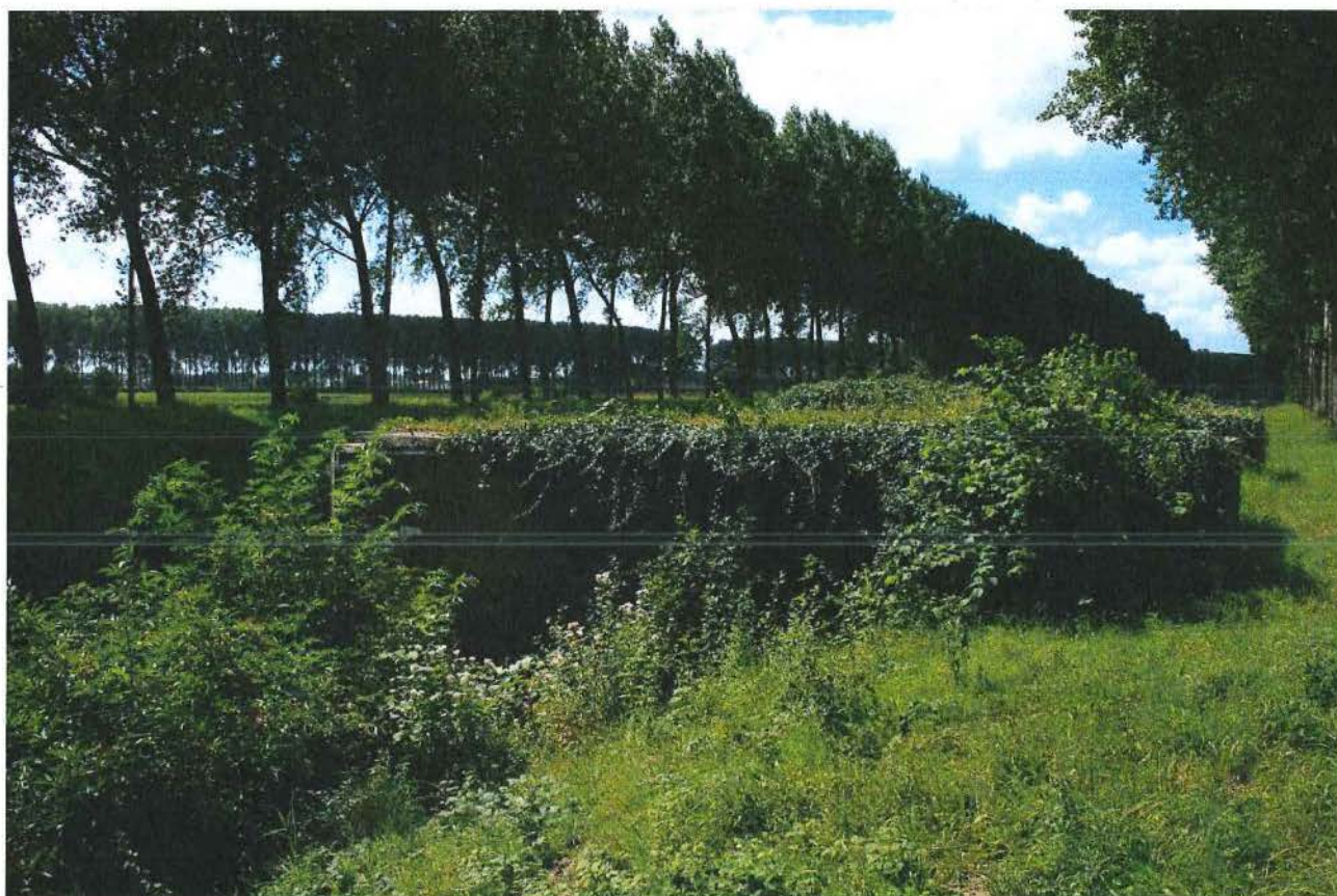
Foto 1: De flankerende bunker langs de Vlotweg.
