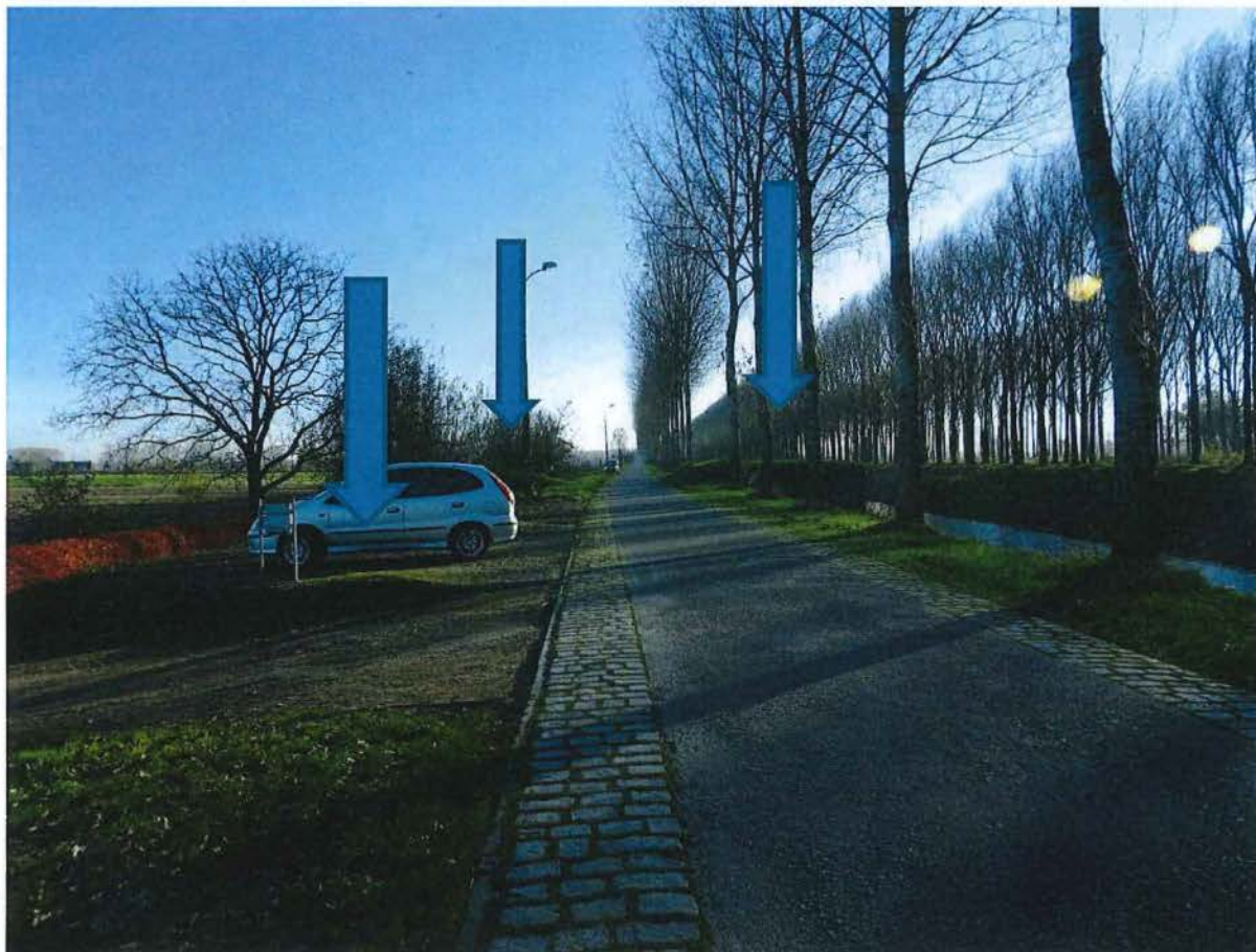
Foto 8: Ligging van de drie bunkers ter hoogte van Dijkstraat 33. Rechts aan de waterkant de flankerende mitrailleurspost, aan de andere kant van de dijk de observatiepost en links vooraan de kleinere bunker.
