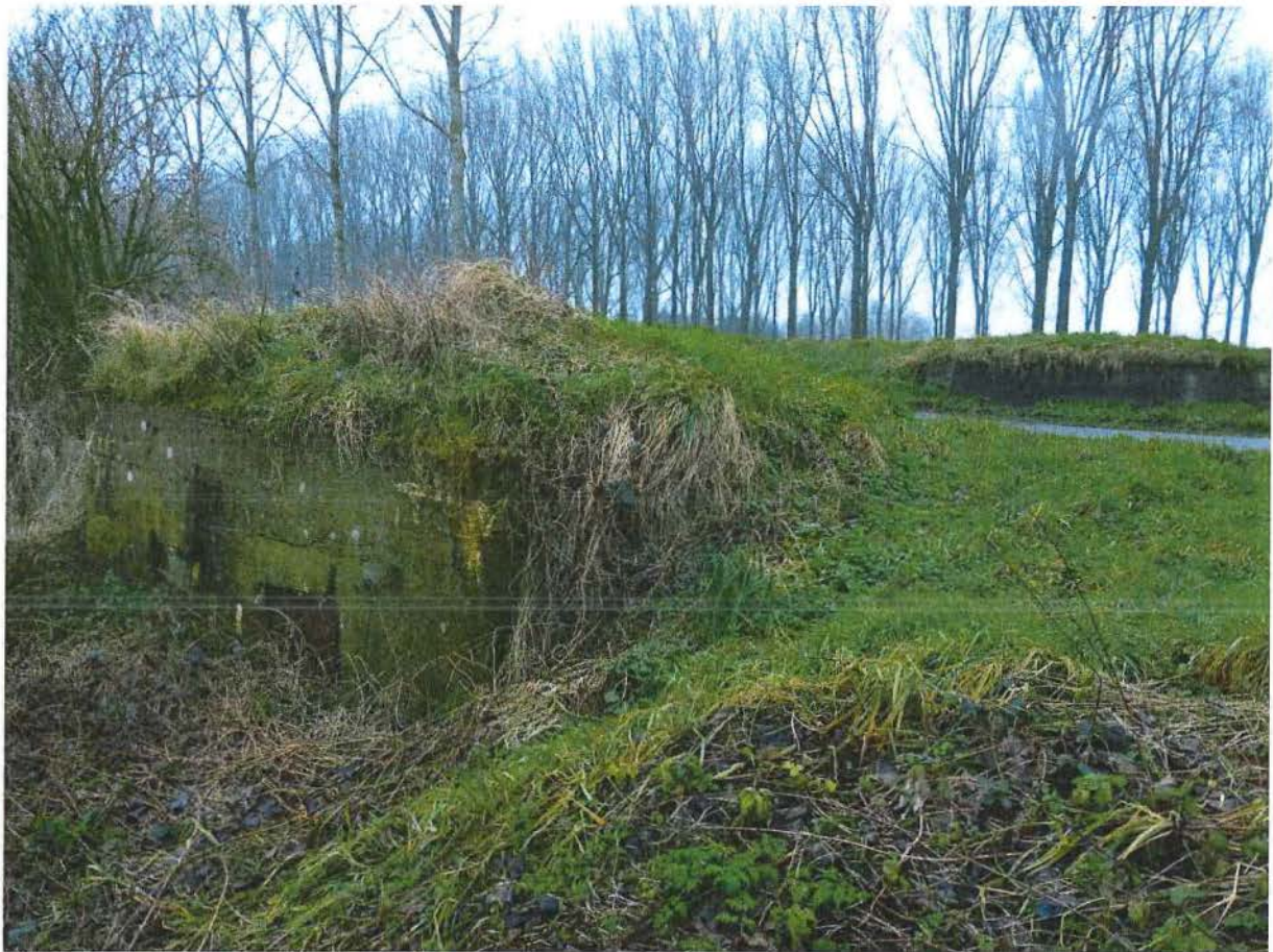
Foto 13: De observatiepost tegenover de flankerende bunker.
