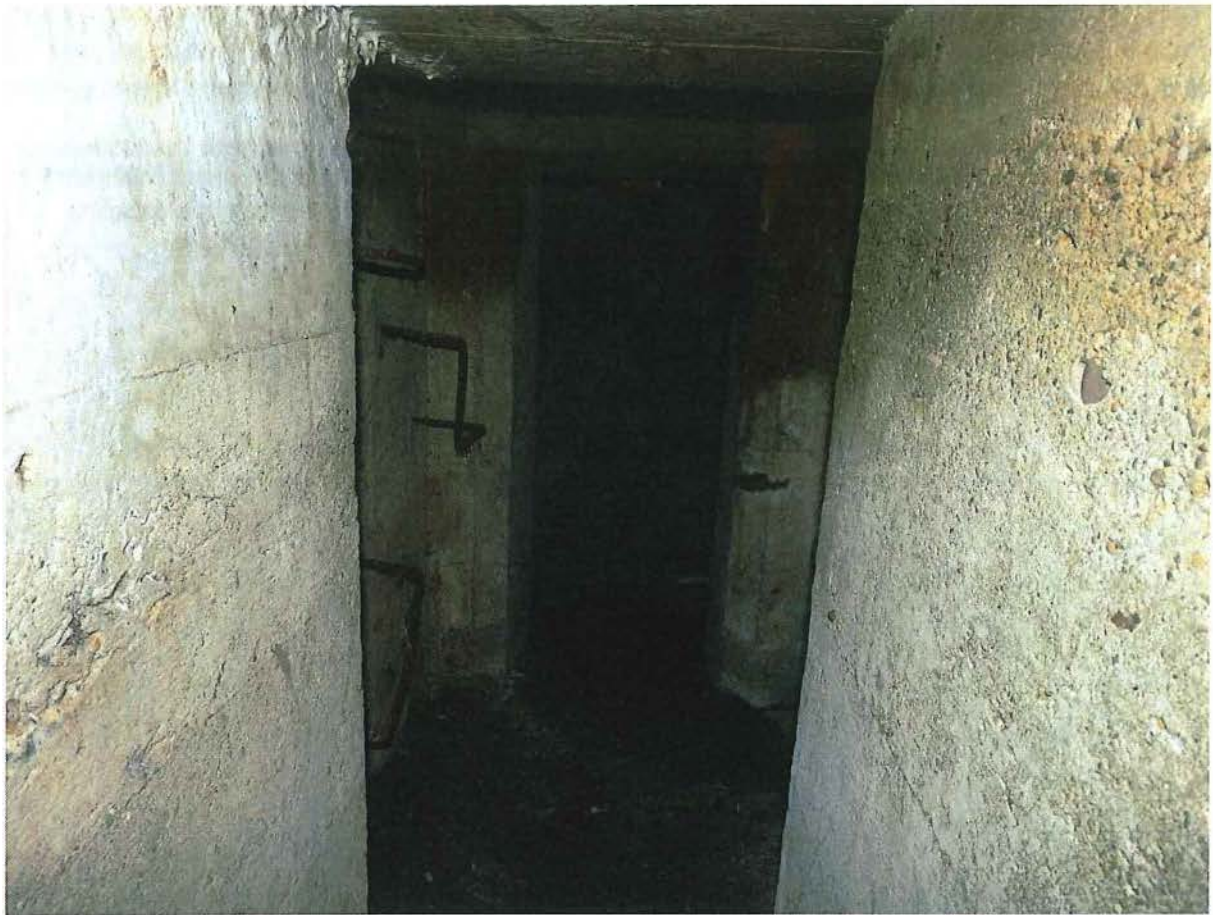
Foto 15: Zicht in de observatiepost. Er zijn nog vele ijzeren elementen bewaard. In het dak zit het typische vierkante mangat.
