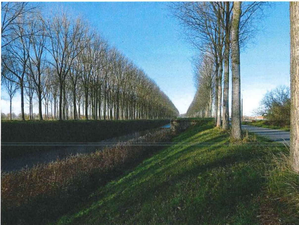
Foto 9: De flankerende bunker langs het Leopoldkanaal, ter hoogte van Dijkstraat 33.
