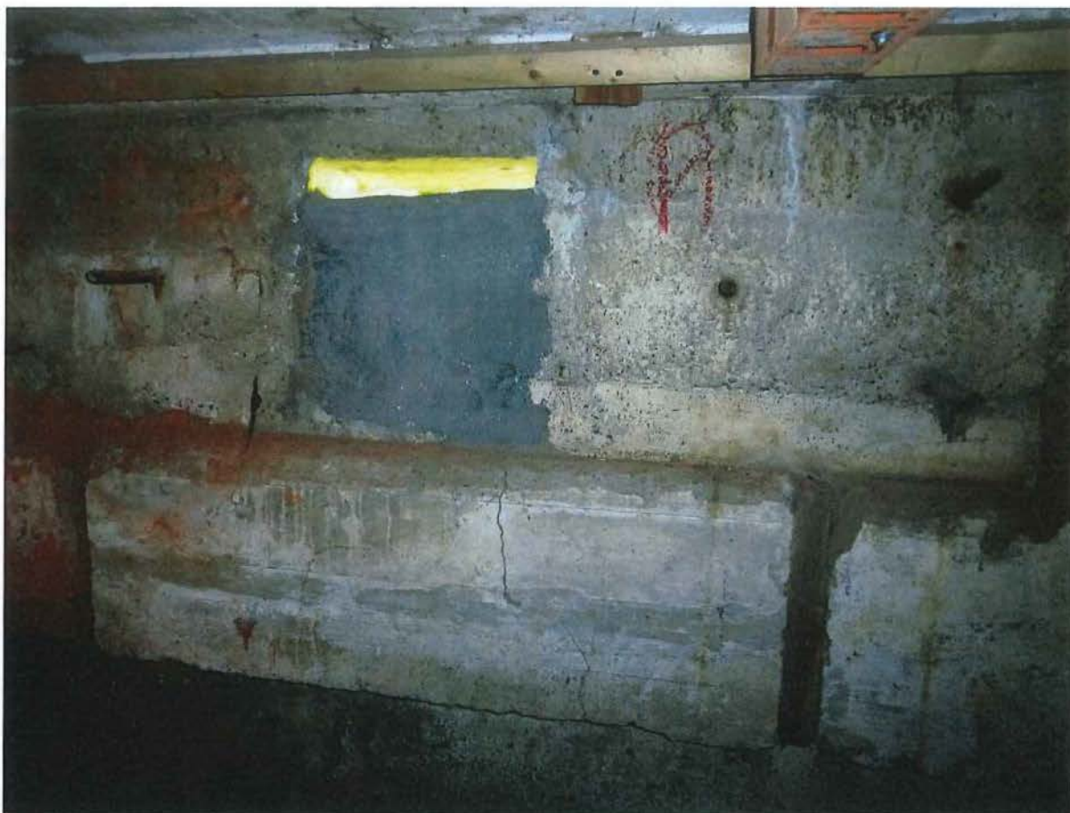
Foto 7: De schietopening aan oostelijke zijde is grotendeels dichtgemaakt.
