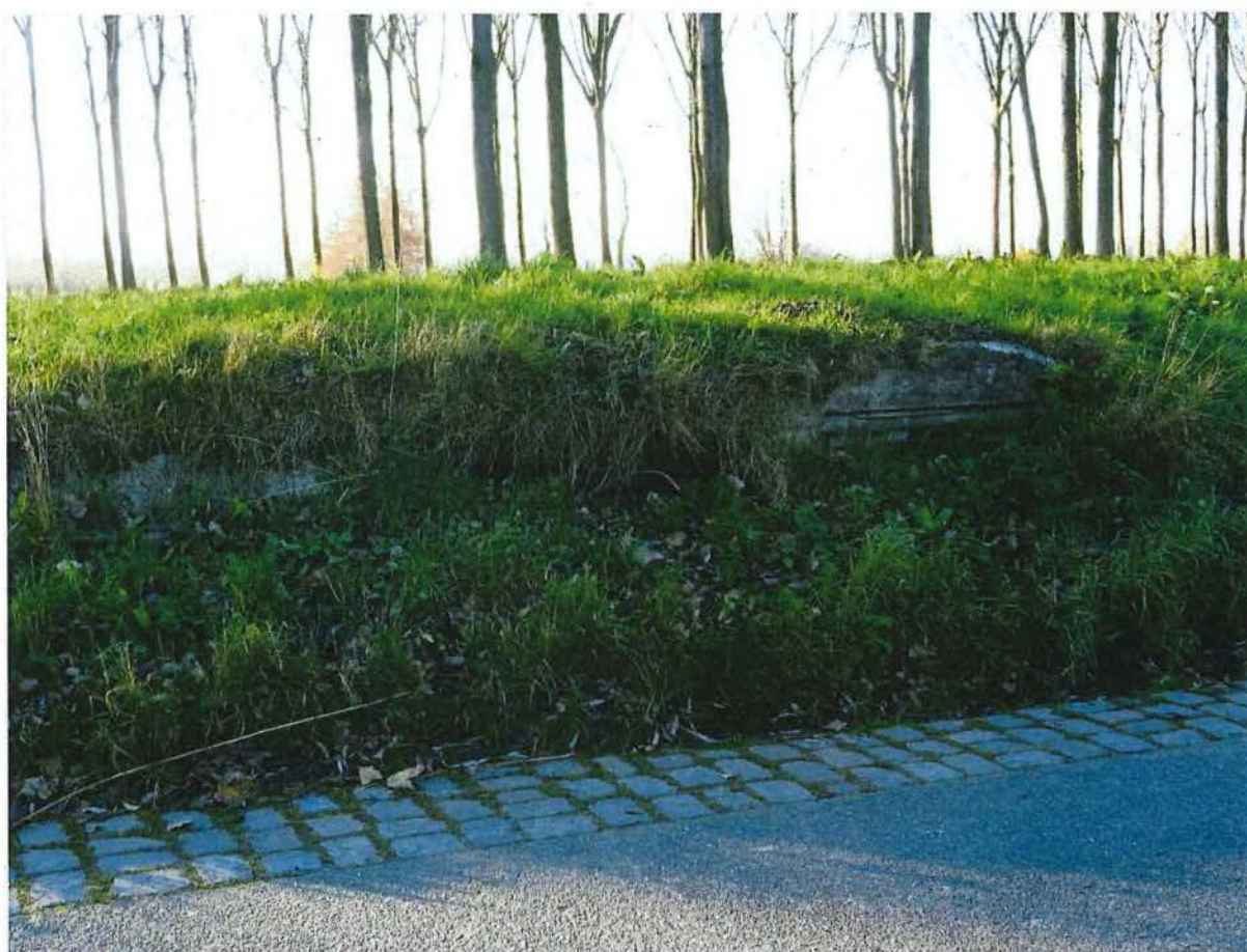
Foto 12: De toegangszijde van de flankerende bunker ter hoogte van Dijkstraat 33.
