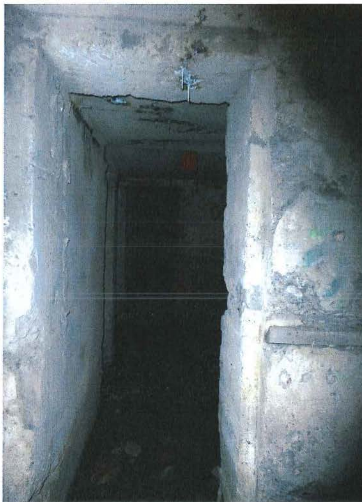
Foto 5: Zicht in de bunker
