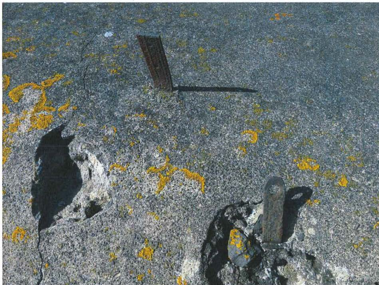
Foto 6: Bunker 2: Op het dak en tegen de dakrand zitten ijzers met ronde openingen.
