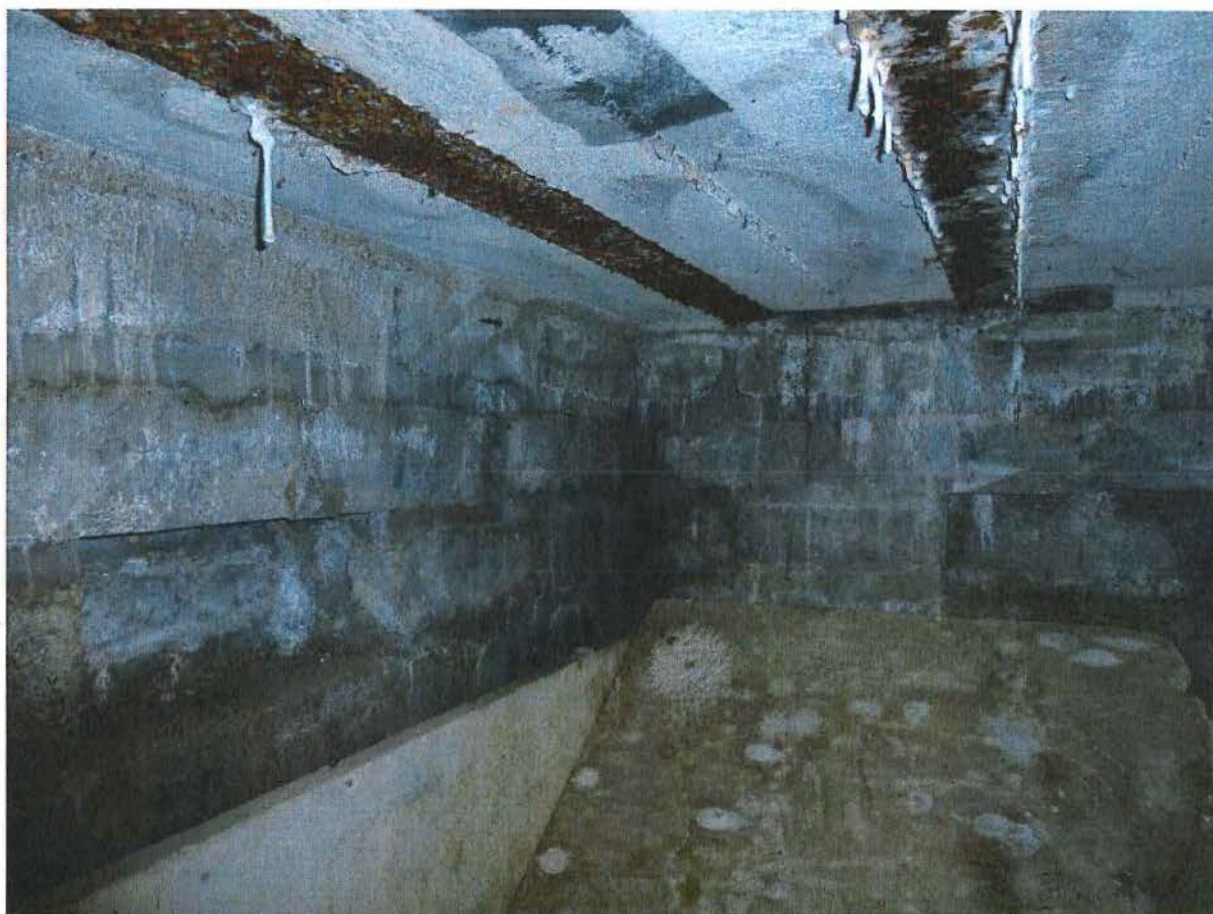
Foto 2: Bunker 1: interieur. In de binnenmuren zijn nissen gecreëerd door het weglaten van betonstenen.
