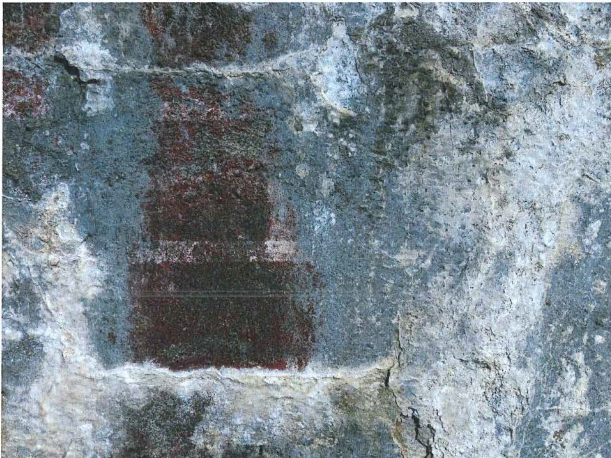
Foto 5: Bunker 2: . Op de buitenmuren zijn verfsporen van een rood baksteenmotief terug te vinden.
