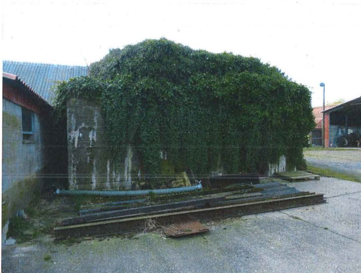
Foto 1: Bunker 1: zicht op westelijke zijde.
