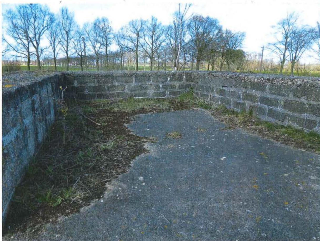
Foto 11: Bunker 3: borstwering op het dak.
