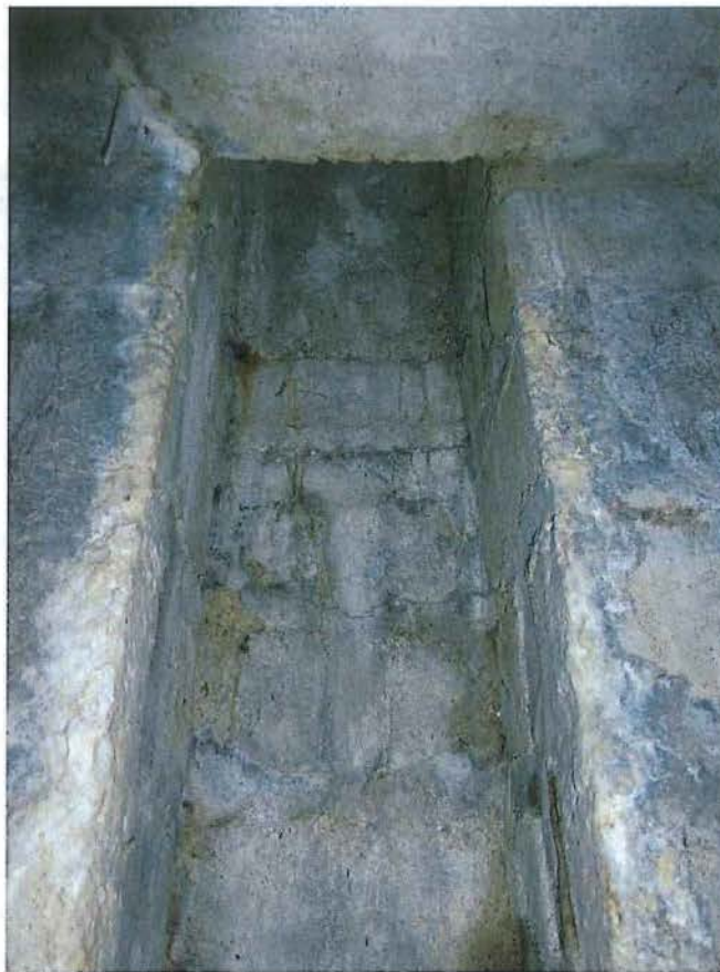
Foto 3: Bunker 1: Gleuf in zijmuur, vanaf grond tot doorheen plafond.
