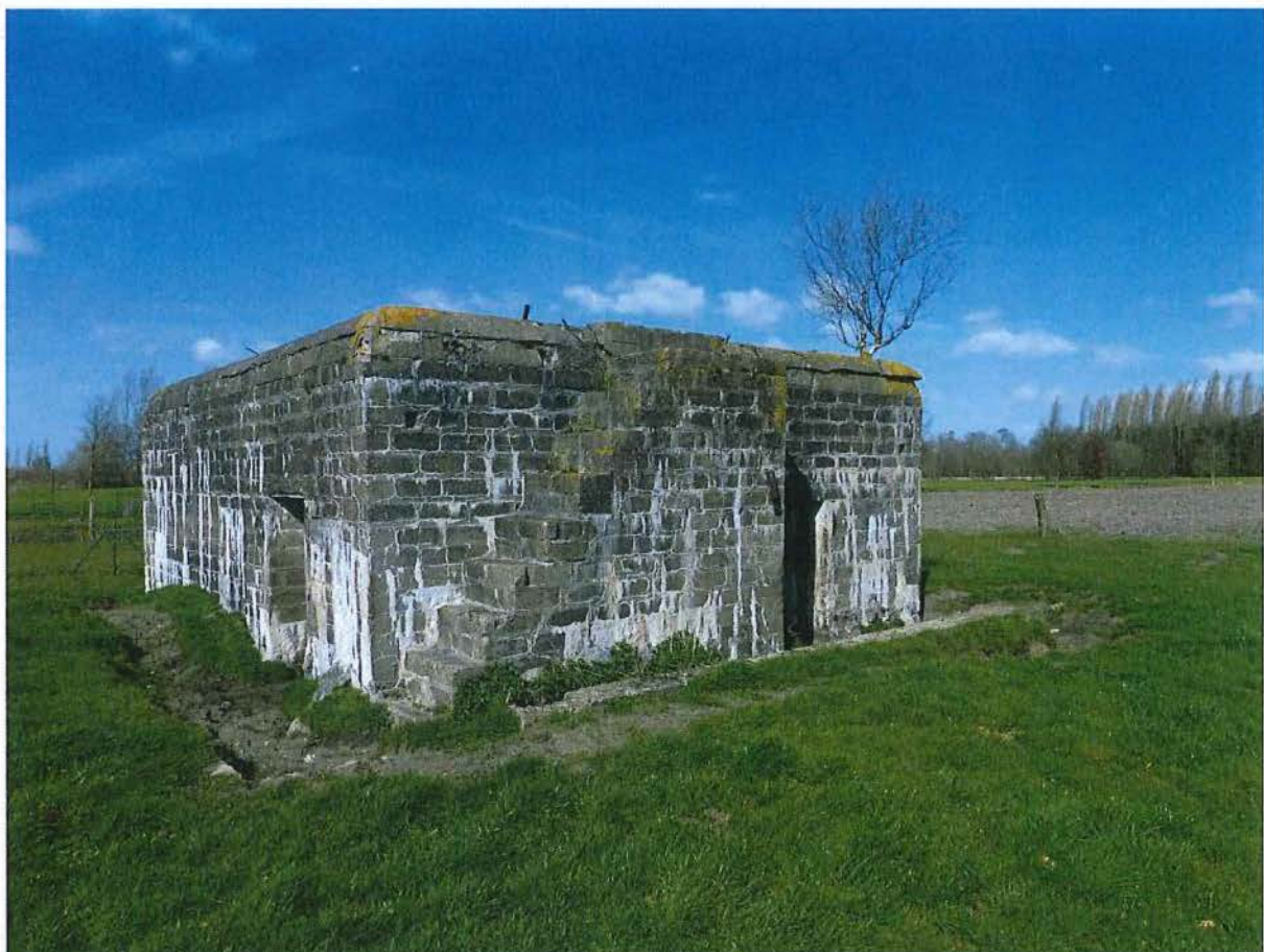
Foto 4: Bunker 2, met een afgebakend looppad ter hoogte van de toegangen. Op het dak zijn er geen sporen van een borstwering.
