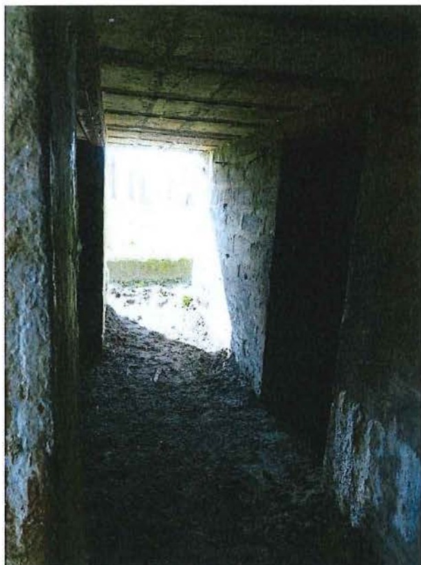
Foto 8: Bunker 2: de L-vormige gang.
