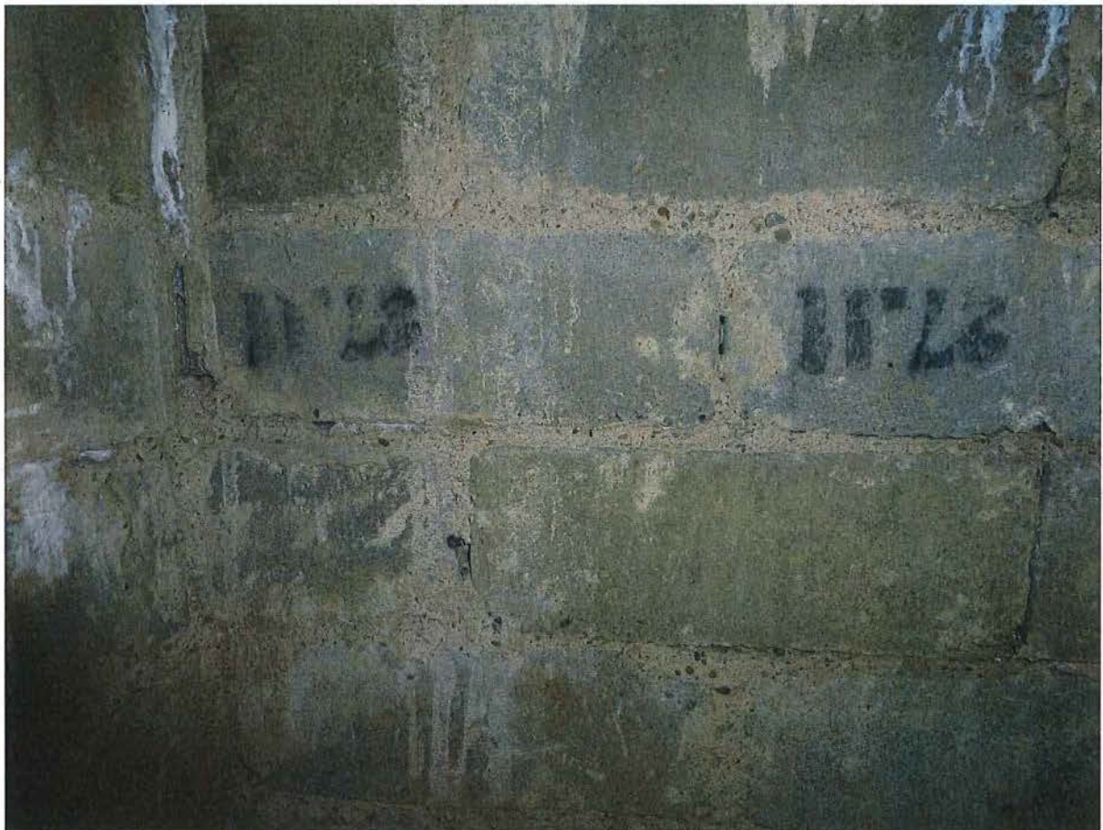
Foto 4: Bunker 1: enkele betonstenen zijn genummerd.
