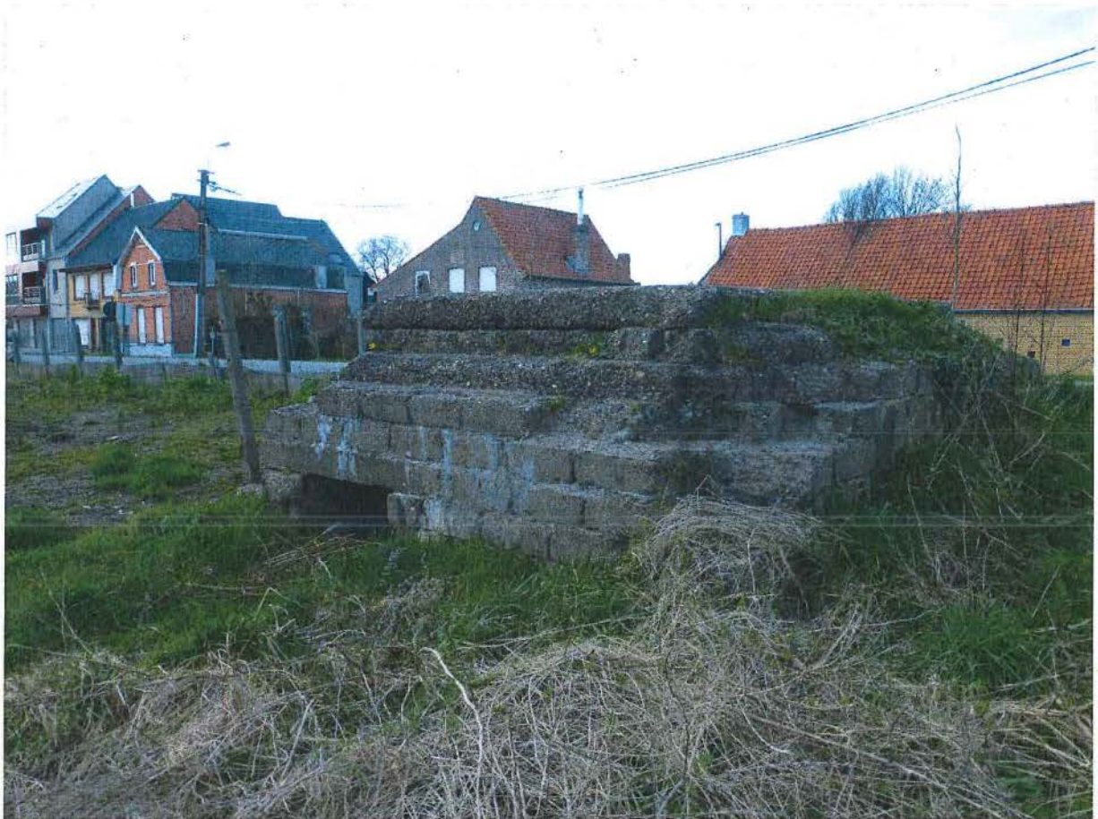
Foto 5: Bunker 2, gelegen langs de Groenendijk.
