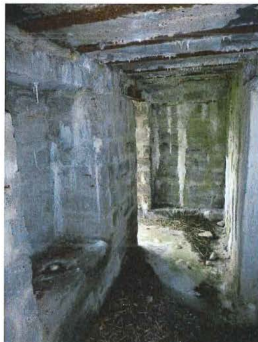
Foto 40: Bunker 10: gang met nissen
