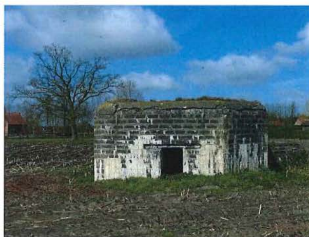
Foto 70: Bunker 20: vanaf zuidoostelijke zijde
