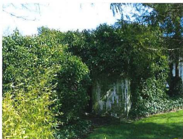
Foto 69: Bunker 19: zicht op westelijke toegang en borstwering
