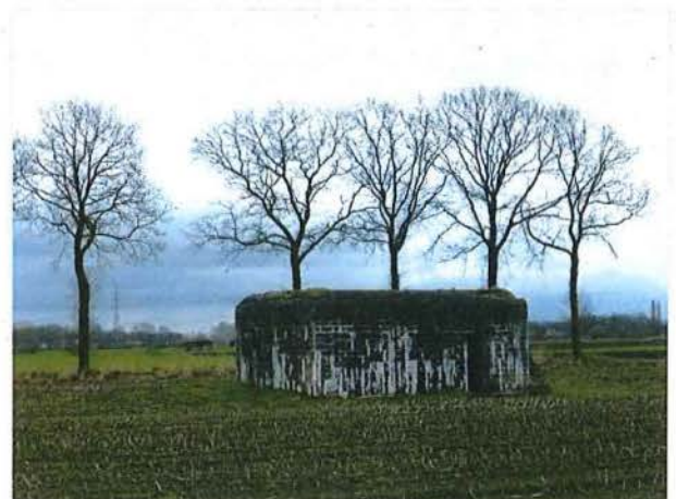
Foto 24: Bunker 6: westelijke zijde
