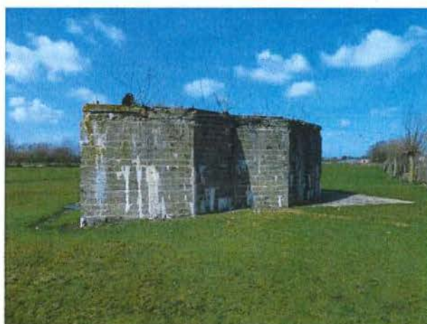
Foto 54: Bunker 15: zicht vanuit zuidoostelijke hoek
