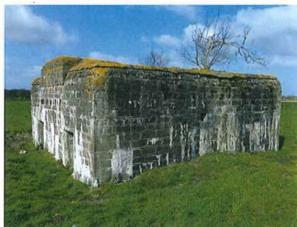
Foto 58: Bunker 16: zicht vanuit zuidoostelijke hoek
