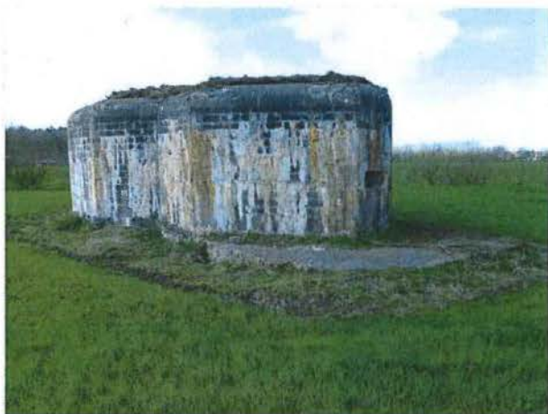
Foto 66: Bunker 18: zicht vanuit zuidoostelijke hoek
