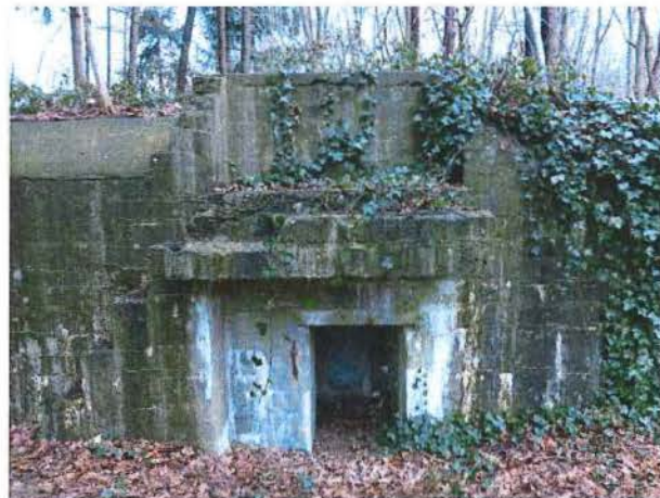
Foto 2: Bunker 1: luifel, borstwering, betonnen trap
