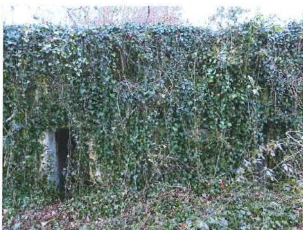
Foto 37: Bunker 9: achterzijde van de bunker
