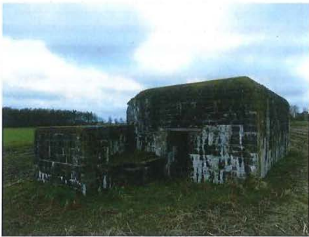
Foto 19: Bunker 5: zuidelijke zijde met borstwering
