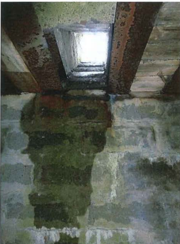
Foto 21: Bunker 5: opening voor seinlamp aan oostelijke zijde
