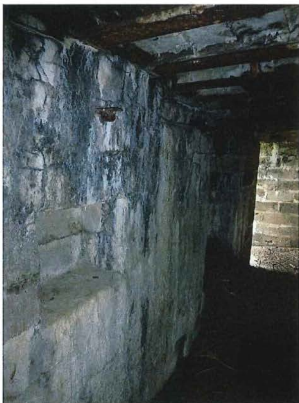
Foto 11: Bunker 3: gang met nissen en ijzeren haken
