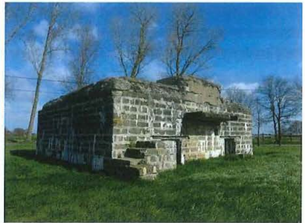
Foto 44: Bunker 11: zuidelijke zijde met aanzet tot trap, luifel en verhoogde dakrand
