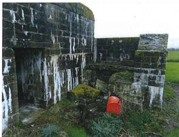
Foto 9: Bunker 3: zuidelijke borstwering
