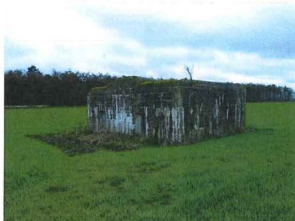
Foto 14: Bunker 4: zuidelijke en oostelijke zijde
