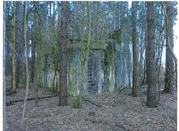
Foto 48: Bunker 13: vanuit oostelijke hoek
