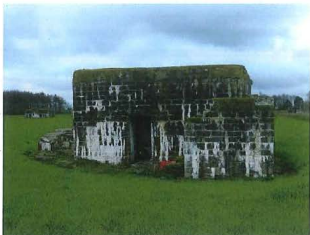
Foto 7: Bunker 3: zuidelijke zijde
