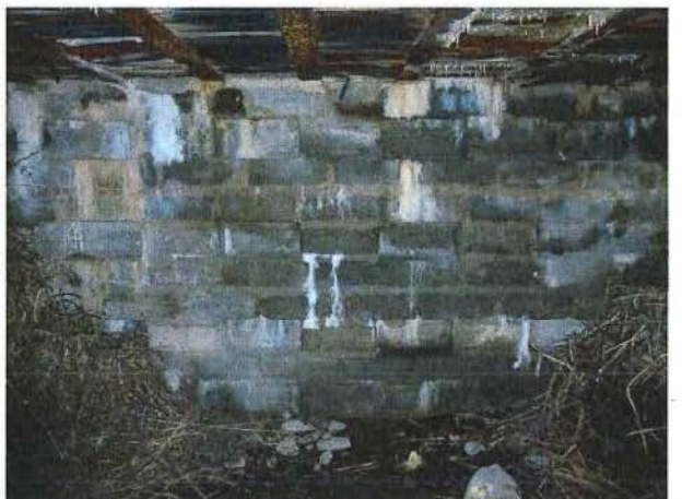
Foto 30: Bunker 7: binnenruimte met nissen
