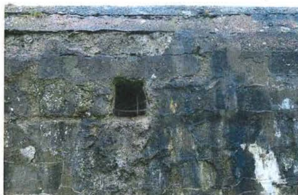
Foto 16: Bunker 4: muuropening met ijzeren rooster afgesloten
