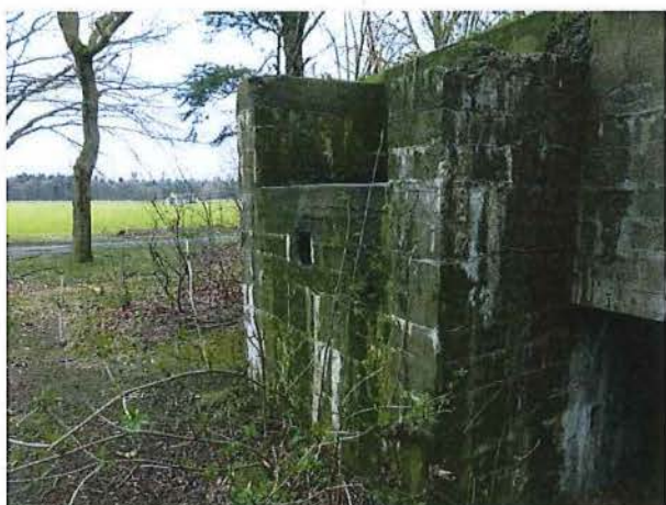
Foto 35: Bunker 8: uitspringend platform aan zuidoostelijke zijde
