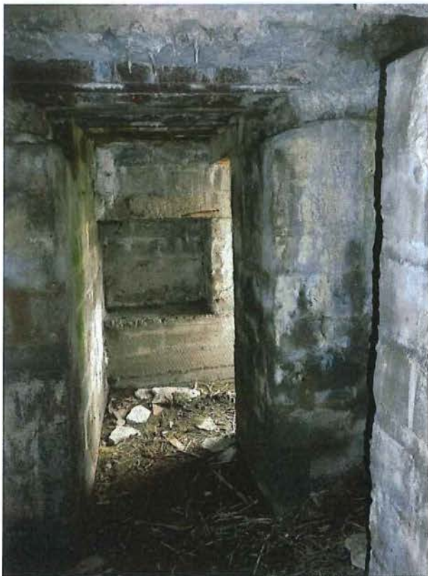
Foto 31: Bunker 7: gang met nissen
