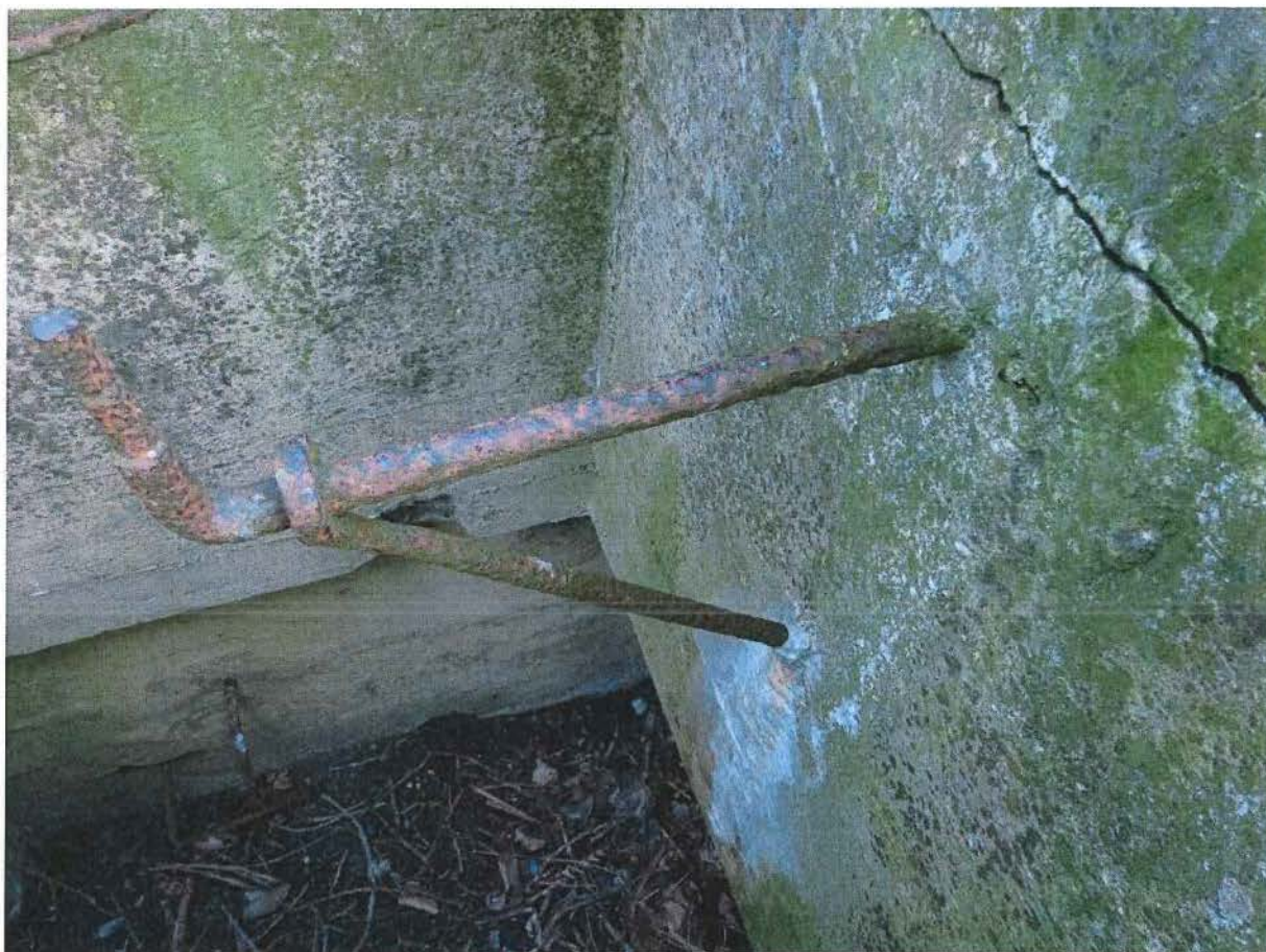
Foto 22: IJzeren haak voor bevestiging waarnemingsapparatuur.
