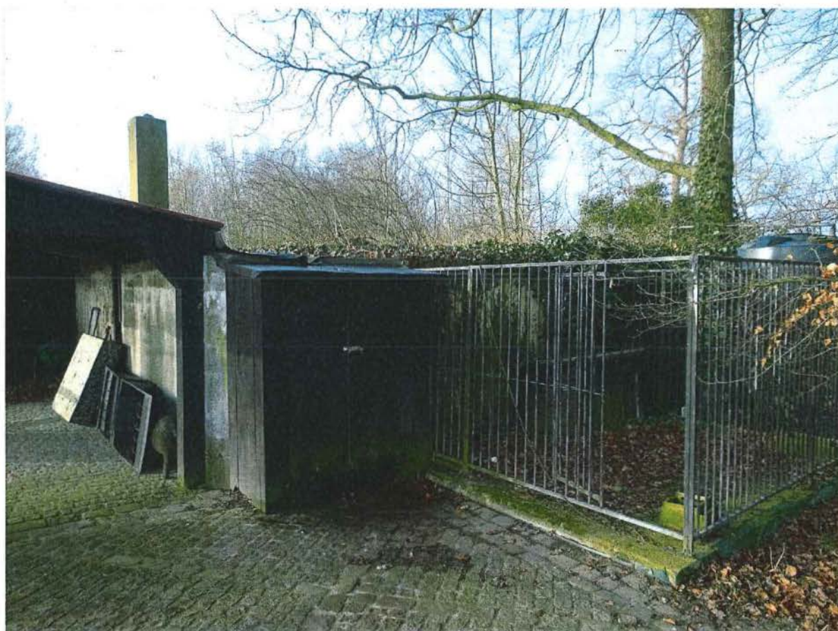
Foto 2: Het manschappenverblijf vanaf noordelijke zijde.
