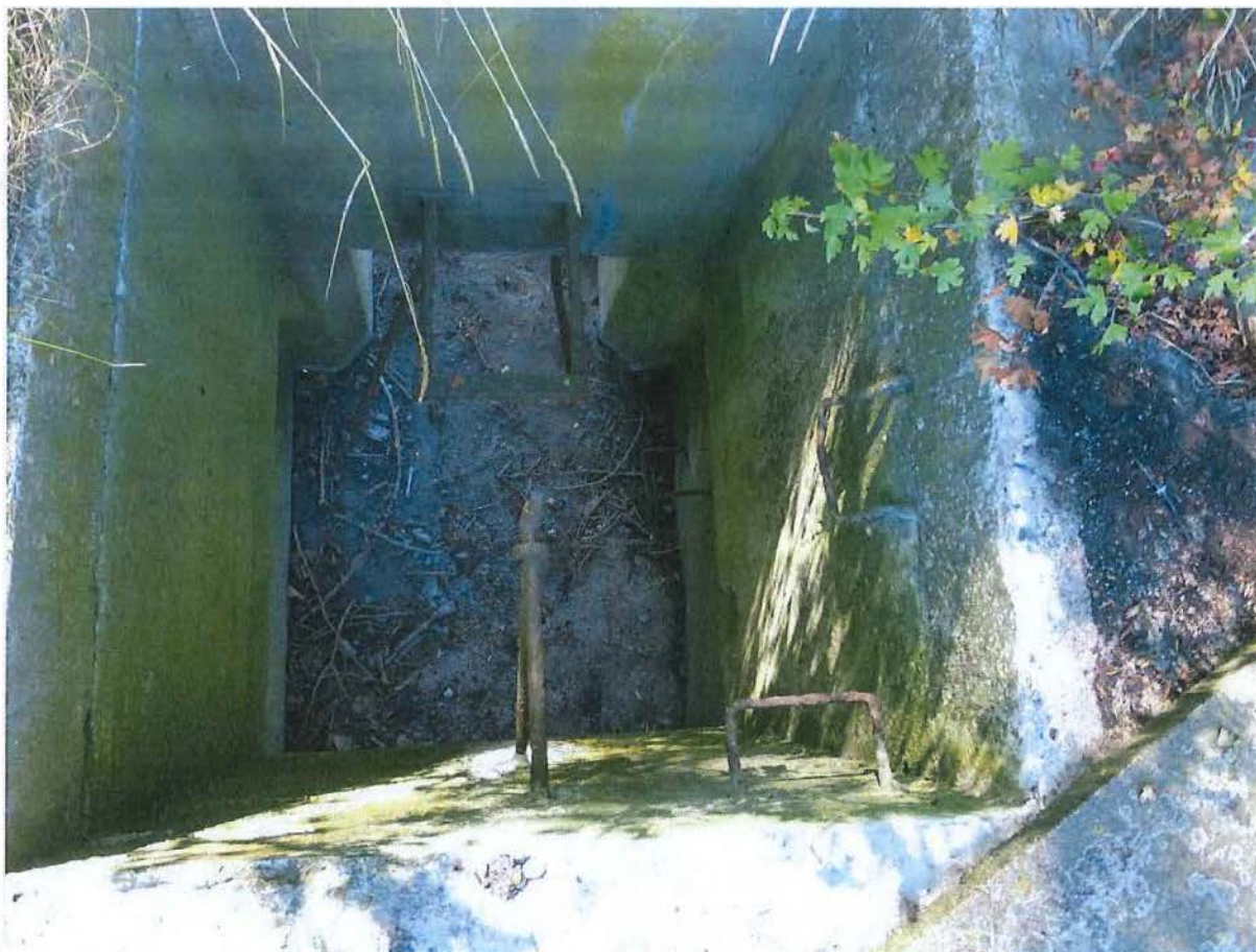
Foto 20: Eén van de twee vierkante mangaten in het dak, met ijzeren elementen.
