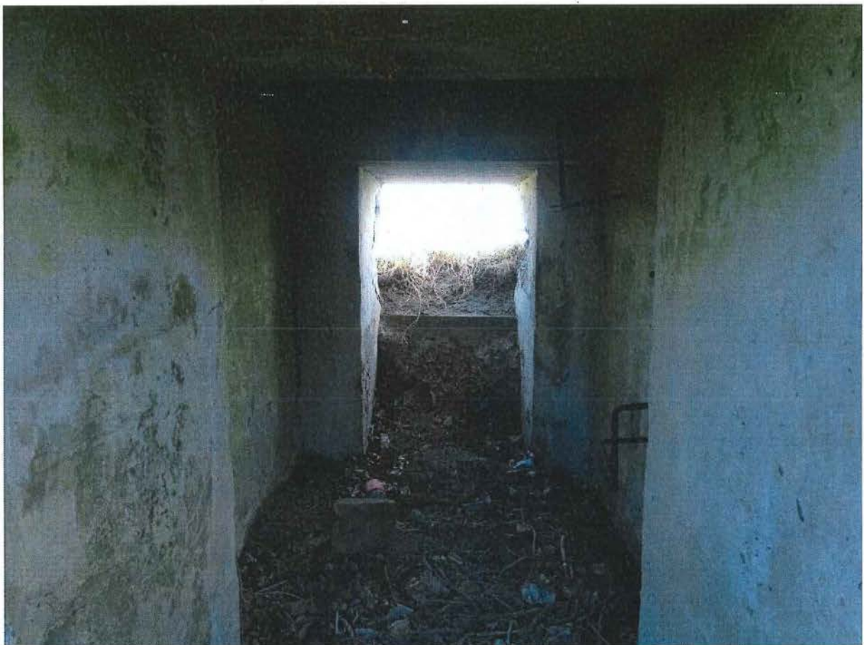
Foto 19: Eén van de twee kleine ruimtes, met onder meer (restanten van) klimijzers.
