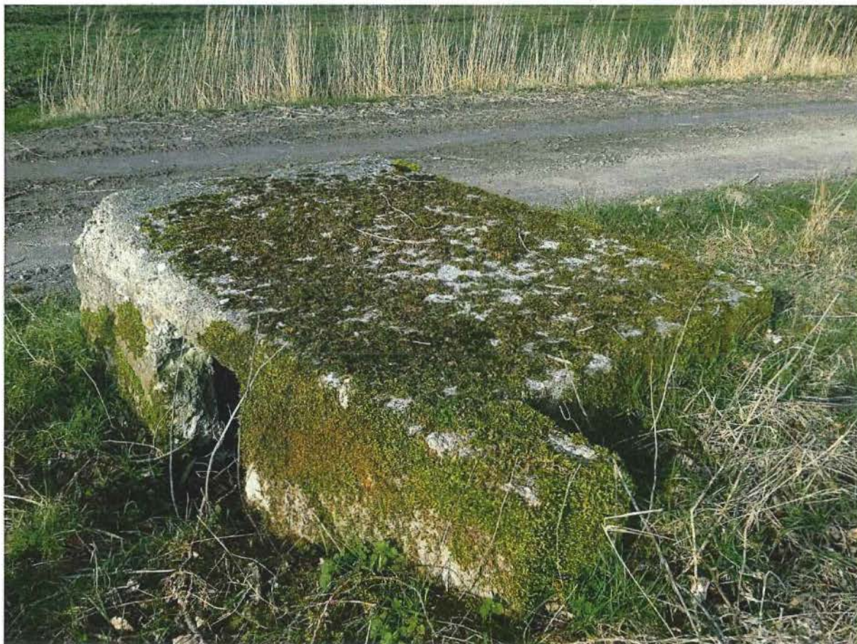
Foto 15: Zicht op het kleine betonnen postje.
