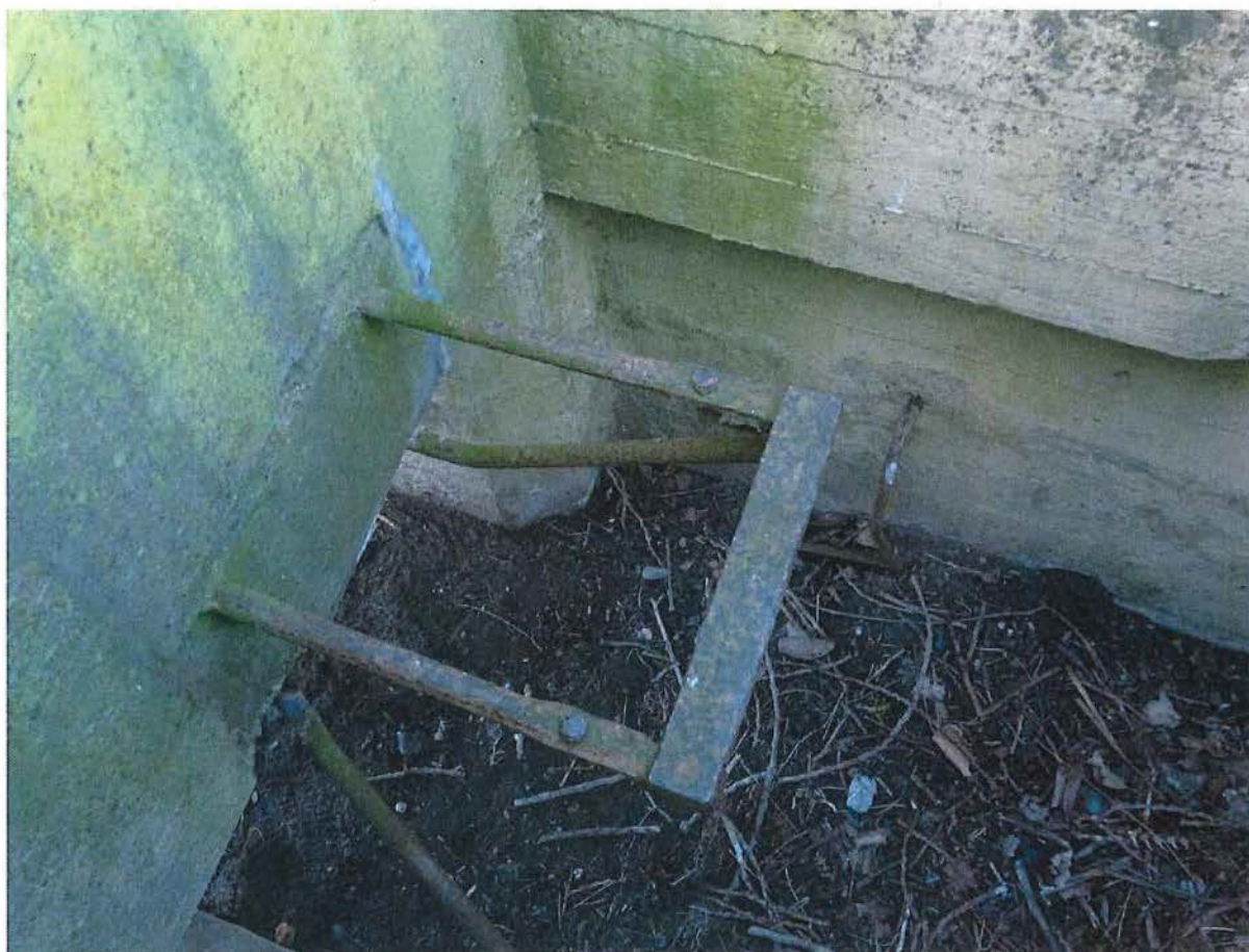
Foto 21: IJzeren onderstel voor stoel waarnemer.
