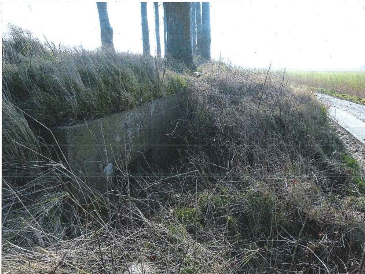
Foto 1: Zicht op de toegang van de mitrailleurspost aan de westelijke kant van de dijk.
