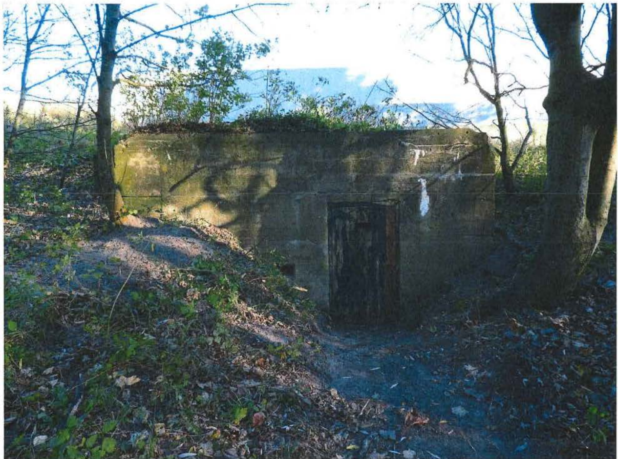
Foto 2: Zicht op de toegang tot de bunker vanaf zuidwestelijke zijde.
