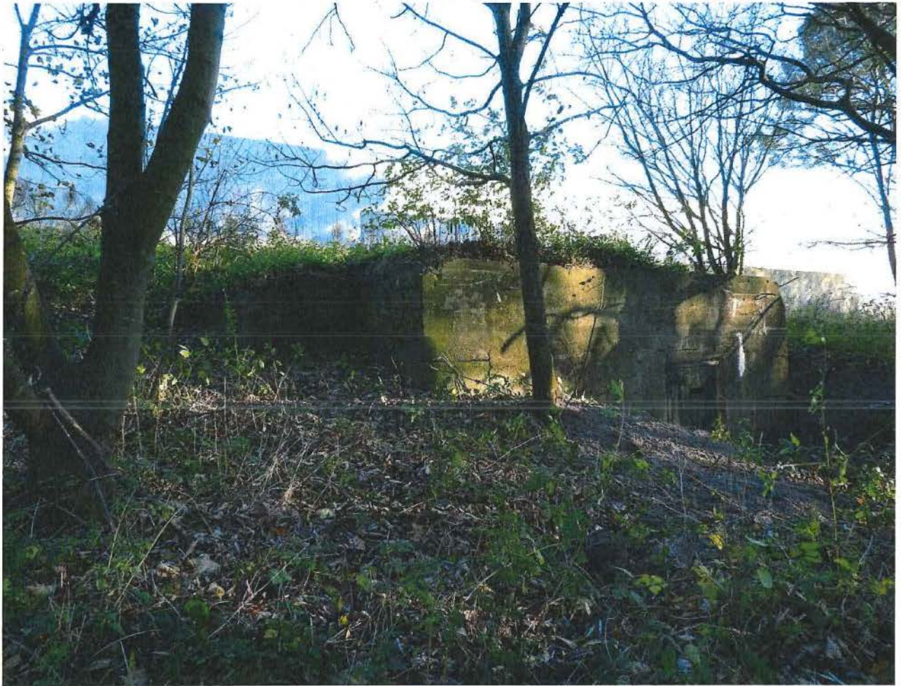
Foto 1: Zicht op de bunker vanaf westelijke zijde.
