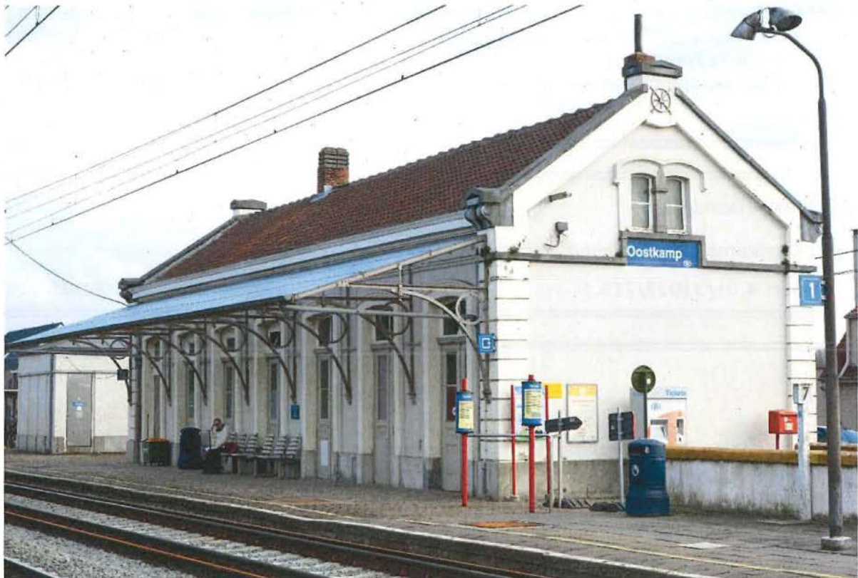
1. Stationsgebouw met luifel, zicht op spoorgevel en zijgevel, 28/03/2017
