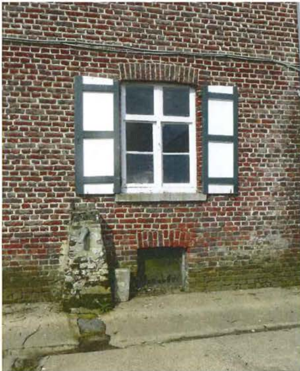
Foto 15: achtergevel van het herbergvolume met pomp, keldervenster met diefijzers en opkamervenster (plaatsbezoek 14 september 2016).
