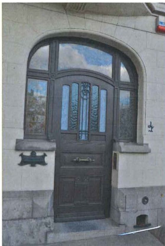
Foto 2: Extérieur, voorgevel. Voordeur met zij- en bovenlichten.
