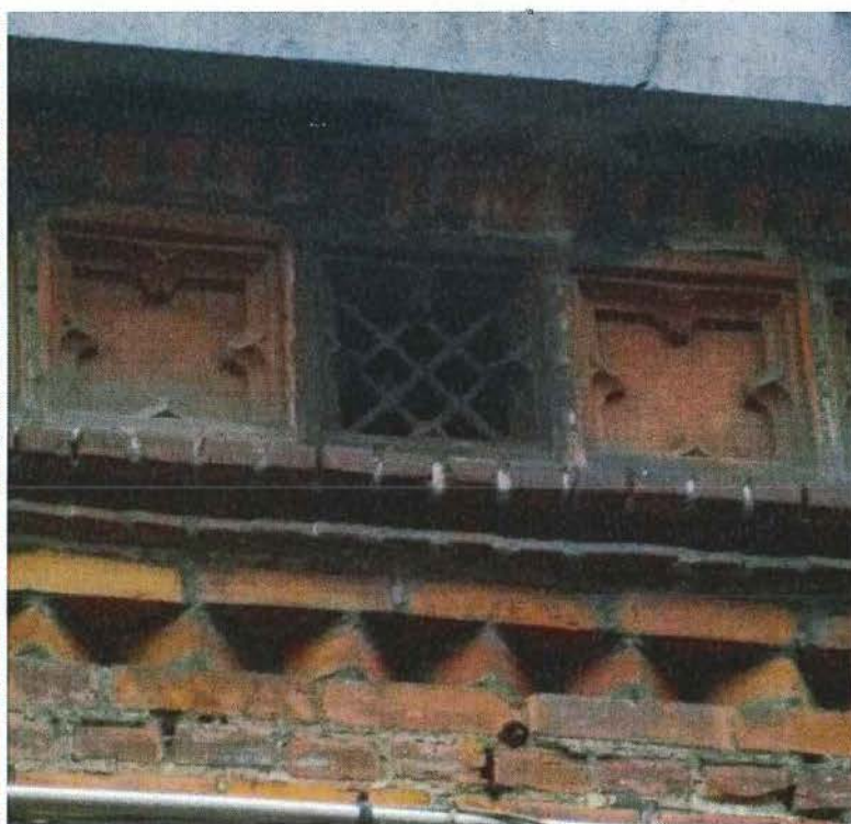
Foto 9-10: Nijverheidsschool (1857-1859) voorgevel: gekleurde knipvoegen en friezen met verluchtingsrooster
