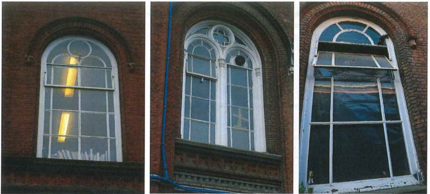
Foto 3-5: Nijverheidsschool (1857-1859) voorgevel: schrijnwerk
