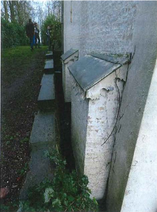
Foto 18: Voormalig landhuis, zijgevel met uitsprong
