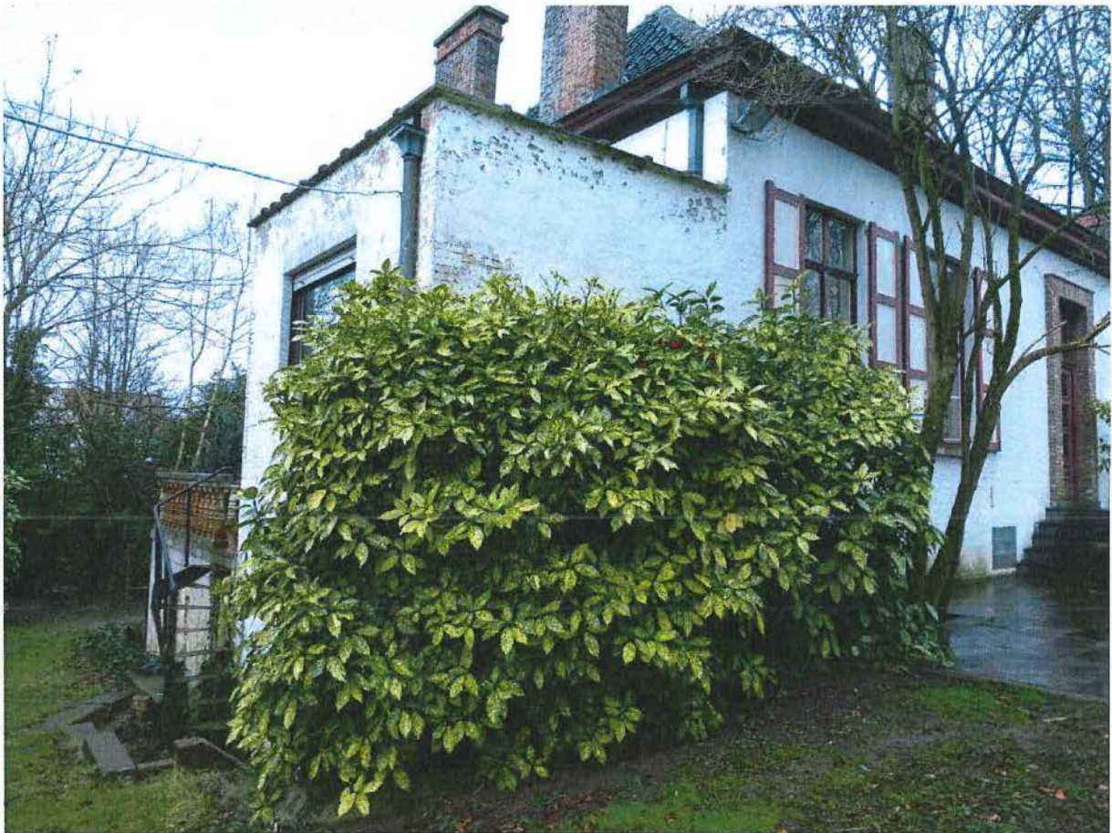
Foto 17: Voormalig landhuis, oostelijke zijgevel
