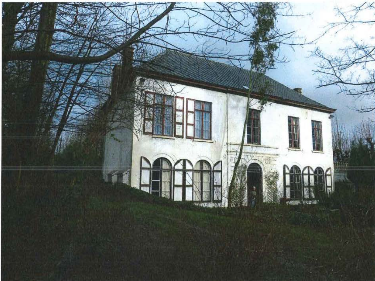
Foto 11: Algemeen zicht op het voormalig landhuis, voorgevel
