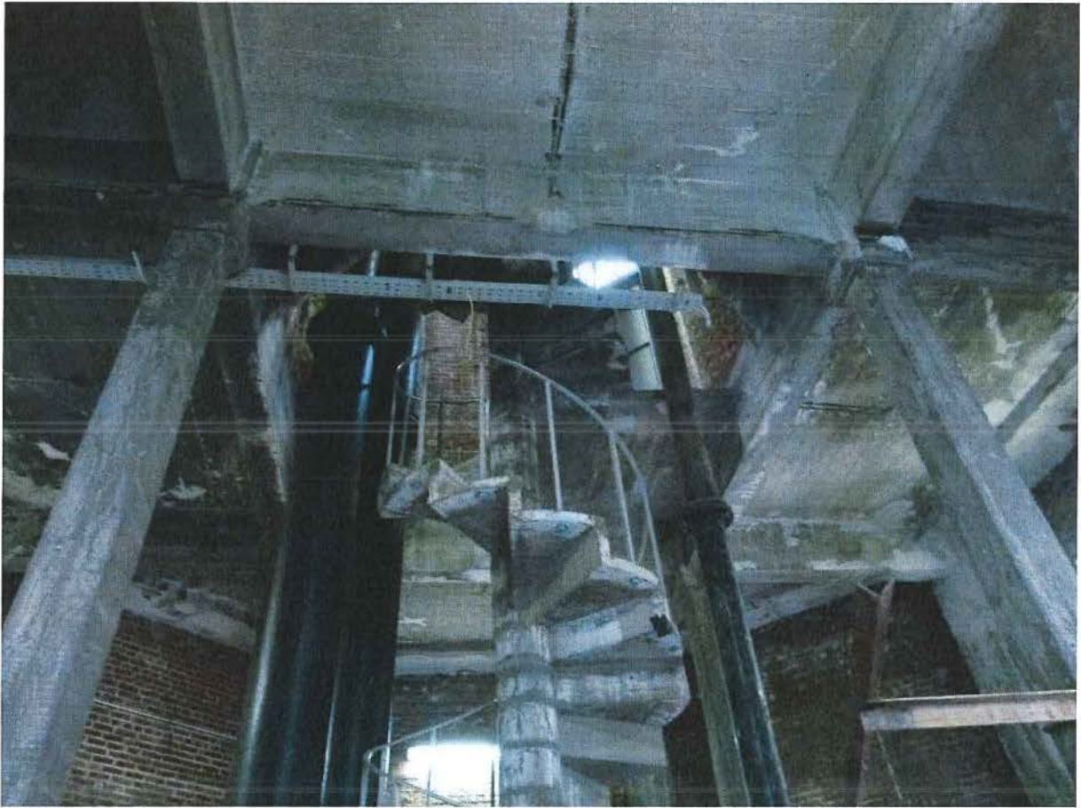
Foto 12: Balken en pijlers ter ondersteuning van de gemetselde schacht rond de wenteltrap.
