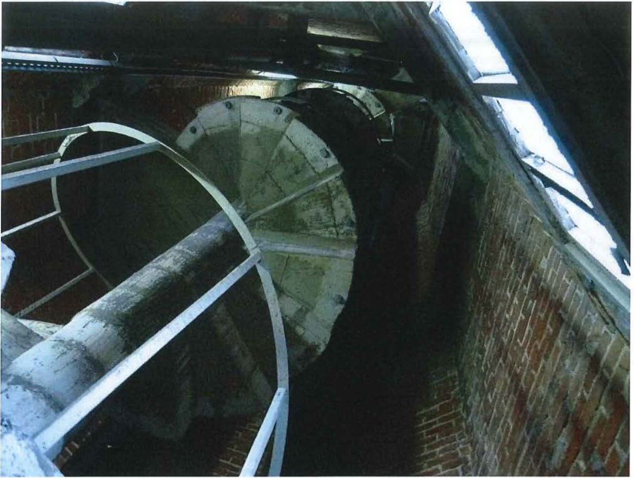
Foto 13: Zicht op de wenteltrap, achthoekige gemetselde schacht en raam.
