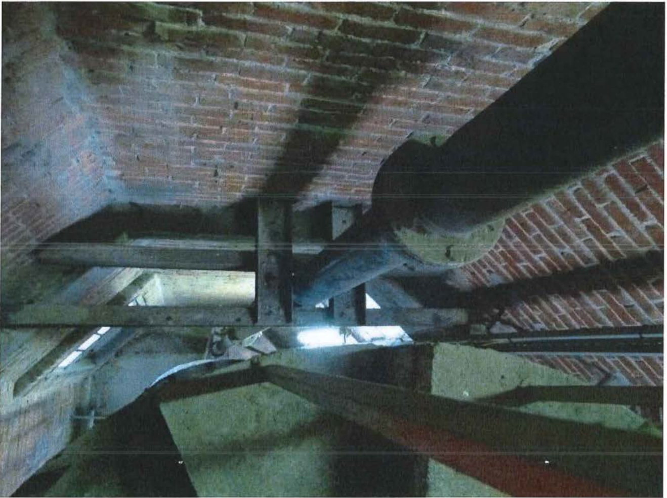
Foto 14: De afvoerbuis van de overstort en leegloop wordt met stalen profielen gefixeerd.
