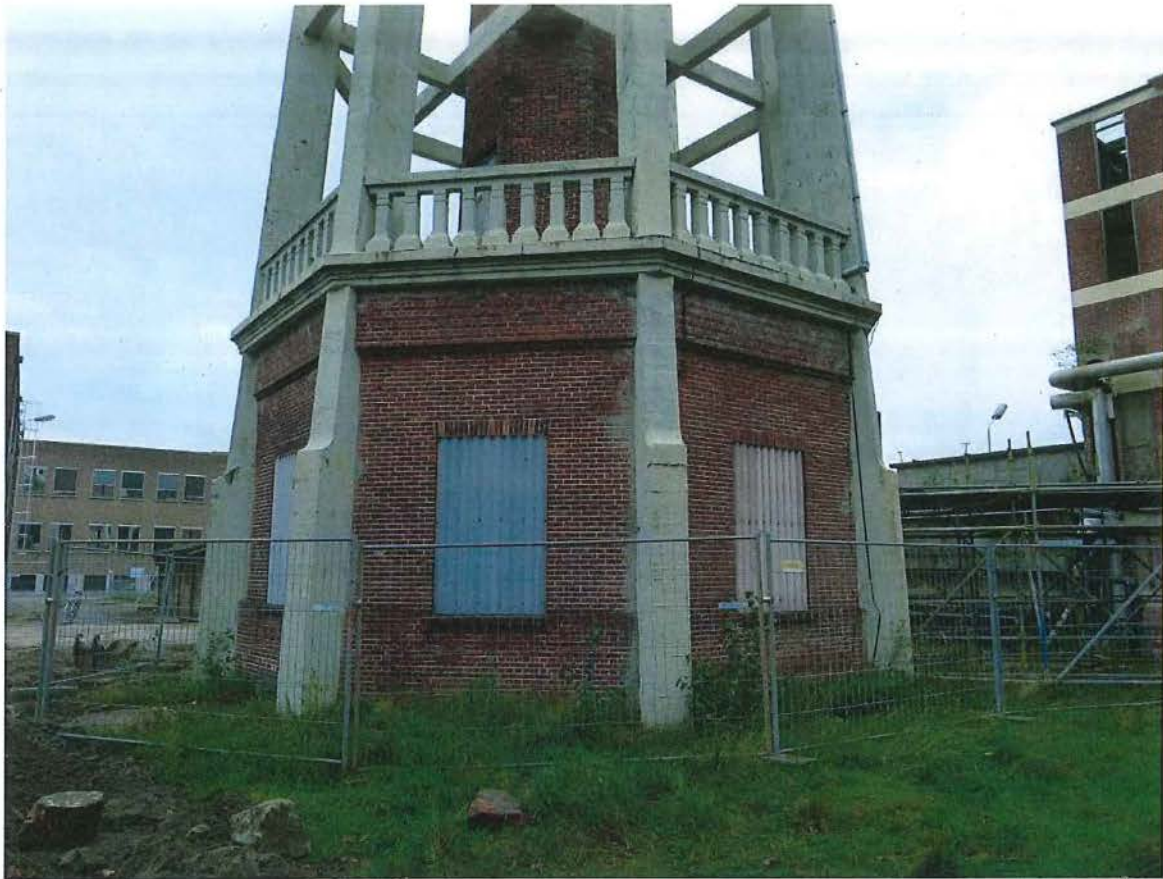
Foto 2: De gelijkvloerse verdieping als een achthoek met de betonnen pijlers, waartussen het muurvlak is opgevuld met bakstenen metselwerk.
