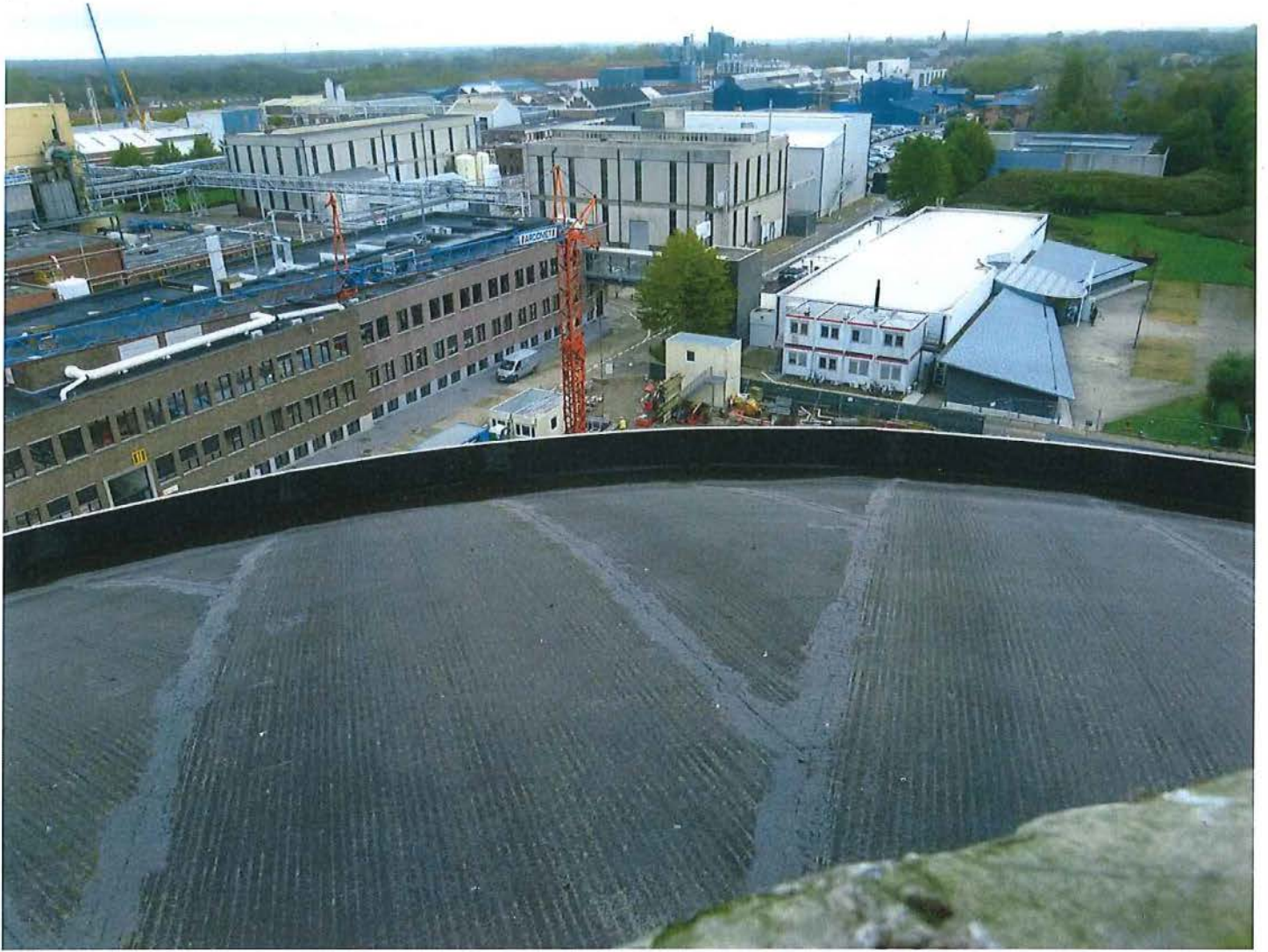
Foto 17: Zicht op het dek van het reservoir.
