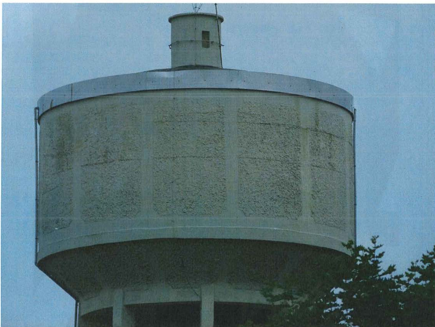
Foto 5: Het uitkragende Intze 1-reservoir in beton.
