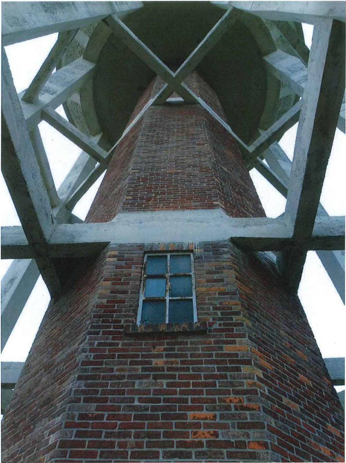
Foto 4: De open schacht met zicht op de kruisverbanden tussen de acht pijlers en het metselwerk rond de wenteltrap.
