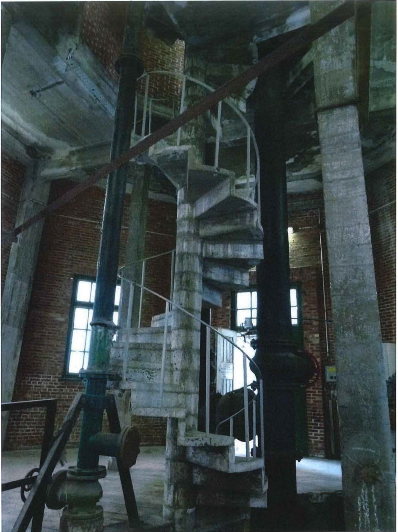
Foto 6: De wenteltrap in beton met eenvoudige leuning. Links op de foto de afvoerbuis van de leegloop en de overstort.
