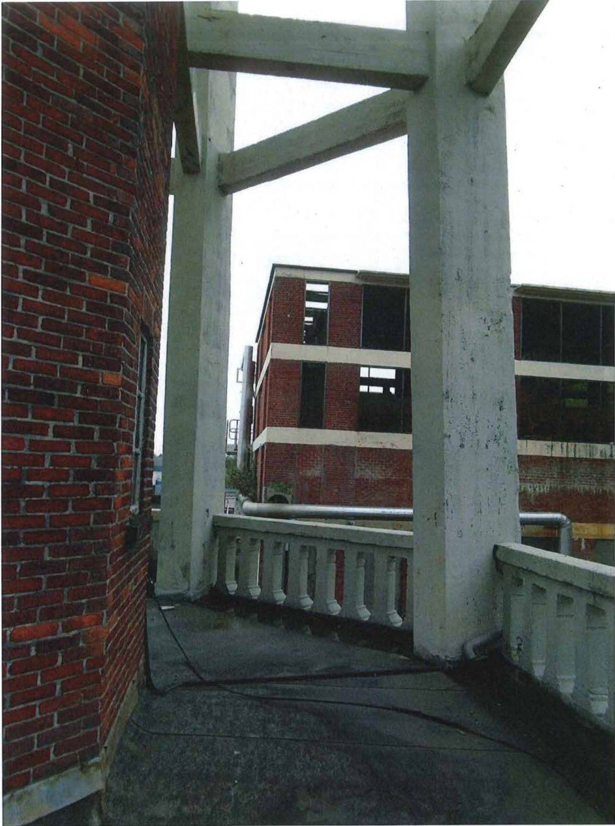
Foto 15: Zicht op het terras op de eerste verdieping, met balustrade en pijlers in beton.
