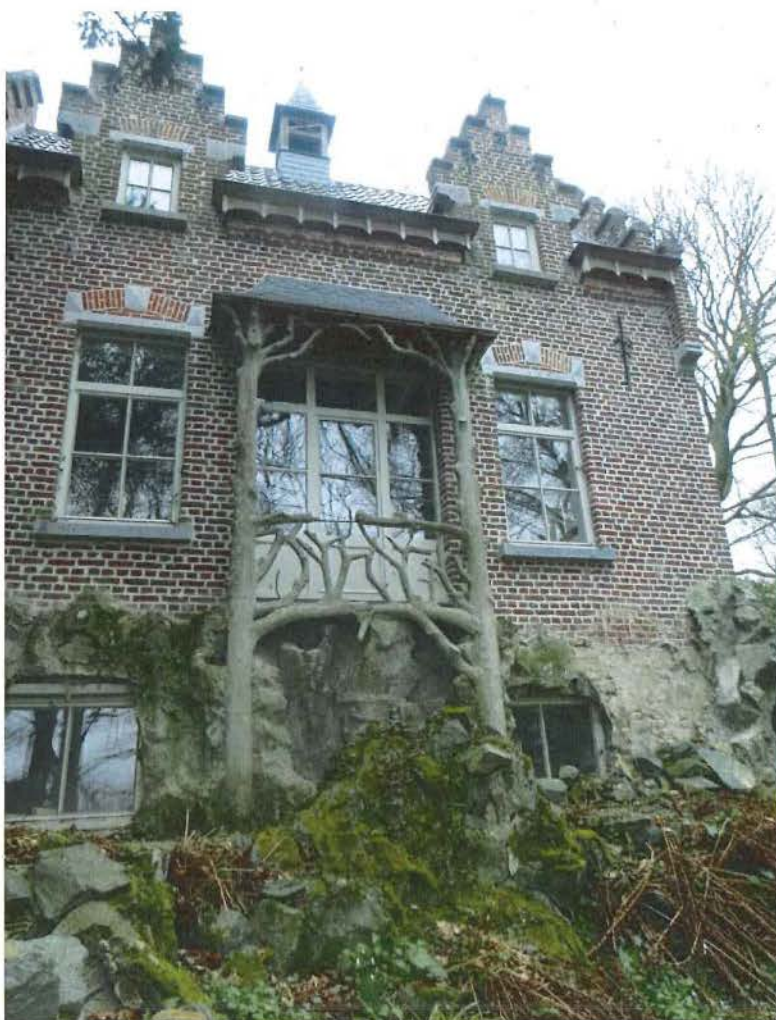
foto 48: voorgevel van de 'Villa Albert' met cementrustieke erker
