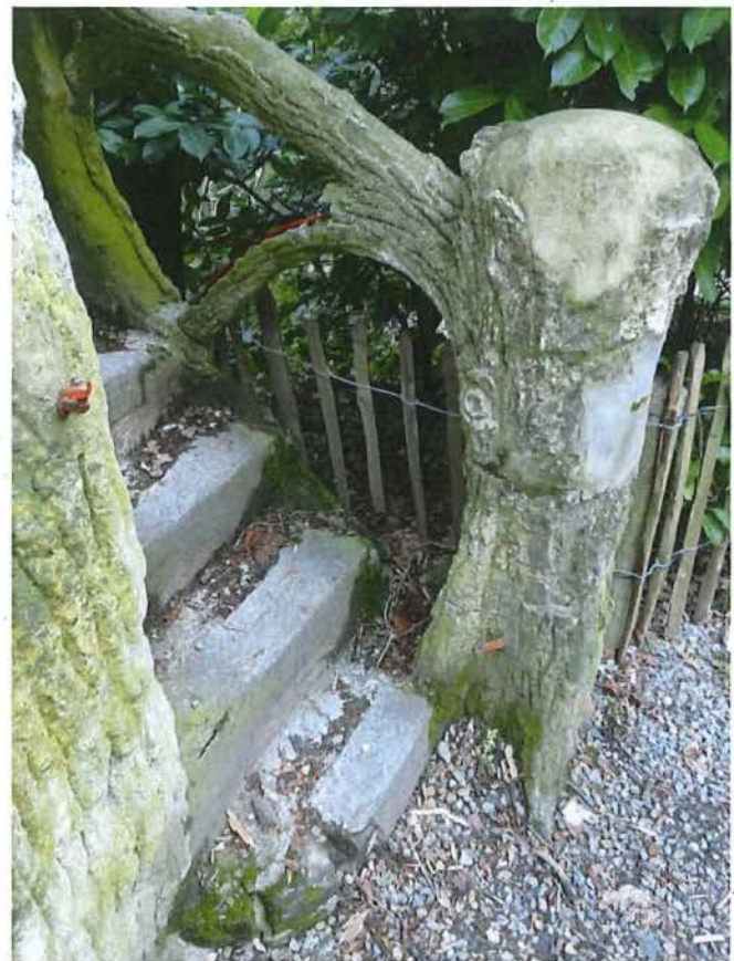
foto 27: detail van trapconstructie bij de openluchtpreekstoel met scharnier van afsluitpoortje
