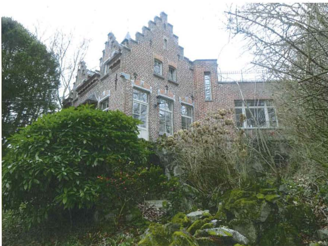
foto 49: zijgevel van de 'Villa Albert' met latere modernistisch getinte uitbreiding
