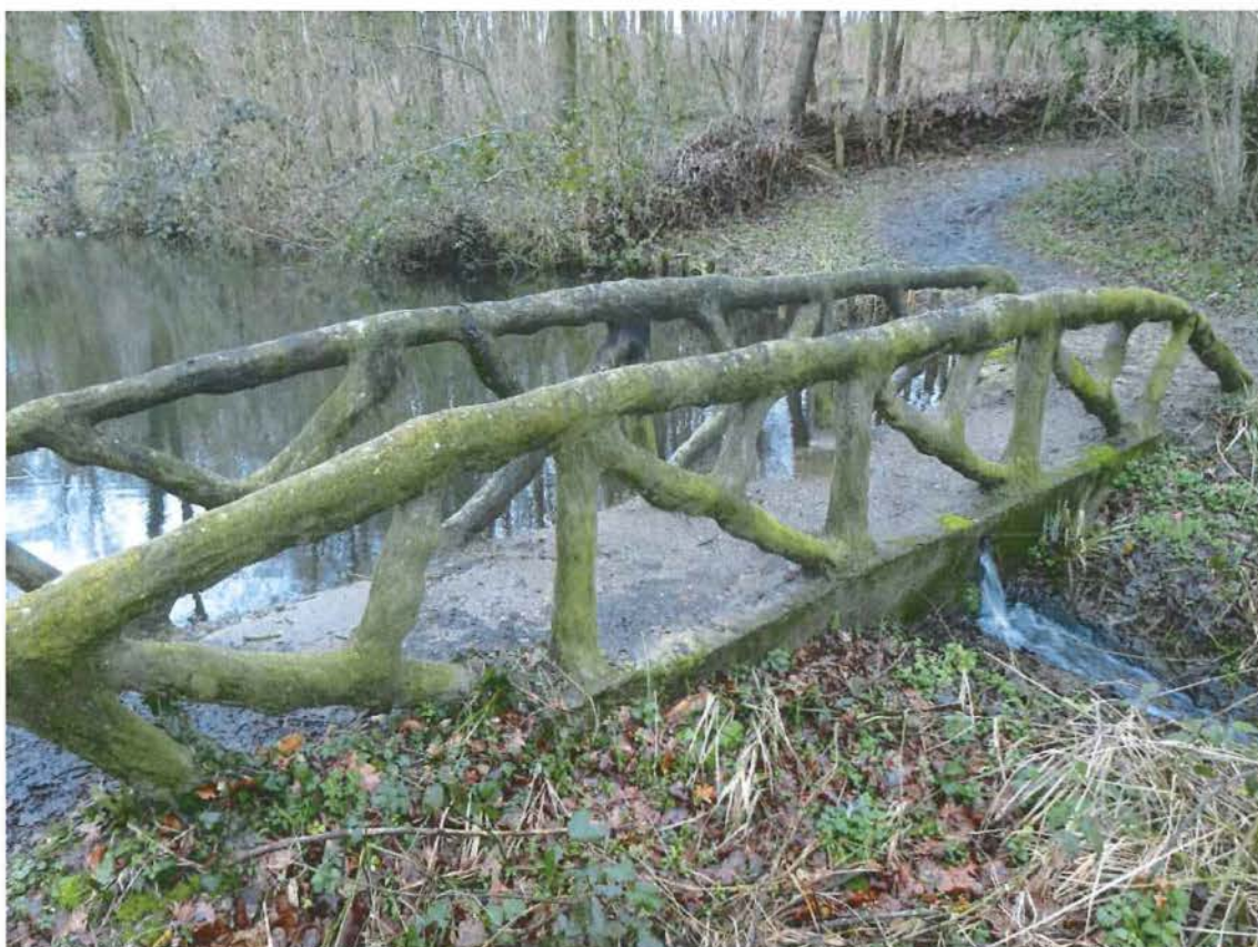
foto 40: cementrustiek sierbrugje met loopvlak uitgebouwd als stuw
