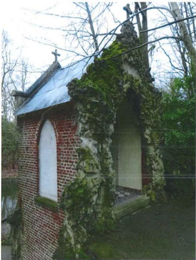
foto 28: rotskapel met cementrustiek gevelfront
