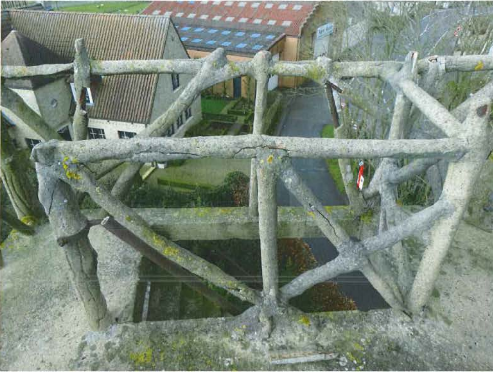
foto 69: borstwering in cementrustiek van het hoogste uitkijkplatform
