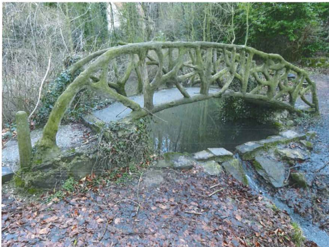
foto 39: cementrustiek sierbrugje annex stuw in gestapelde natuursteen
