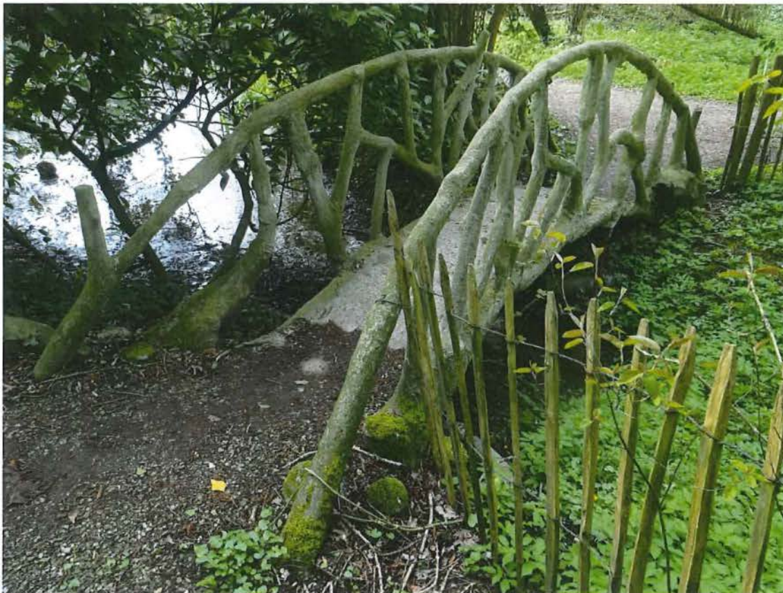
foto 4: bronbeekloop met cementrustiek boogbrugje
