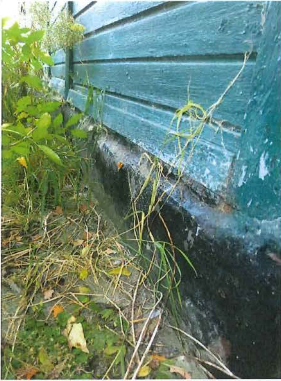
Foto 4: Gecementeerd fundament waarop de noodwoning is geplaatst.
