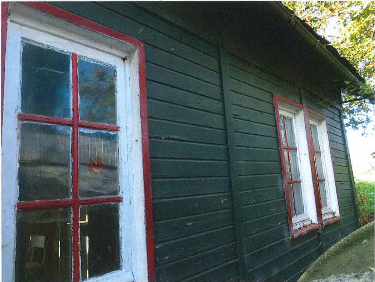
Foto 6: Enkelvoudige vensteropeningen aan noordoostelijke zijde.
