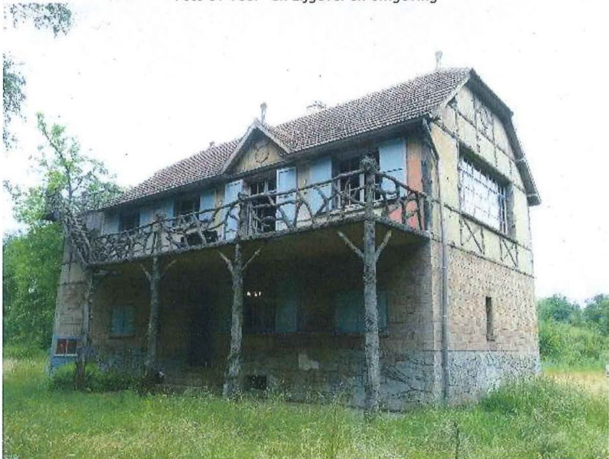
Foto 10: Voor- en zijgevel met details van cementrustieke balustrade rond balkon en trap
