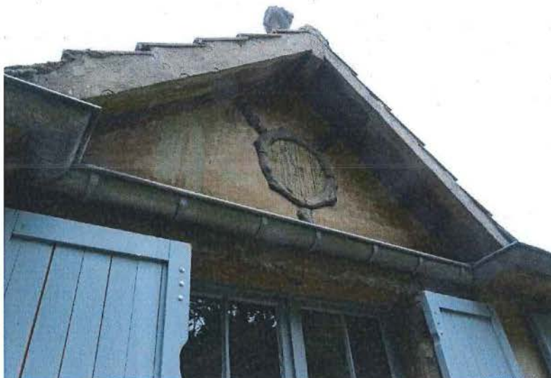
Foto 33: Detail imitatie vakwerk onder dak
