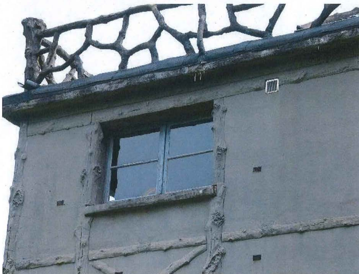
Foto 23: Detail balustrade, schrijnwerk en cementrustiek
