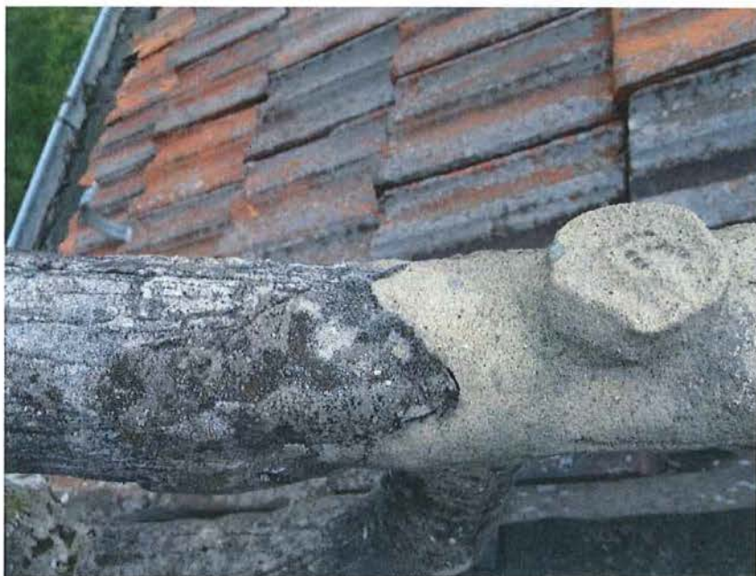
Foto 29: Detail gerestaureerde cementrustiek
