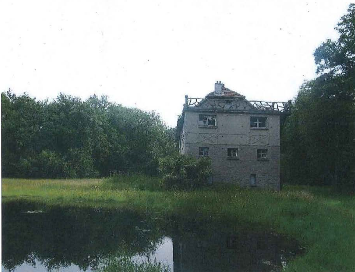
Foto 4: Zijgevel met balkon met cementrustieke balustrade
