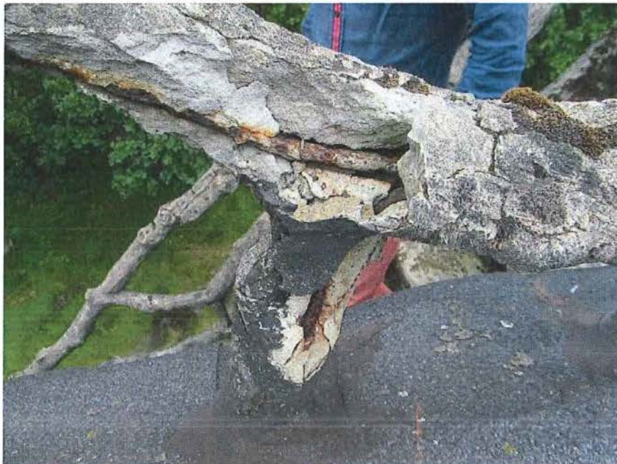
Foto 31: Zicht bovenaan de trap op balkon voorgevel Foto 32: Detail cementrustiek, balustrade zijbalkon
