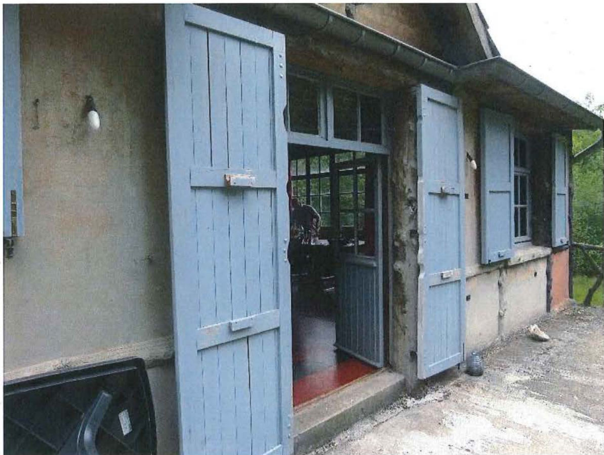
Foto 35: Buitendeur naar balkon
