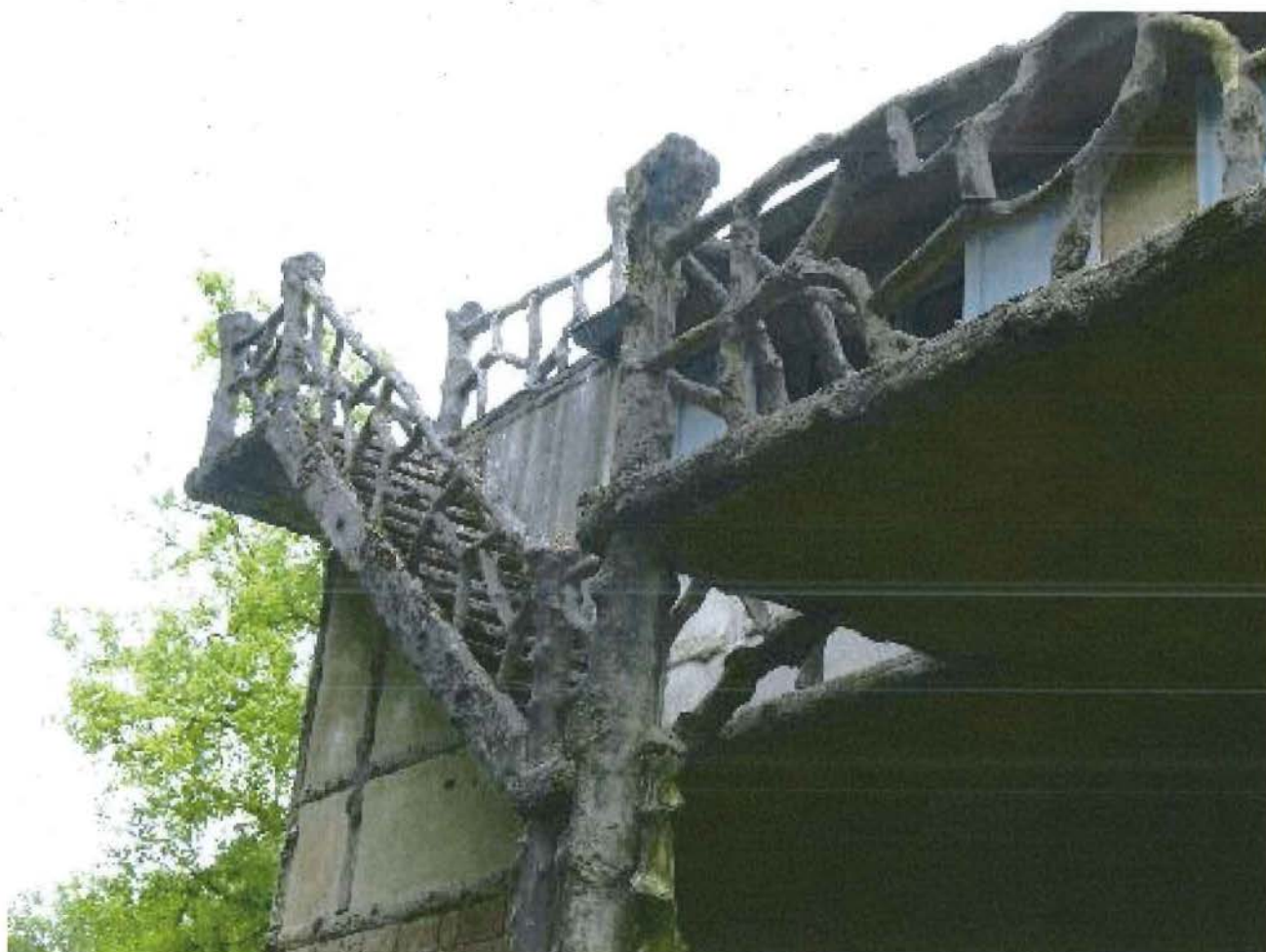
Foto 16: Detail cementrustieke balustrade bij trap en balkon
