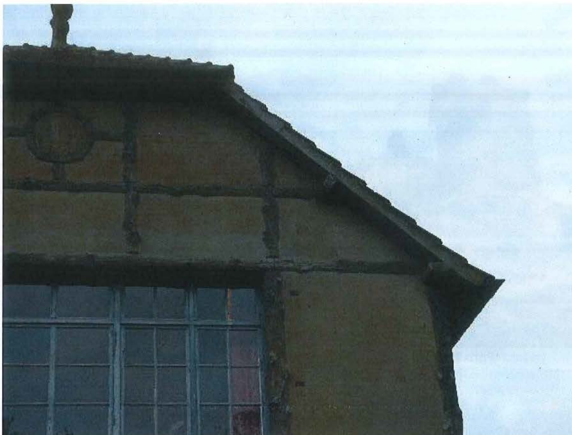
Foto 22: Detail cementrustiek: imitatie vakwerk en boomstammen
