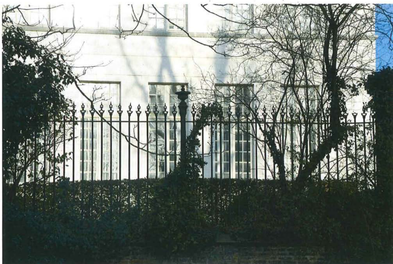
Foto 8: Meestraat 2B-4, kaaimuur met hekwerk
