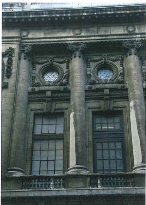
Foto 12: Vlaamse opera: achtergevel: bovenbouw
