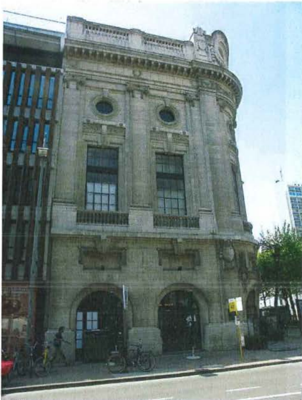
Foto 96: voormalig schermenmagazijn: gevel Van Ertbornstraat
