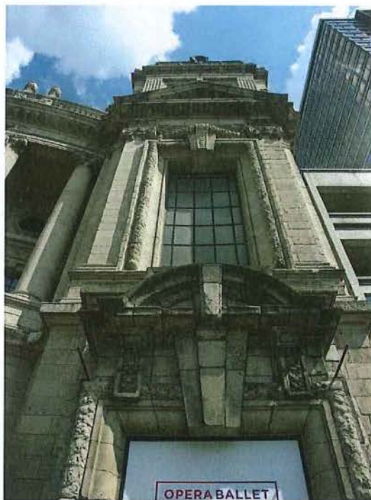
Foto 5: Vlaamse opera: voorgevel: zijrisaliet
