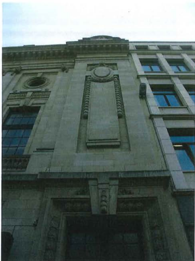
Foto 100: voormalig schermenmagazijn: gevel Franklin Rooseveltplaats: blind travee uiterst rechts
