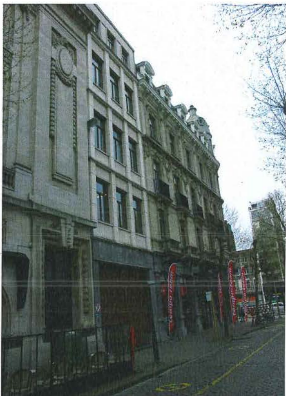
Foto 124: straatbeeld zijde Franklin Rooseveltplaats: pand nummer 6 tussen het schermenmagazijn en het voormalig hotel Wagner
