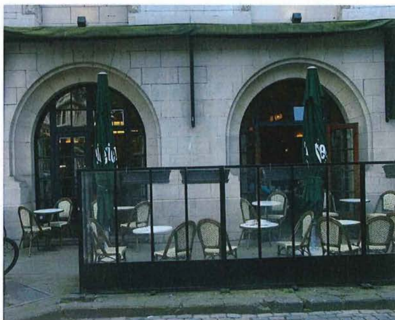
Foto 103: voormalig schermenmagazijn: begane grond (brasserie)
