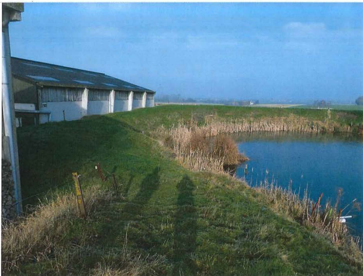
3. Krater 1 bij hoeve Hollandse Schuur, bedrijfsgebouw in de kraterlip gebouwd, 17/01/2017
