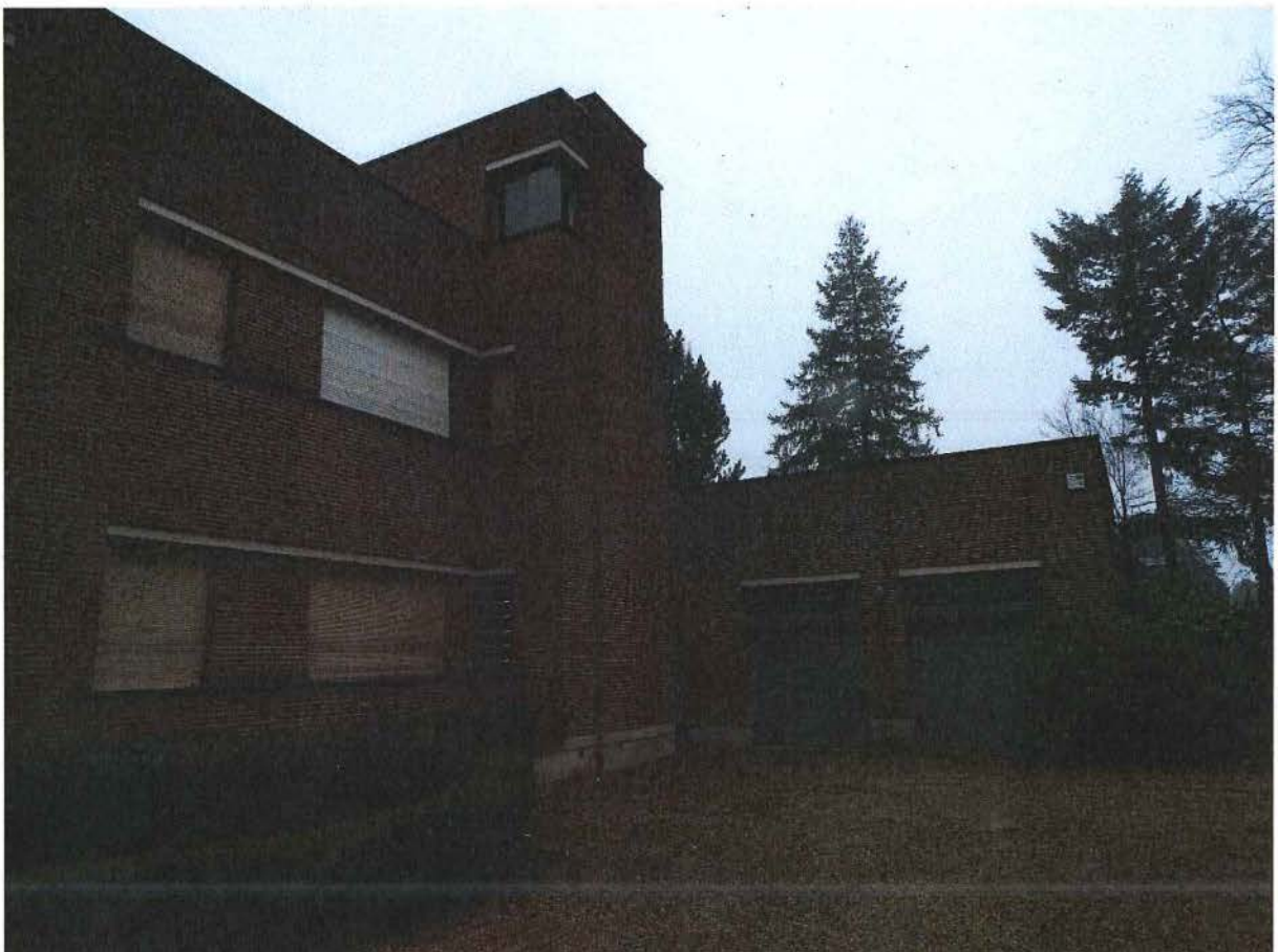
Foto 2: Voorgevel met zicht op de garages
