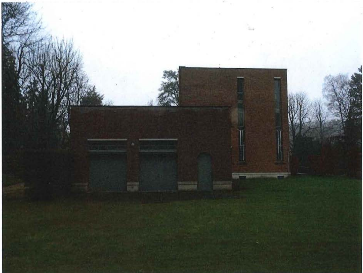
Foto 4: Westgevel met garages
