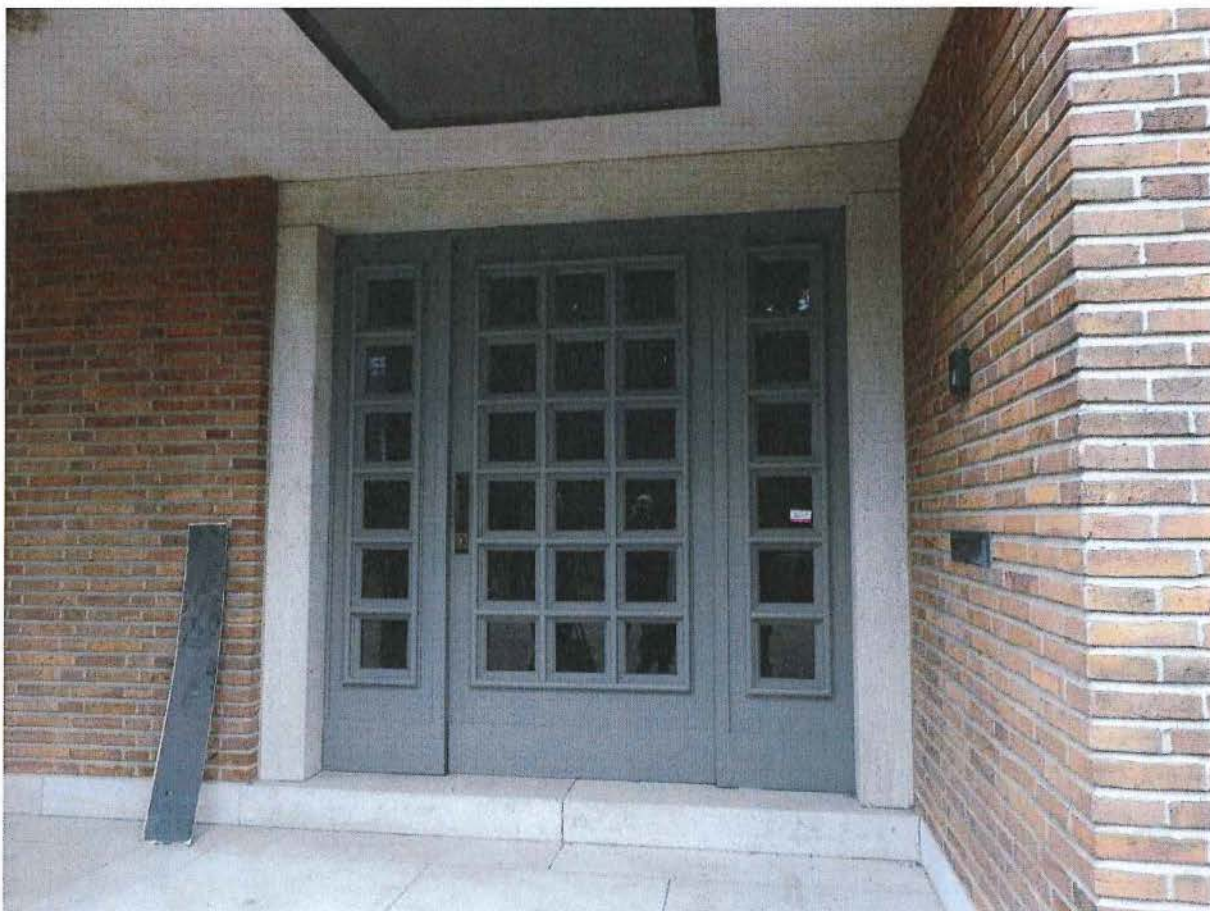
Foto 13: Toegangsdeur in voorgevel
