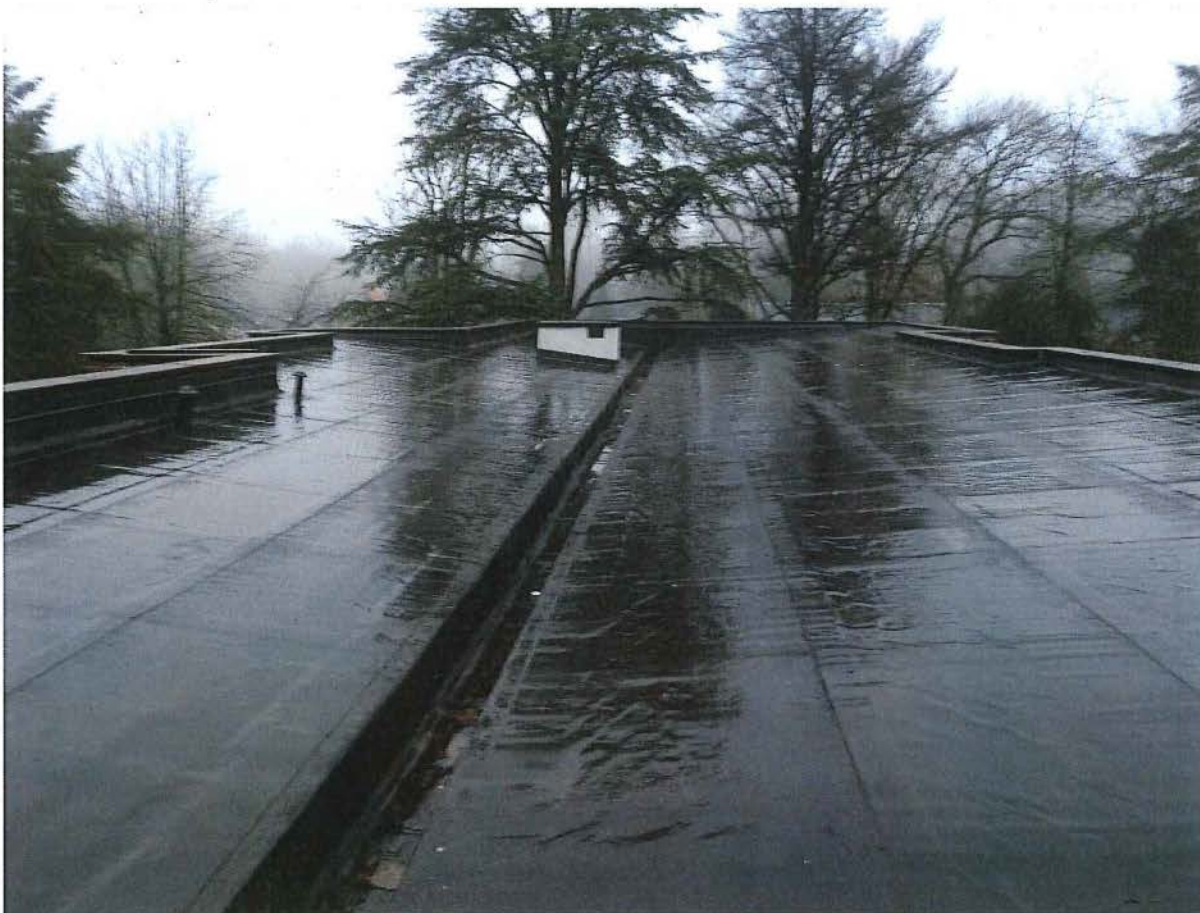
Foto 12: Dak van het hoofdvolume van het gebouw
