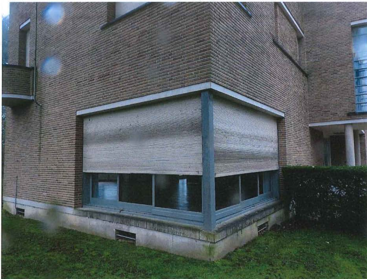
Foto 11: Detail van het overhoeks raam tussen oostgevel en voorgevel
