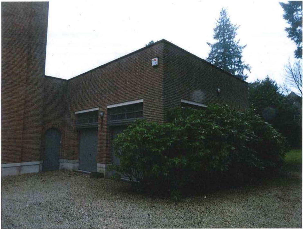
Foto 3: De garages aan de voorgevel
