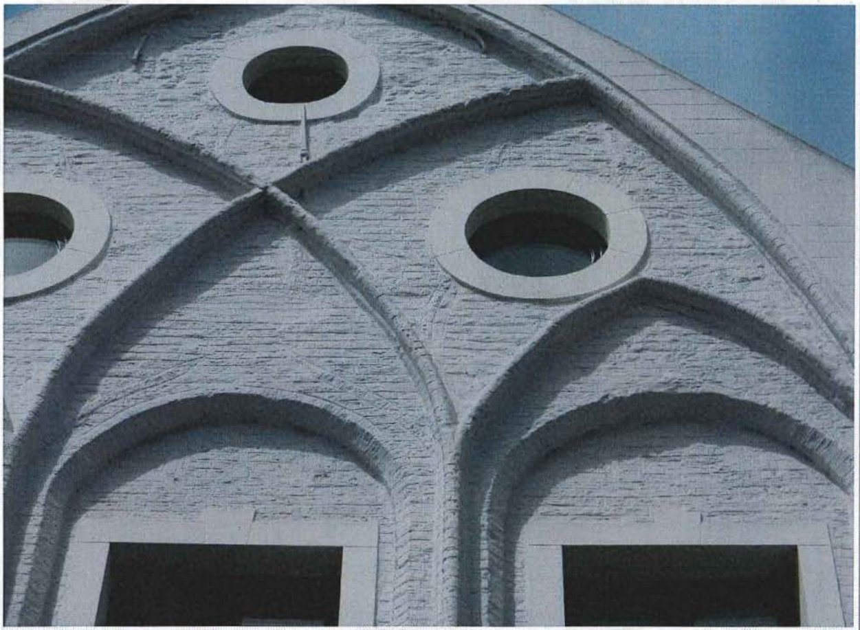
Foto 8: detail van het blind maaswerk in de voorgevel, met sporen van ingeschreven drie- en vierlobben.
