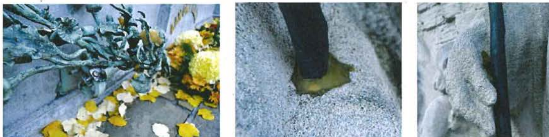
Fig. 6, 7 en 8: Originiele verankering van de bloementuil en staf, 2016
