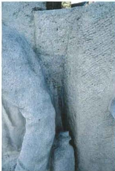
Fig. 22 en 23: Voeg tussen twee blokken en bevestiging van de bloementuil, 2016
