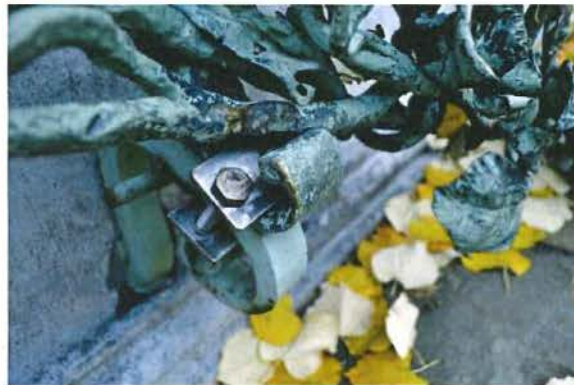
Fig. 22 en 23: Voeg tussen twee blokken en bevestiging van de bloementuil, 2016
