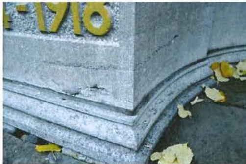
Fig. 18: Uitgespoelde stylolieten met lacunes, 2016
