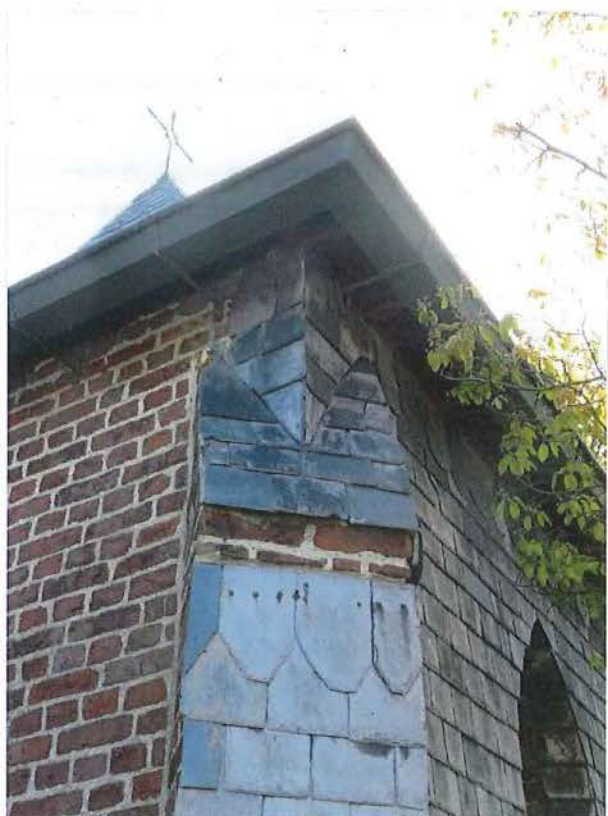
Foto 27. Sacristie van de Milanenkapel, detail: zijgevel en schuin geplaatste steunberen bezet met leien (04/05/2016)
