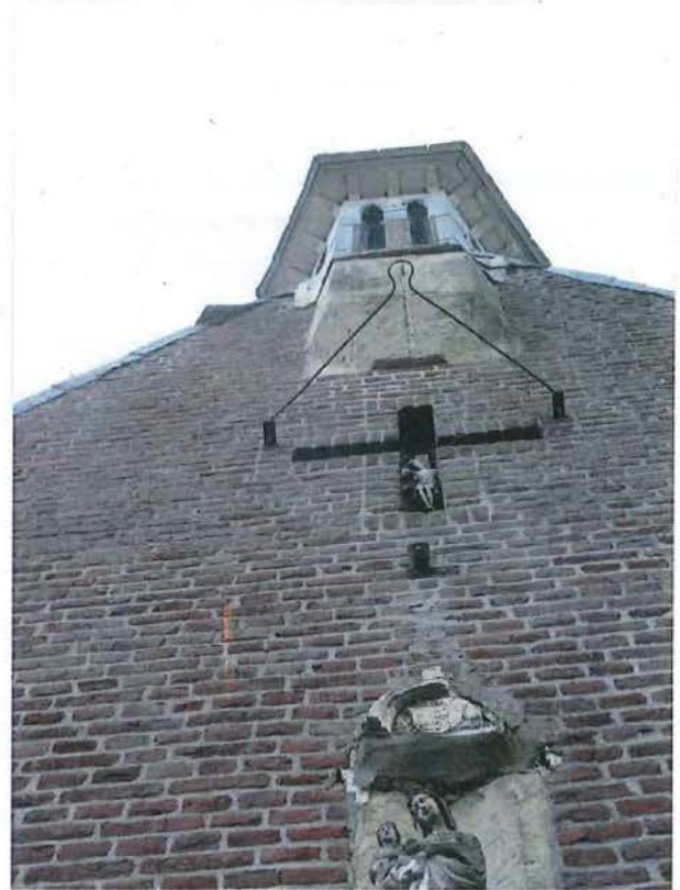
Foto 20. Portaalzijde, detail van het gevelveld: kruisnis en uitkragend torentje in natuursteen (08/04/2016)
