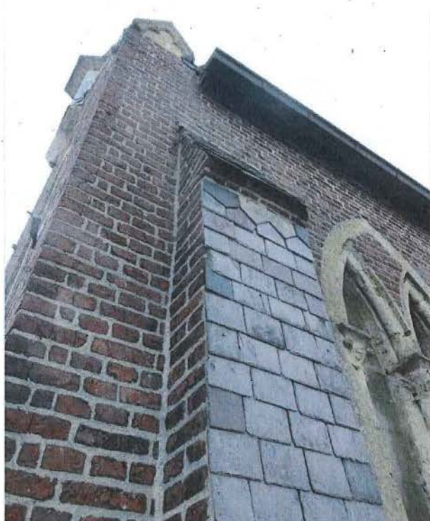
Foto 25. Westelijke zijgevel van de Milanenkapel, detail: bezetting van de steunberen met leien en natuurstenen aanzetsteen van het aandak met drielobmotief (08/04/2016)
