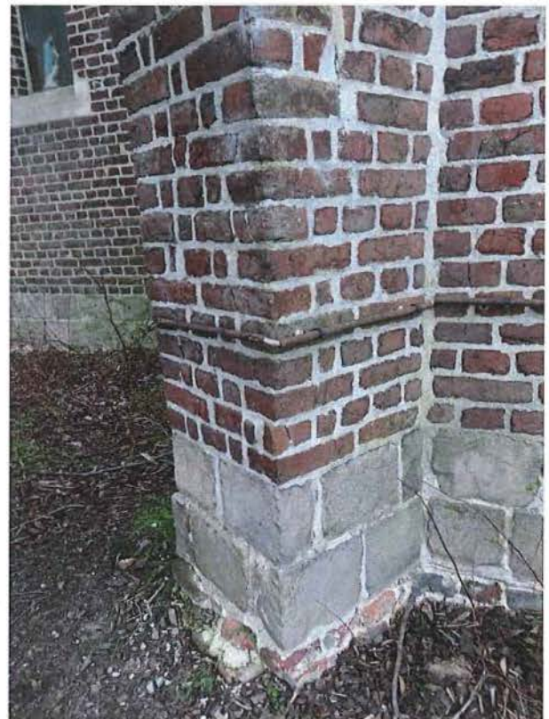
Foto 22. Plint in Artesische zandsteen, detail koorzijde (08/04/2016)
