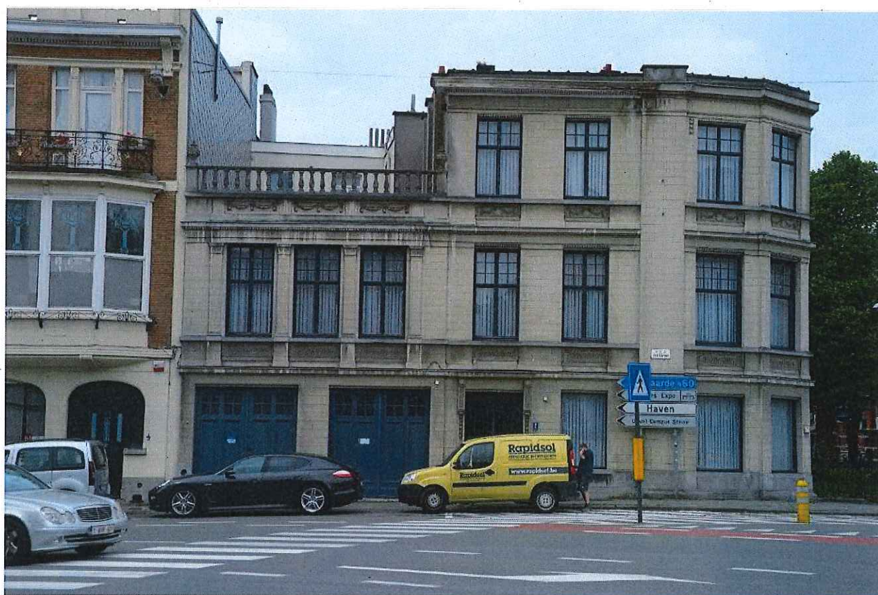
Foto 83: Hoekpand Krijgslaan nummer 2, voorgevel aan de Krijgslaan (07/07/2016).
