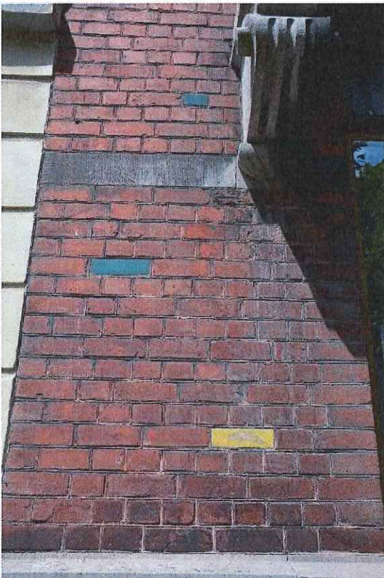
Foto 30: Parklaan nummer 80, voorgevel (detail) (06/07/2016).
