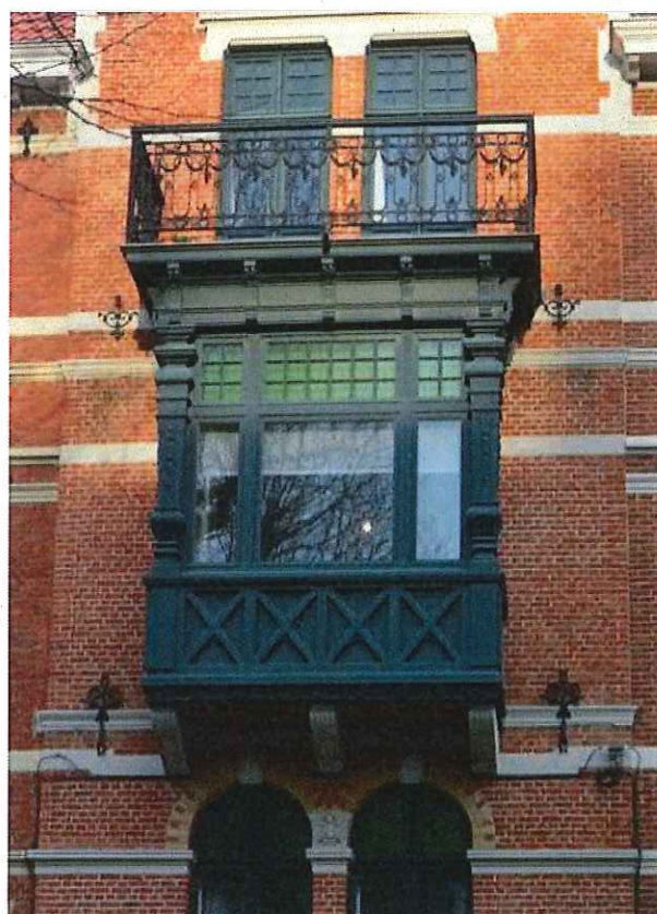
Foto 42: Parklaan nummer 10, voorgevel (detail) (09/12/2016).
