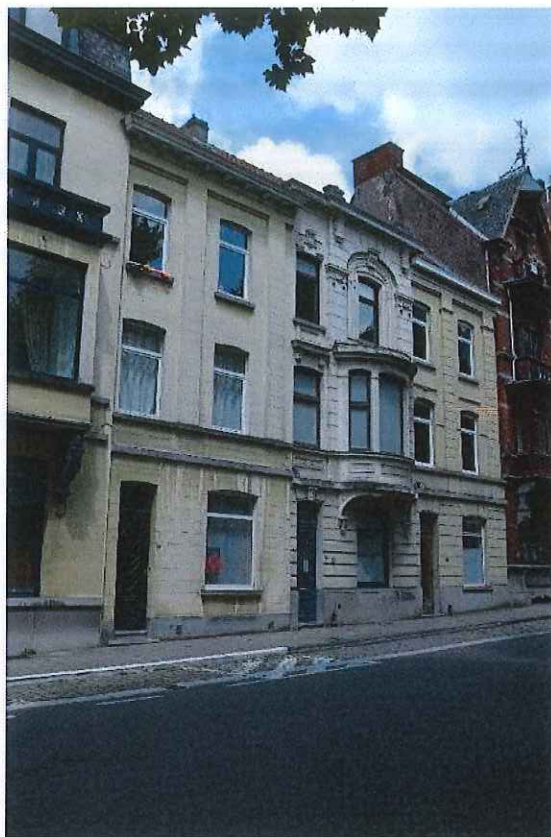
Foto 25: Parklaan nummers 82-86, voorgevels (voormalige eenheidsbebouwing van drie panden) (06/07/2016).
