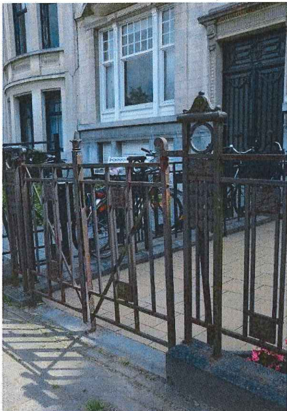
Foto 84: Parklaan nummer 3, voorgevel (detail hekwerk) (06/07/2016).
