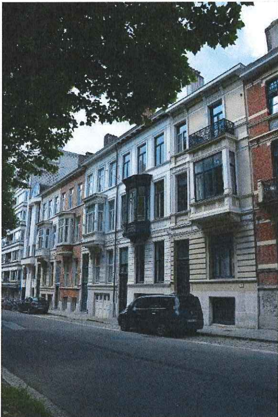
Foto 35: Parklaan nummers 28-40, voorgevel (voormalige eenheidsbebouwing van vier panden) (06/07/2016).
