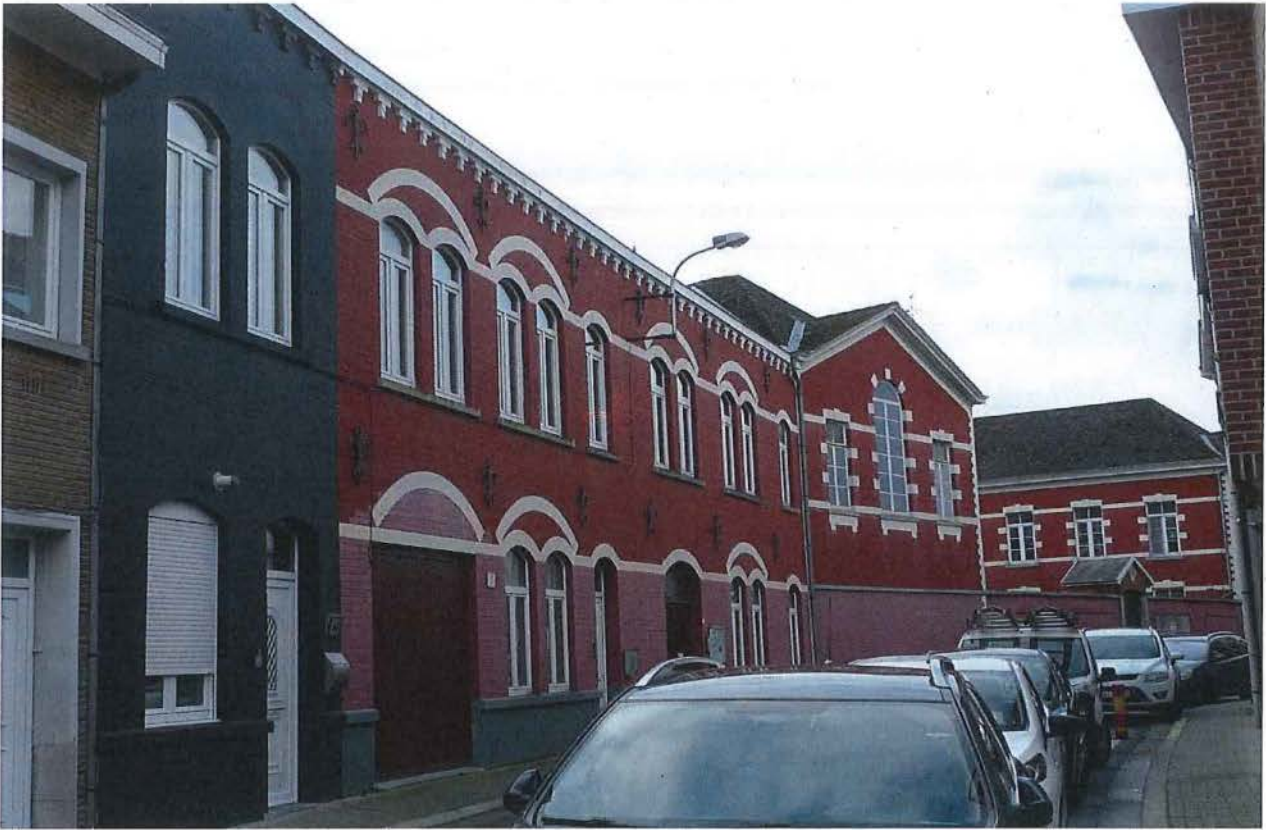
Foto 64: algemeen zicht - Gasthuisstraat 94, 96, 98, straatvleugel 1904-1906 vooraan
