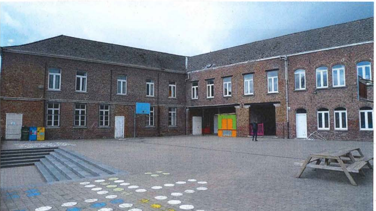
Foto 67: achtergevel oostvleugel van U-vormig inkomgebouw, achtergevel straatvleugel, speelplaats in niveaus
