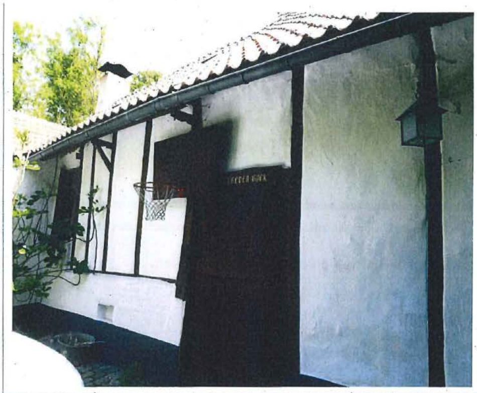
Foto 2: Straatgevel of vroegere achtergevel met huisnaam
