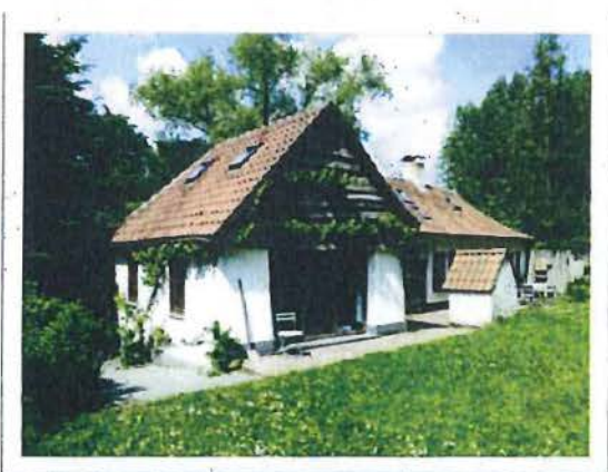
Foto 8: Voormalige paardenstal vanop het erf
