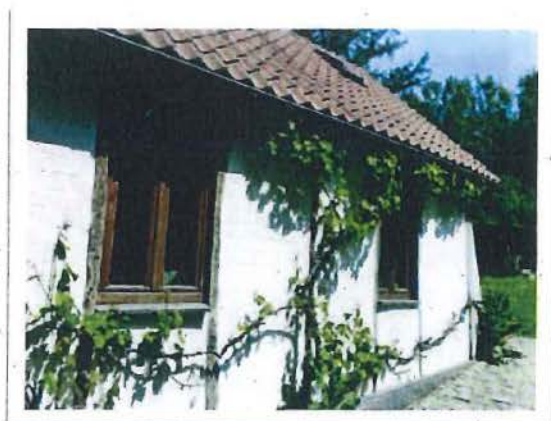
Foto 7: Zijgevel voormalige paardenstal
