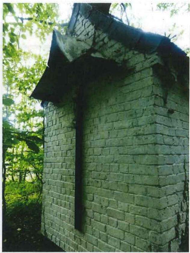
Foto 6: achtergevel met kruisbeeld onder afdak
