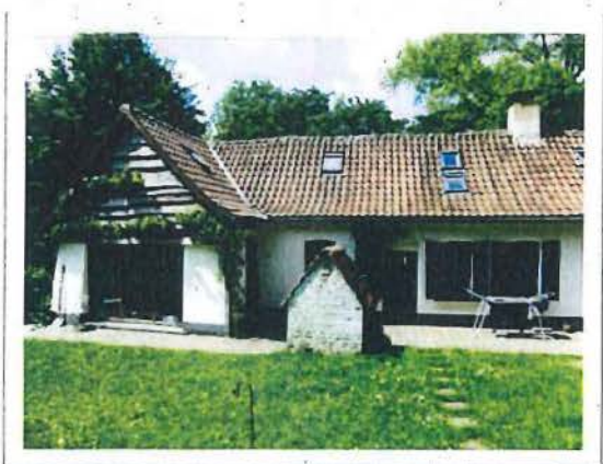
Foto 9: Erfzijde met paardenstal en vrijstaande steenput
