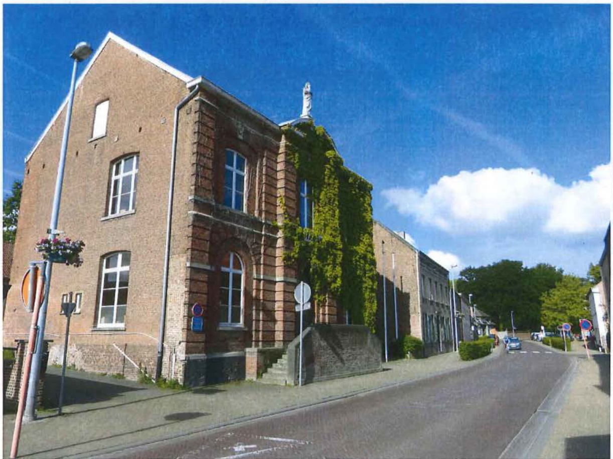
Foto 31: Gemeentehuis van Wespelaar, Grote Baan 55, zijgevel en voorgevel
