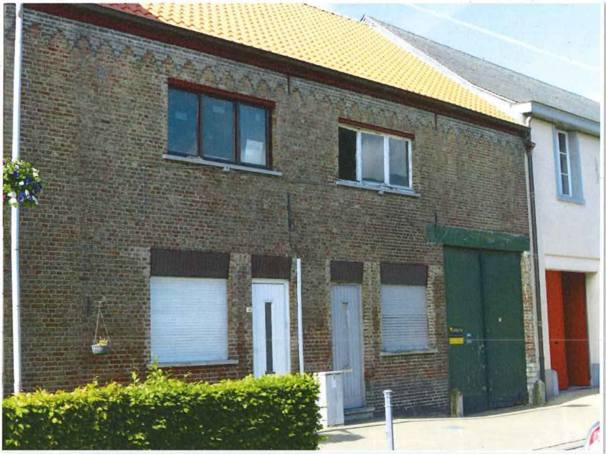
Foto 28: Bijgebouw burgerwoning, Grote Baan 59-61, voorgevel
