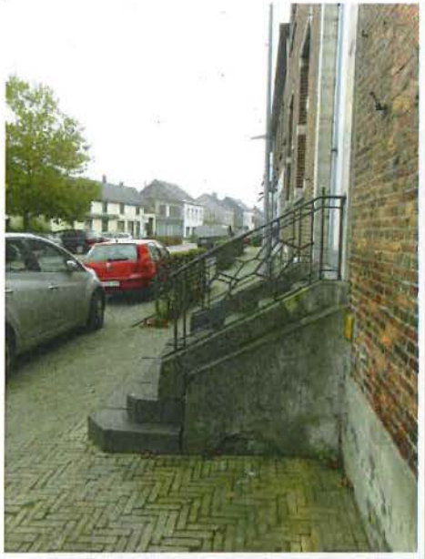
Foto 23: Pachthoeve De Sterre en bijgebouwen, voorgevel burgerwoning, detail steektrap, Grote Baan 71-73
