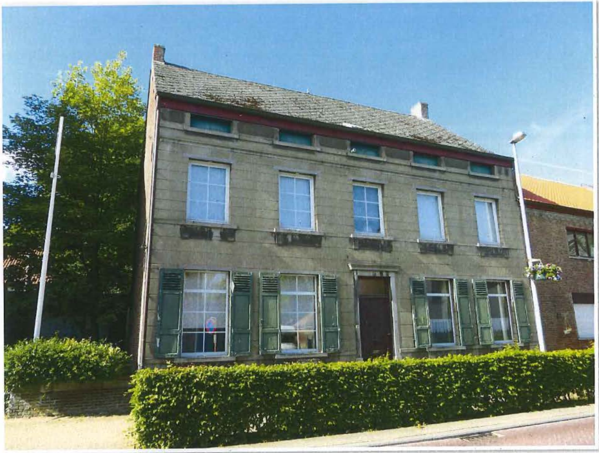
Foto 27: Burgerwoning, Grote Baan 57, voorgevel
