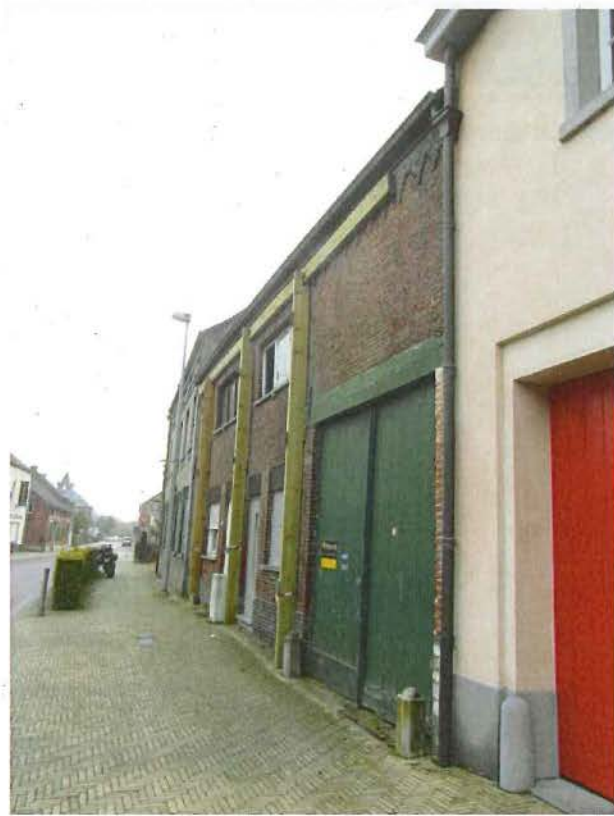
Foto 29: Bijgebouw burgerwoning, Grote Baan 59-61, voorgevel gestut
