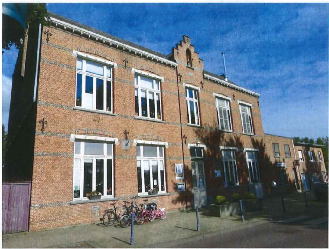
Foto 21: Meisjesschool, voorgevel, Nieuwstraat 1
