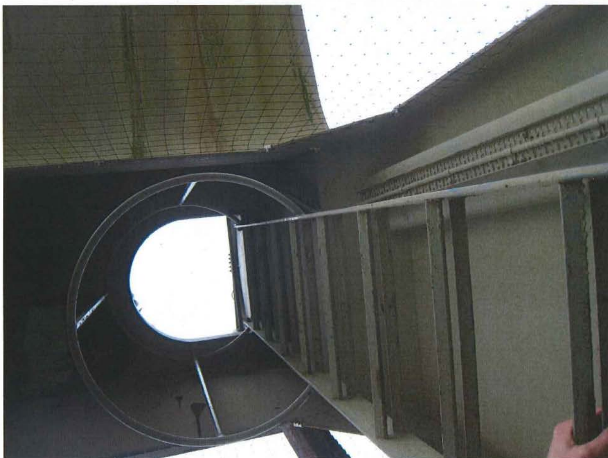
Foto's 35 en 36: Het derde niveau van de toren zonder installaties.
