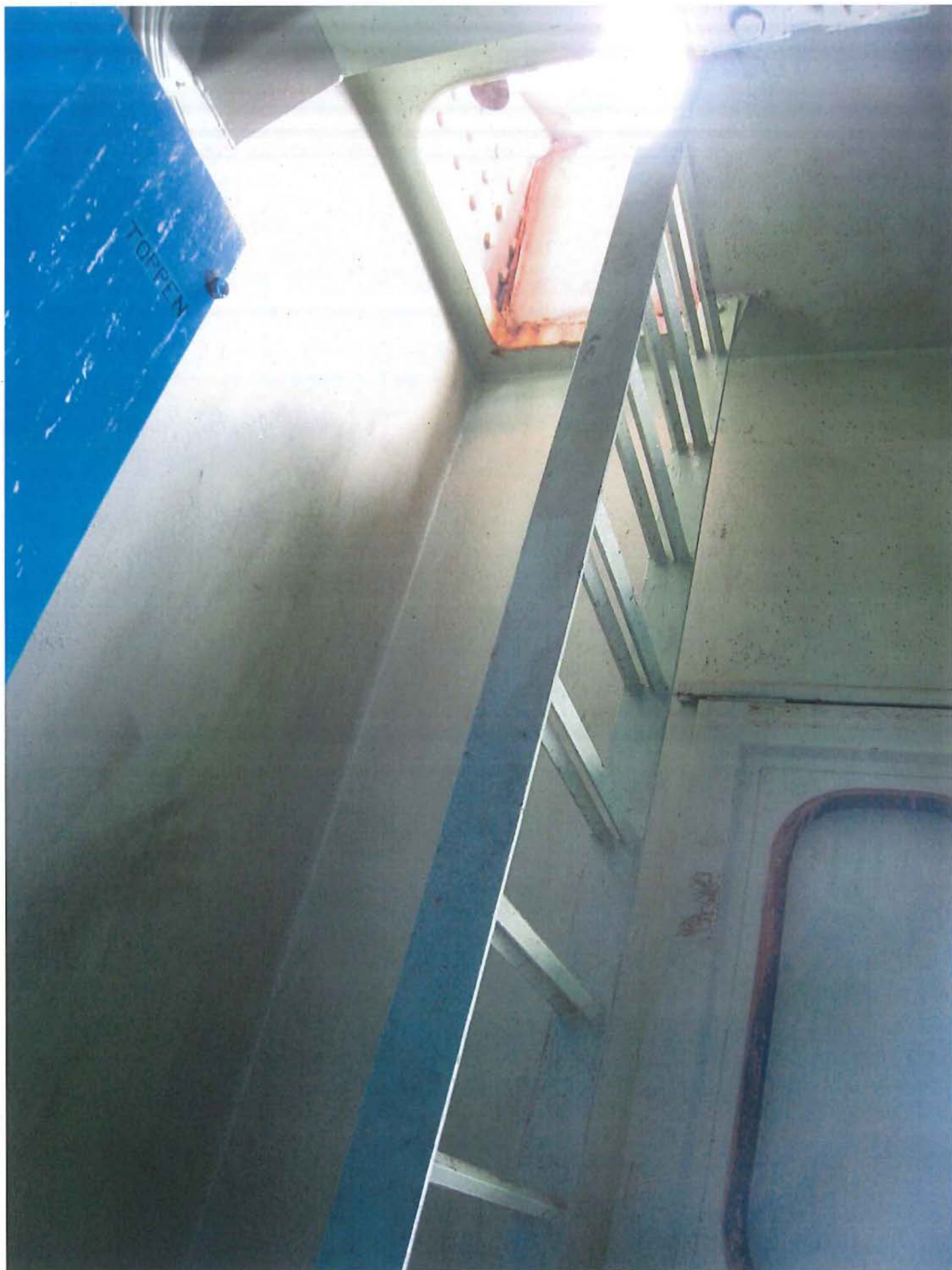
Foto 29: De trap die vanuit de machinekamer naar de toren leidt.
