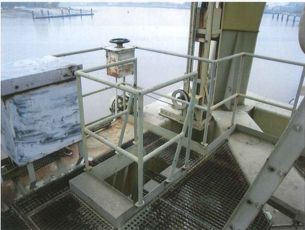
Foto's 11 en 12: De trap komt uit op het bordes bij het kruis. Zicht van op het bordes op de trap.
