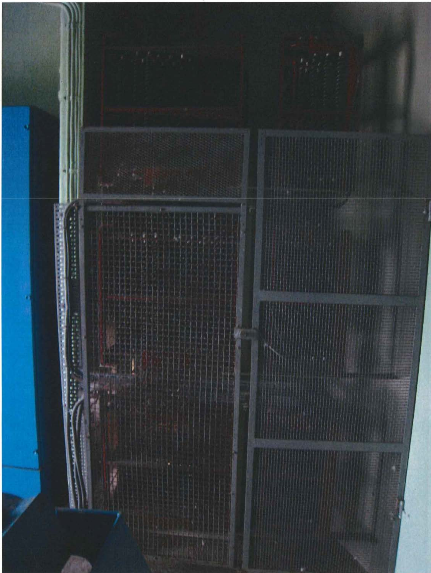
Foto 19: De machinekamer bevat het rek met de aanloopweerstand voor het hijsen, zwenken en toppen.
