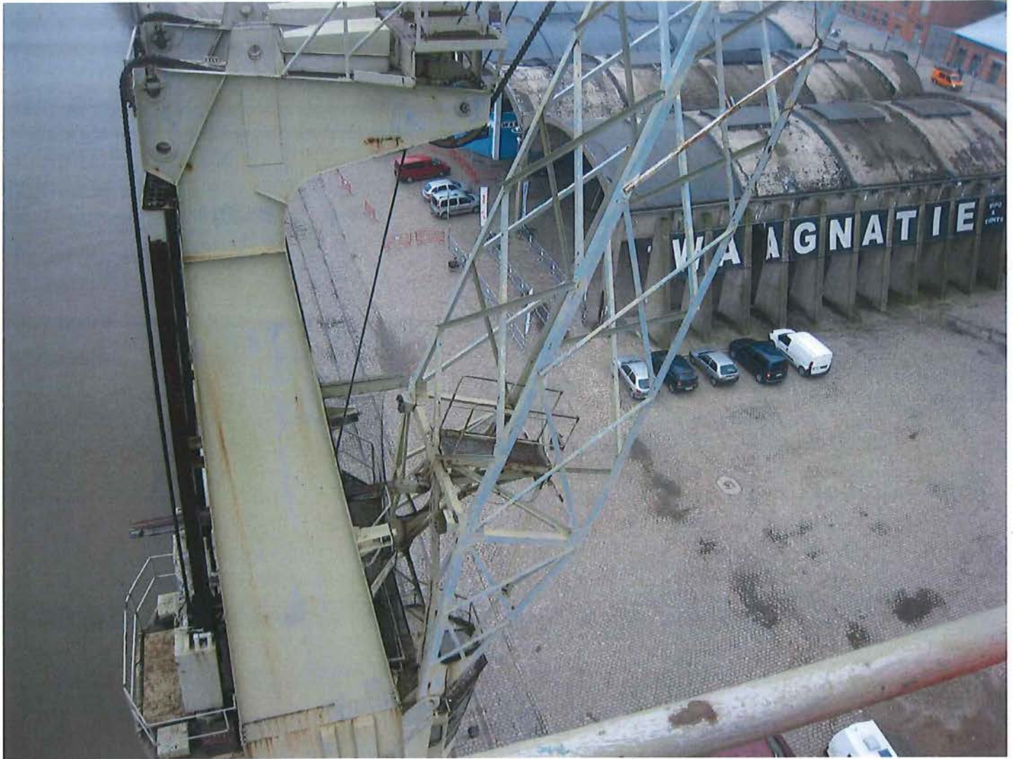
Foto 44: Aan de achterzijde van de toren is het tegengewicht van de giek en de glijbaan zichtbaar.
