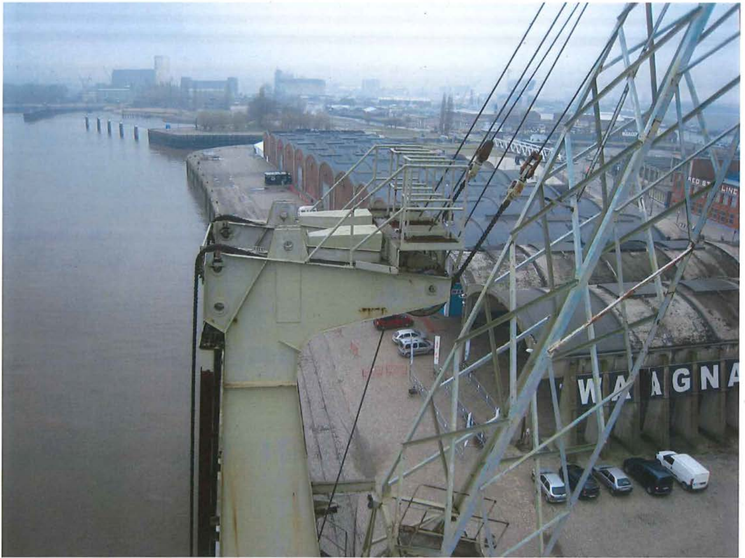
Foto 37: Bovenaan de toren zijn de twee kettingwielen geïnstalleerd die de twee rollenkettingen van het tegengewicht van de giek geleiden en de twee schijven voor de geleiding van de hijskabel. Alle kettingwielen en schijven zijn bereikbaar voor onderhoud vanop een platform.
