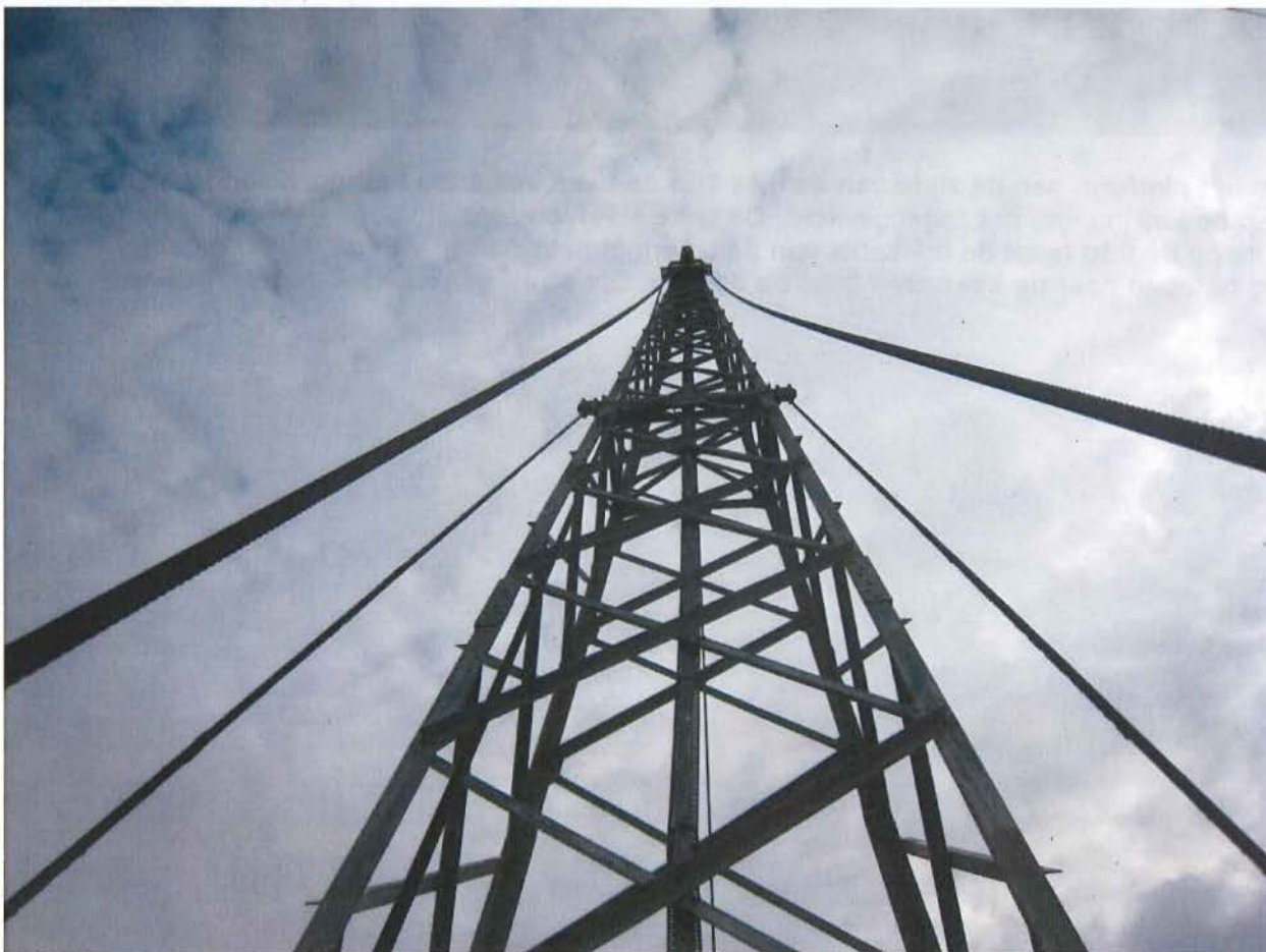
Foto's 40 en 41: De schakels die de kettingen van het tegengewicht verbinden met de ophangkabels (foto boven). De giek in vakwerk met de bevestiging van de kabels van het tegengewicht en in de giekkop de keerschijf voor de hijskabel (foto onder).
