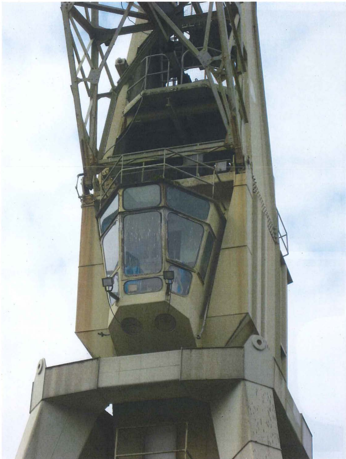
Foto 28: De erker gaf de kraandrijver een zo goed mogelijk zicht op de omgeving. Zicht vanop de grond.
