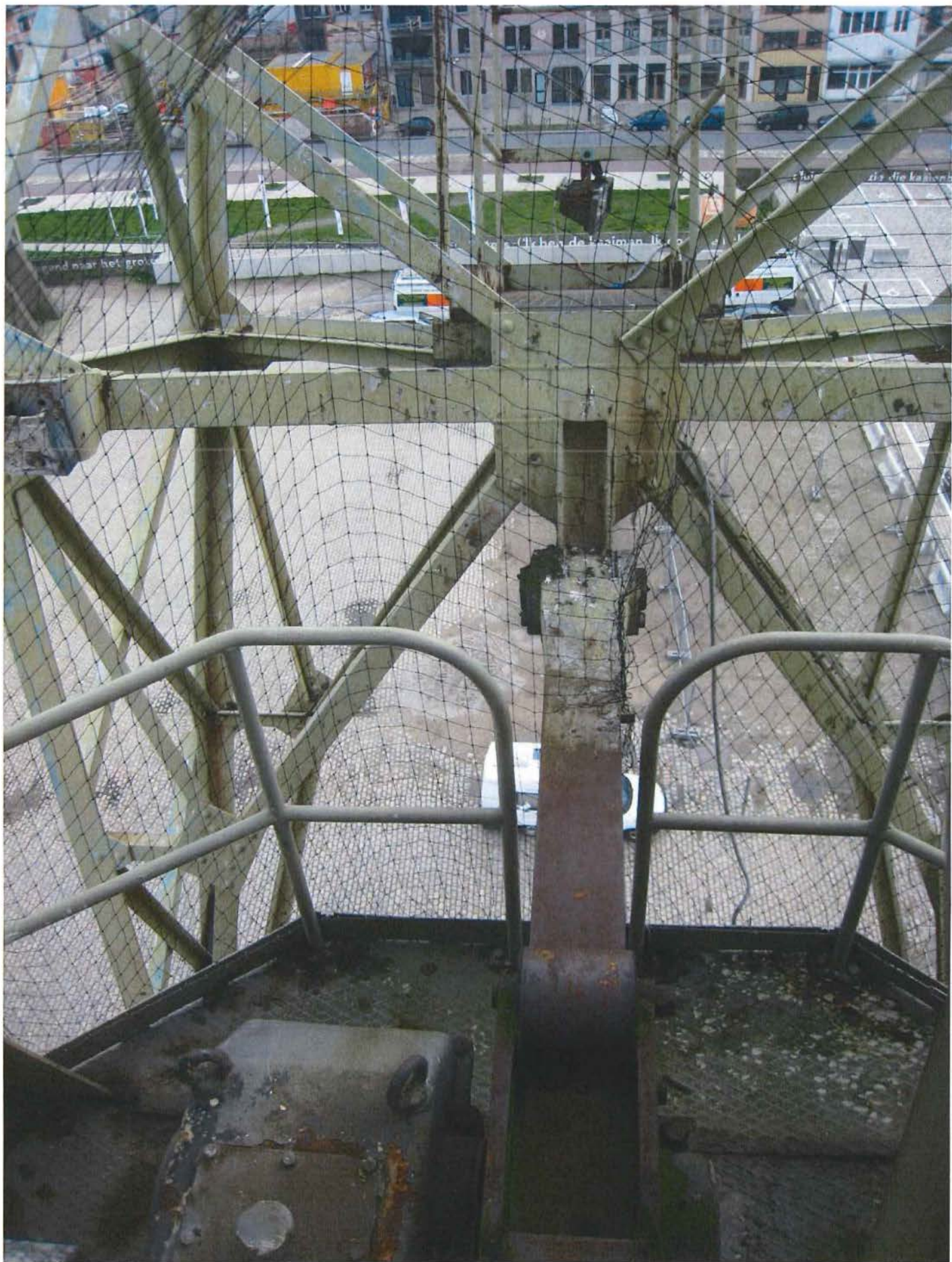
Foto 33: De heugelstang is verbonden met de giek en kan de giek verder weg van de toren laten zakken of de giek naar de toren toe trekken (toppen).
