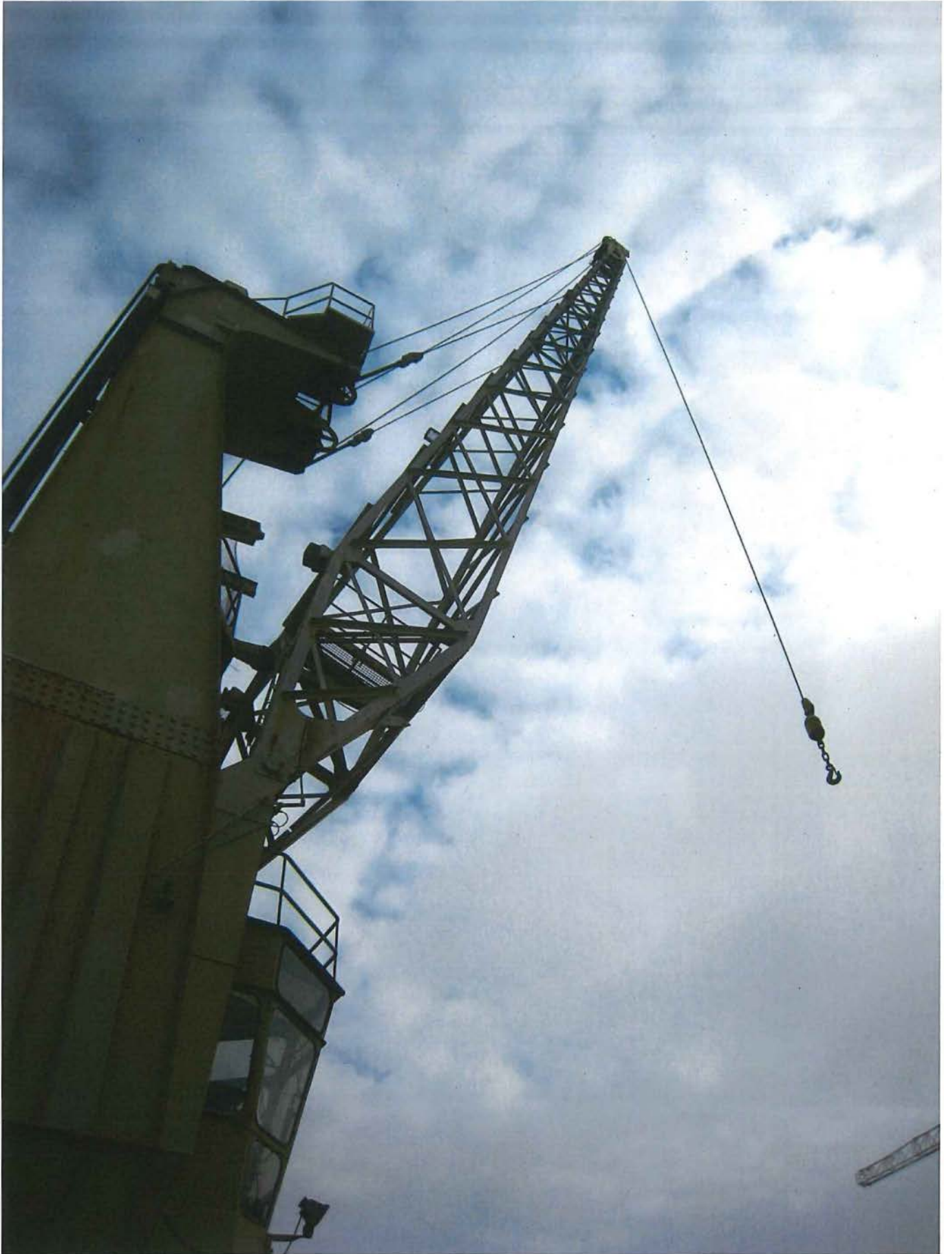
Foto 4: De giek in vakwerk scharniert vlak boven de stuurcabine. Vlak onder de draaias van de giek zijn enkele stangen te zien die op een mechanisme wijze aan de kraandrijver in de erker duidelijk maken in welke hoek de giek zich bevindt.
