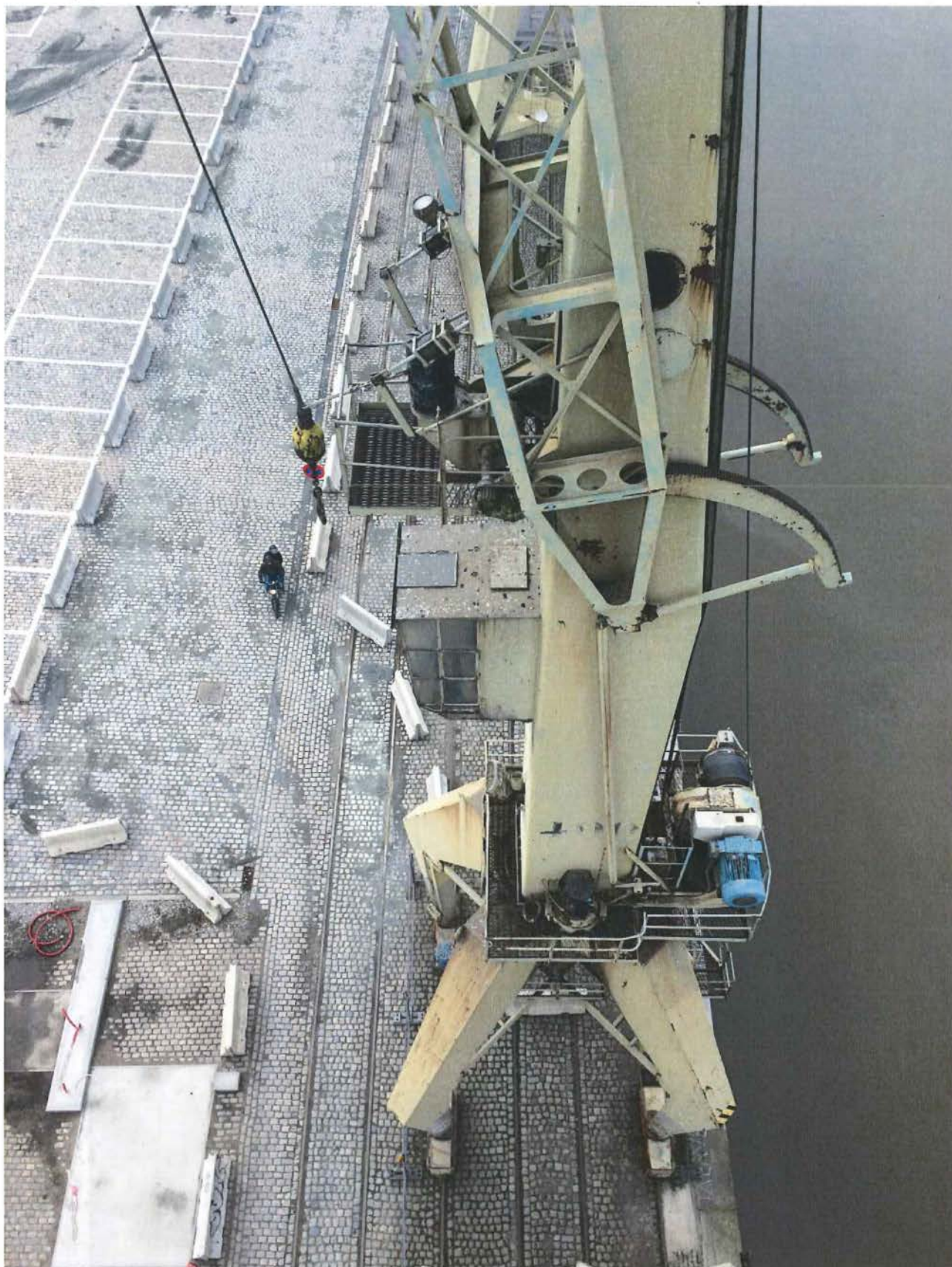
Foto 3: Zicht op het bordes met de zwenk- en hijsinstallatie, de stuurcabine, daarboven het platform met het topmechanisme en het scharnierpunt van de giek.
