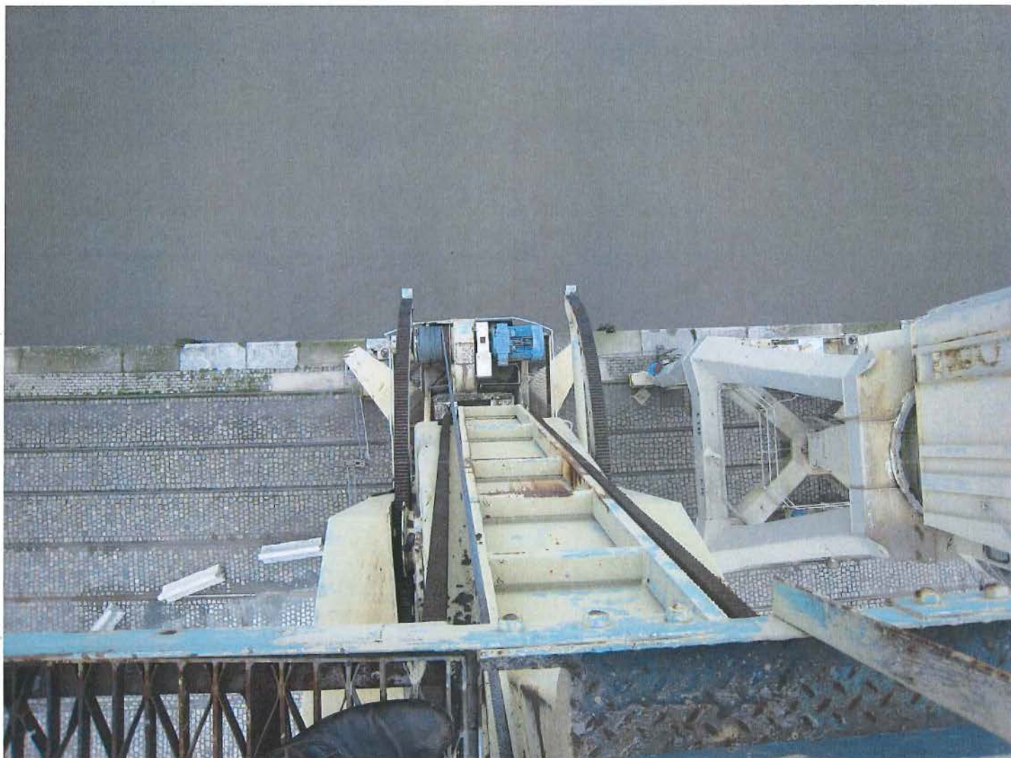
Foto 13: Een zicht vanop de top van de toren op de achterzijde van de toren met de glijbaan voor het tegengewicht van de giek.
