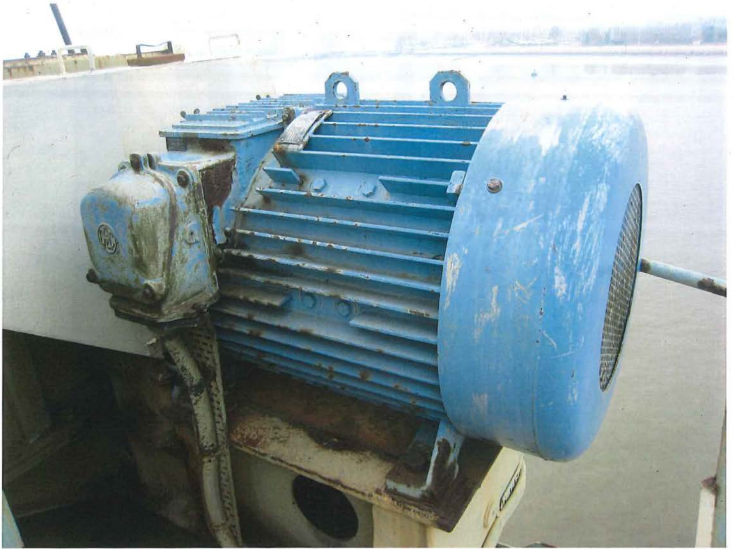
Foto 10: De elektromotor op het bordes voor het hijsen van de last.
