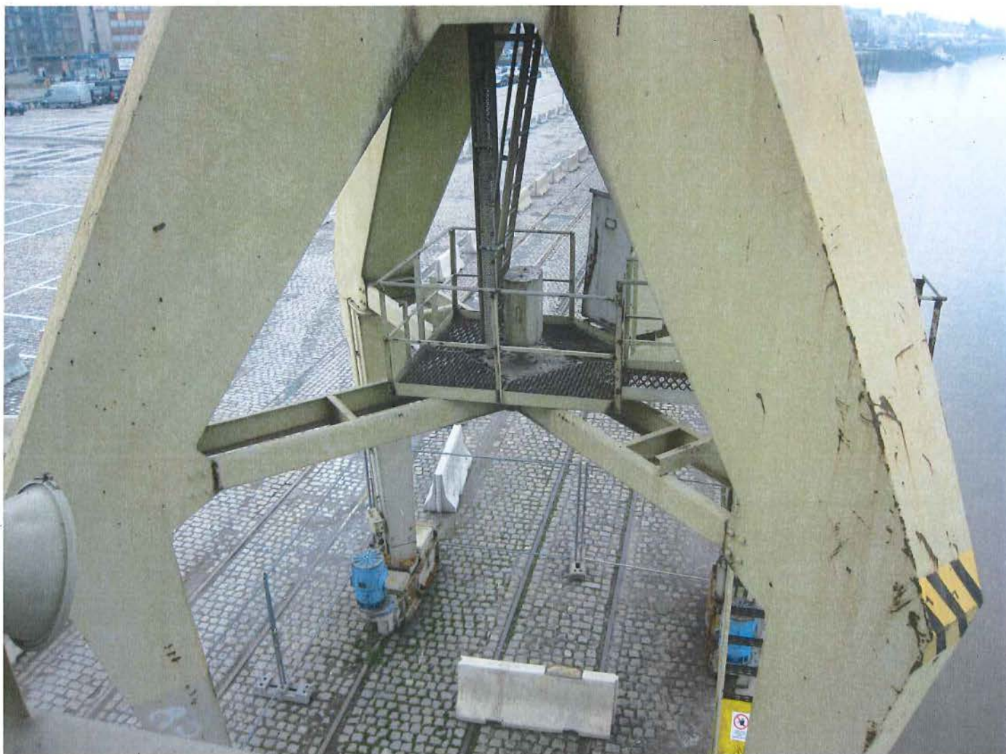
Foto 5: De kruisvormige verstijving van de portaalpoten met het platform dat toegang geeft tot de ladder naar de toren.
