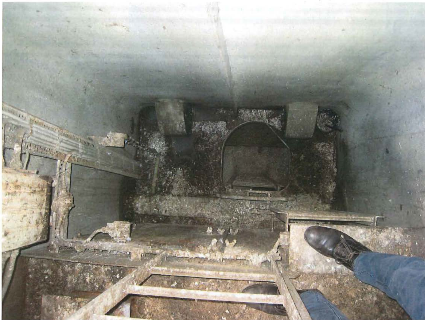
Foto 14: Een zicht op de binnenzijde van de toren.
