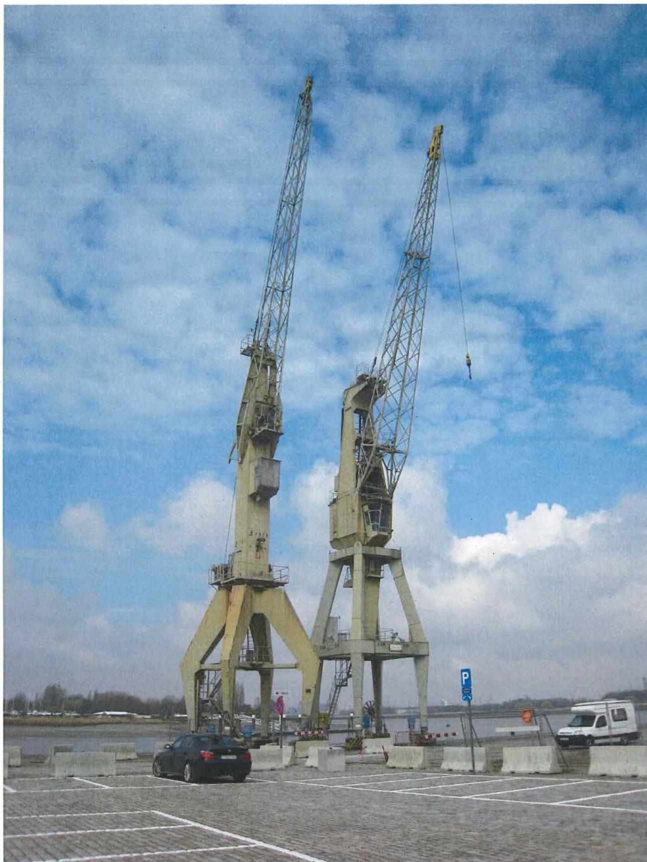
Foto 1: De 400 KA staat op de foto links opgesteld op de rails aan de Rijnkaai in Antwerpen.
