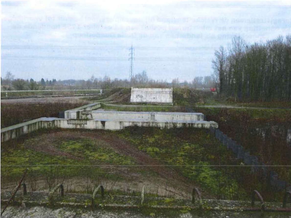
Foto 1: Zicht van op de rechteroever op de sluis ter hoogte van de aansluiting van de Oude Denderloop op de Nieuwe Dender.
