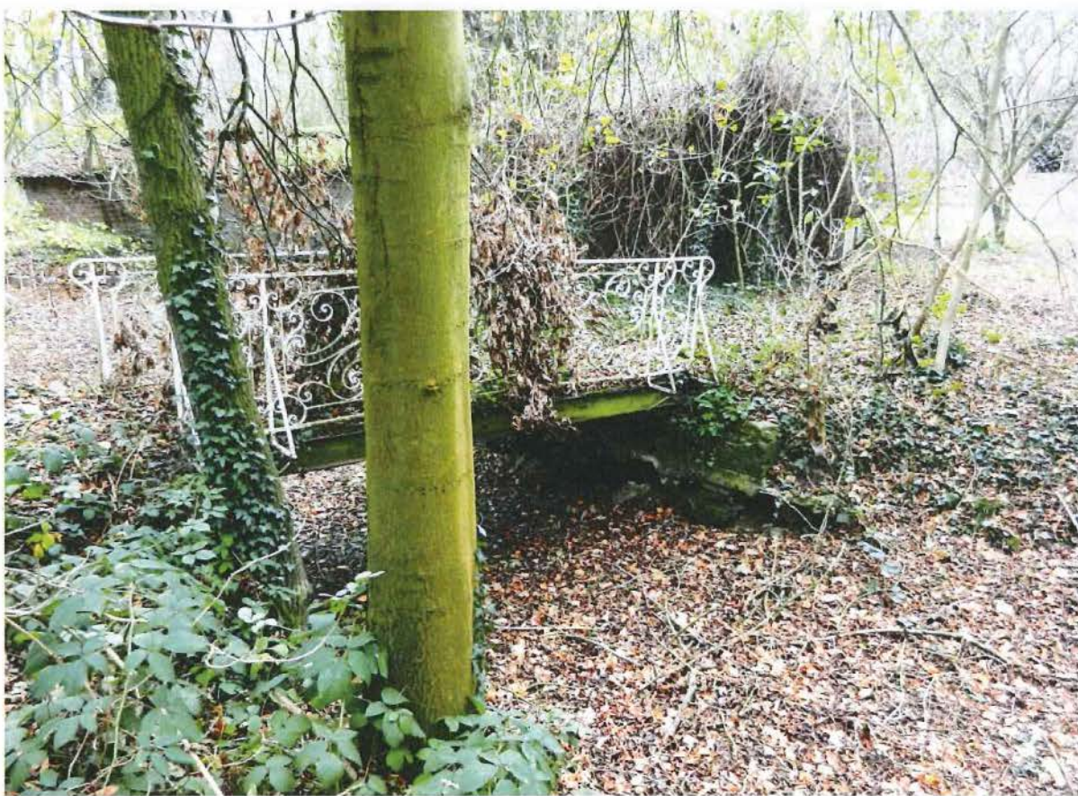
Foto 16: brug over de westelijke arm van de vijver, met liggers op imitatierots
