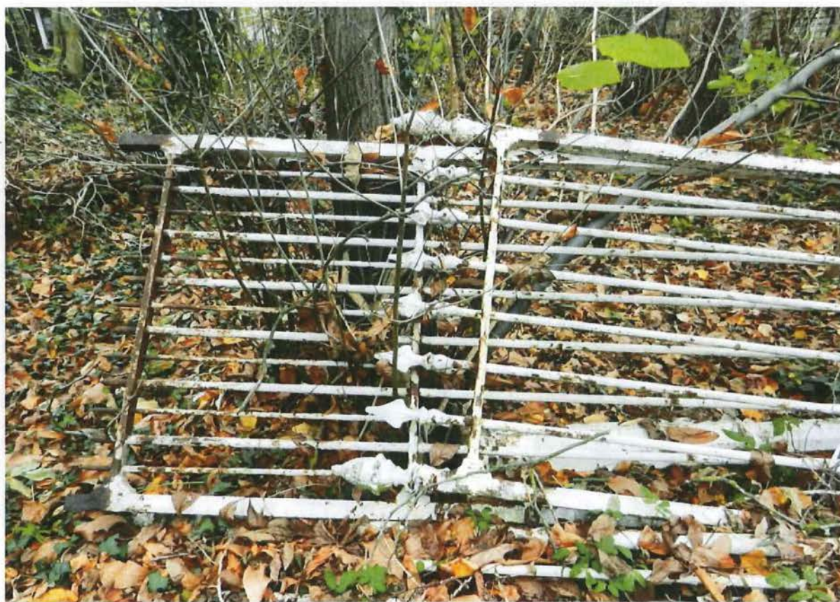
Foto 4: ontmanteld poorthekken van de afsluiting aan de Aarschotsesteenweg, momenteel langs de dreef naar het landhuis
