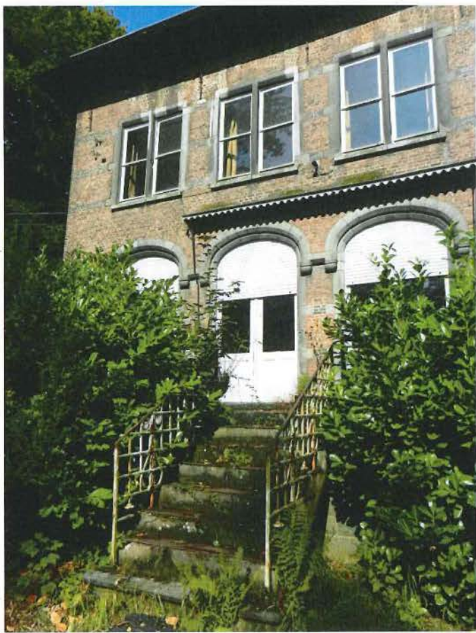
Foto 29: trap en voorgevel van de voorbouw
