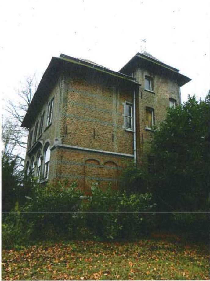
Foto 27: de noordgevel en de traptoren van het landhuis
