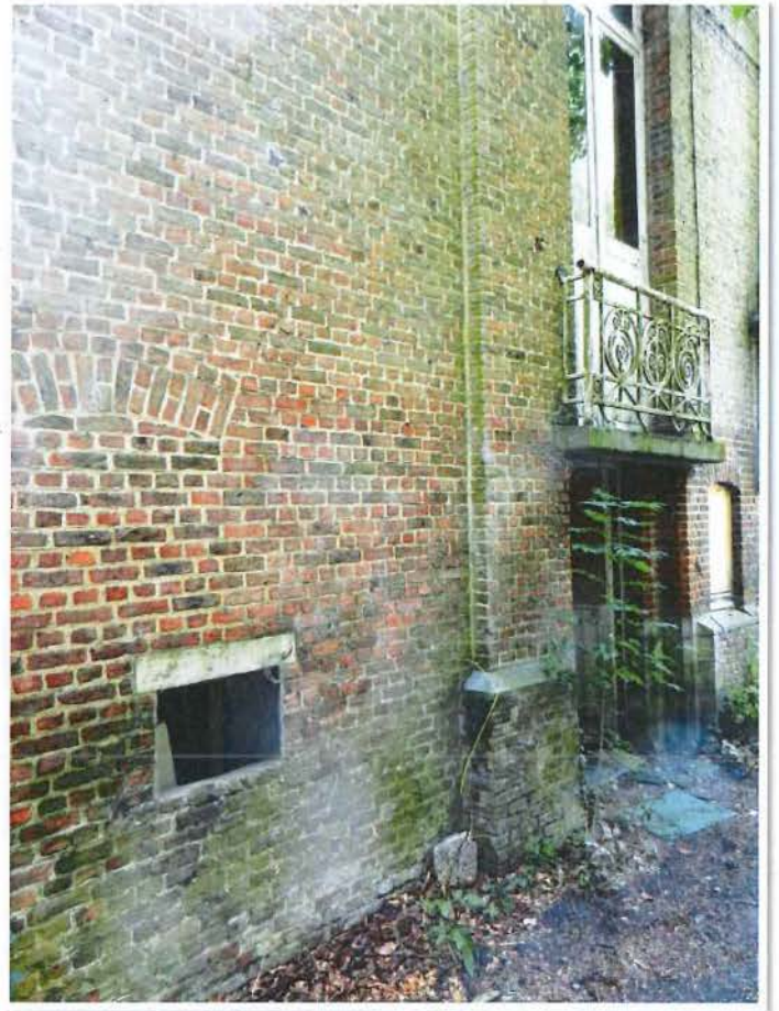
Foto 34: venster met balkon en balustrade in de achtergevel
