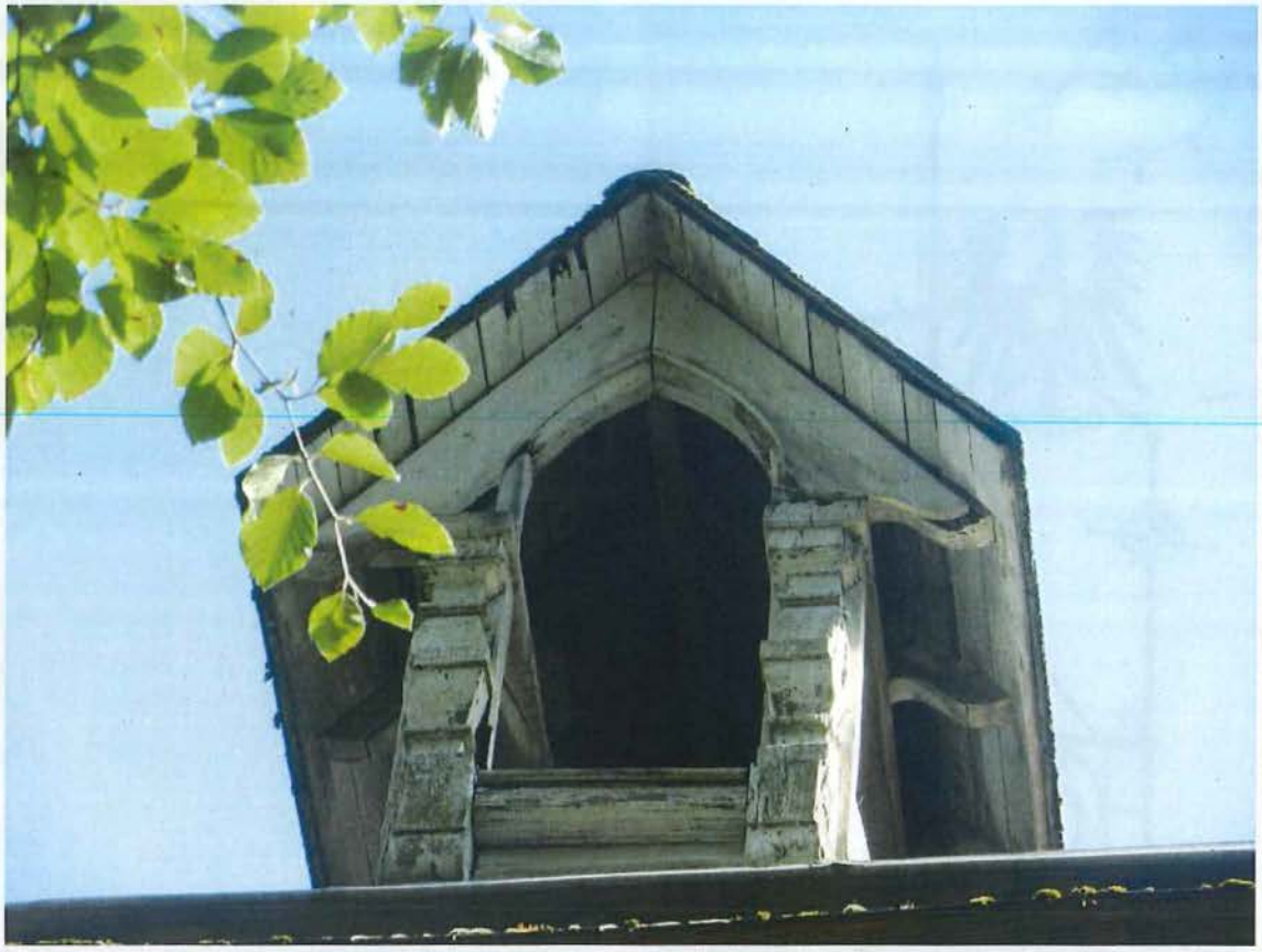
Foto 31: dakkapel op het zuidelijke dakschild van de voorbouw
