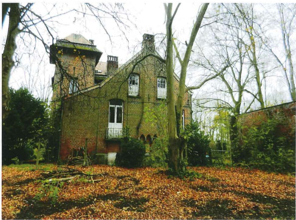
Foto 26: het landhuis vanuit het westen, met zicht op de achtergevel
