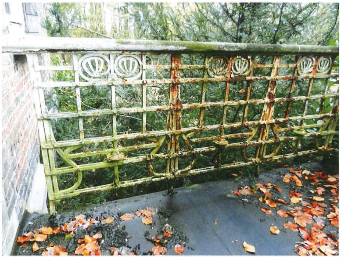
Foto 32: balustrade van het balkon van de voorbouw
