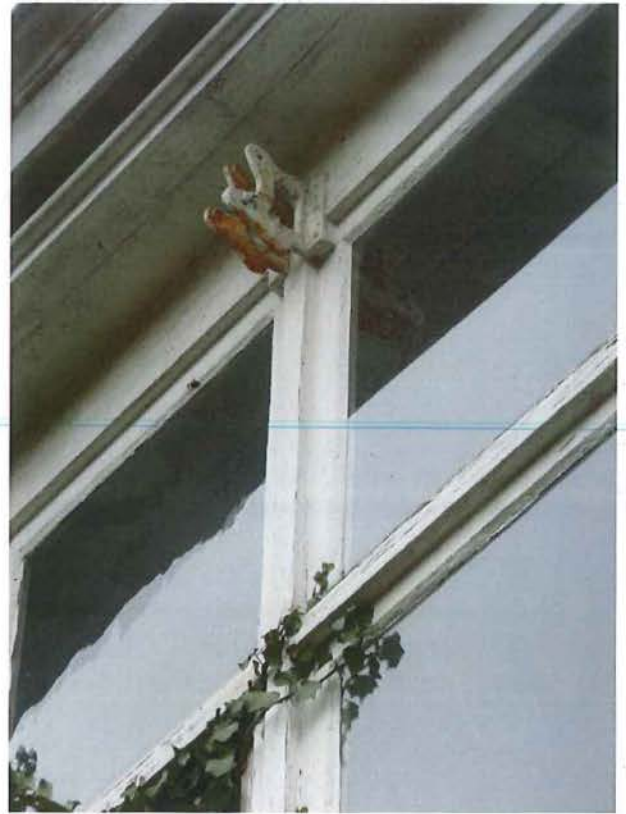
Foto 17: Diephuis, achtergevel met veranda, detail schrijnwerk
