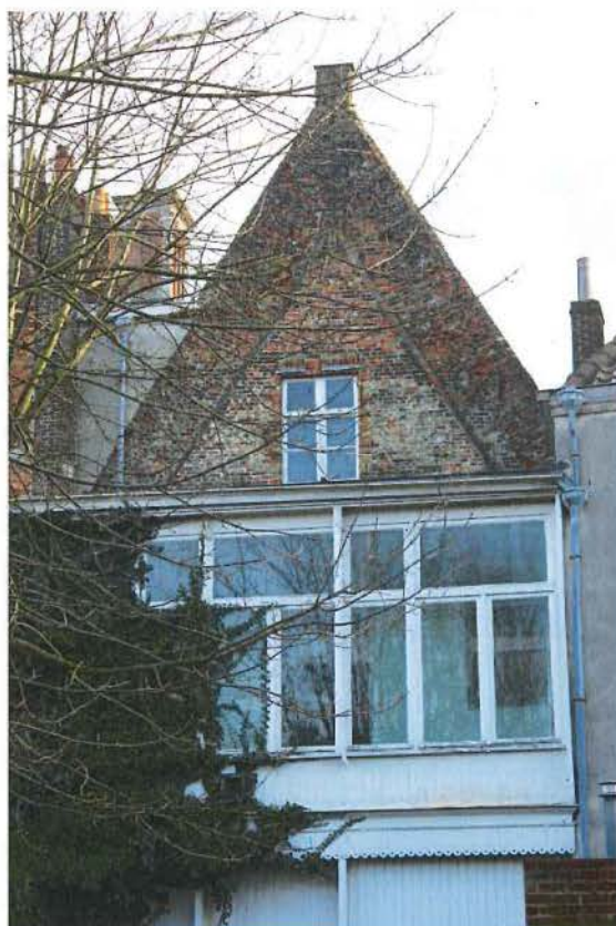
Foto 15: Diephuis, achtergevel met veranda
