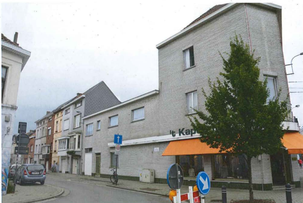
Foto 6: Zicht op oostelijke gevelwand van de Weldadigheidstraat, gezien vanaf de Hundelgemsesteenweg.
