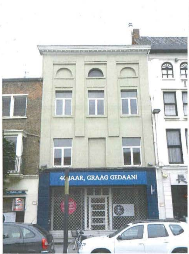
Foto 2: de voorgevel van het huis De Croone.
