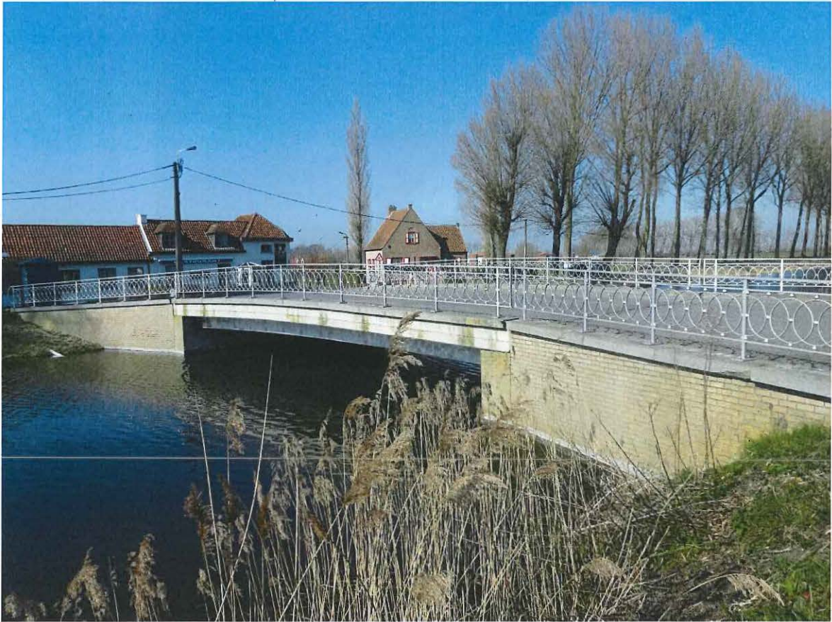
Foto 10: Kanaalbrug aan de Monnikeredestraat in Oostkerke
