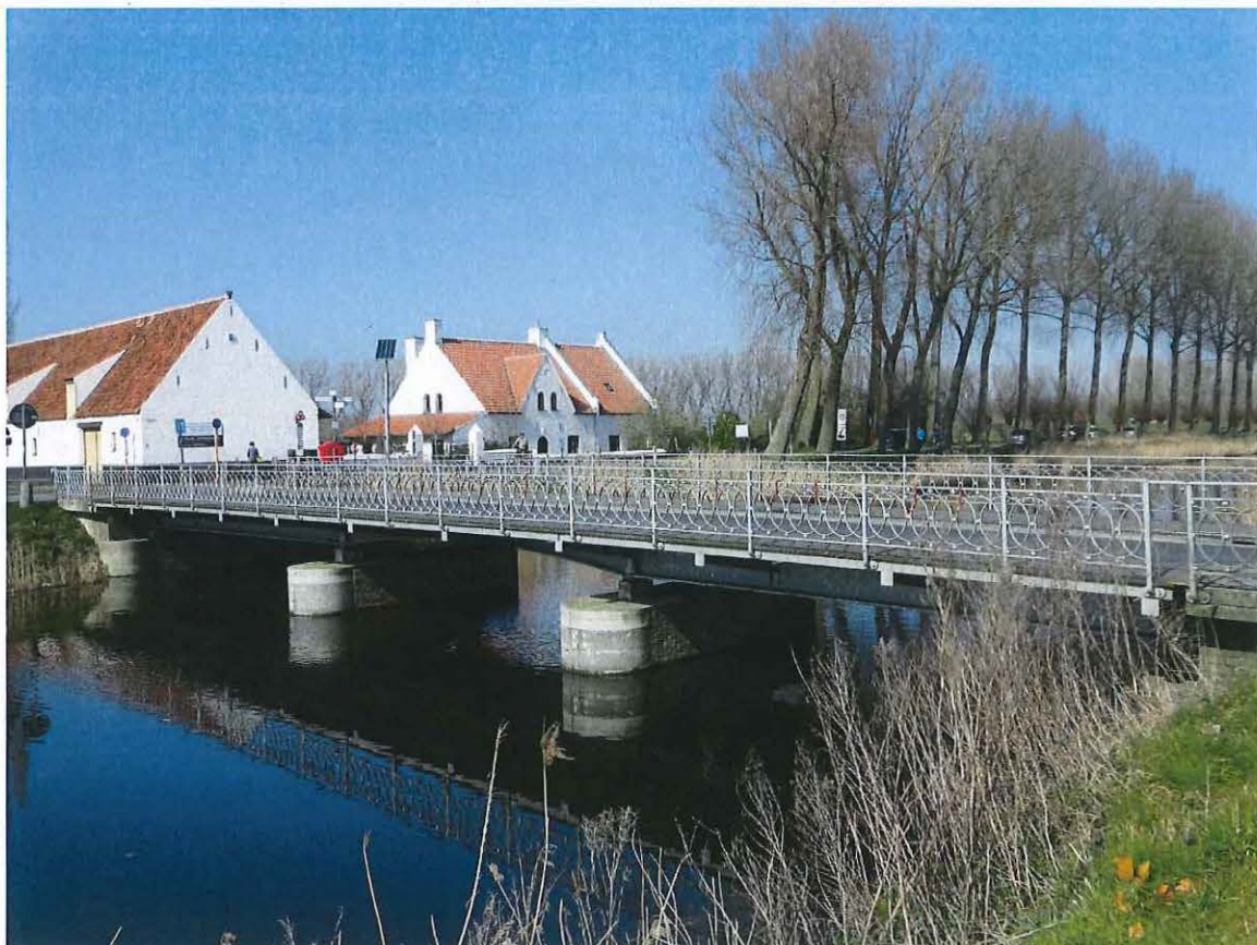
Foto 9: Kanaalbrug tussen Dammesteenweg en Kerkstraat in Damme
