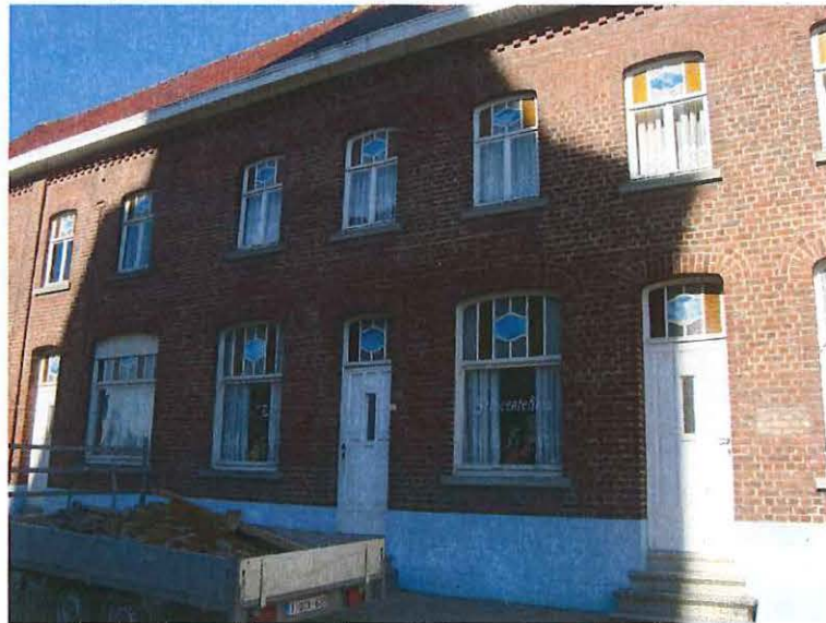
Foto 44: Rozebekeplein 4, gevelpartijen van voormalige winkel-café en woning met gekleurde beglazing in bovenlichten
