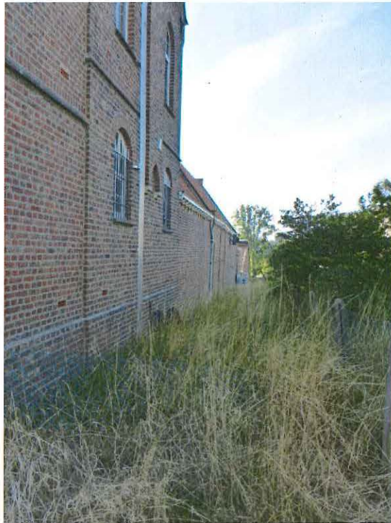
Foto 85: toegang voetweg tussen Rozebekeplein 11 en Rekelberg 1
