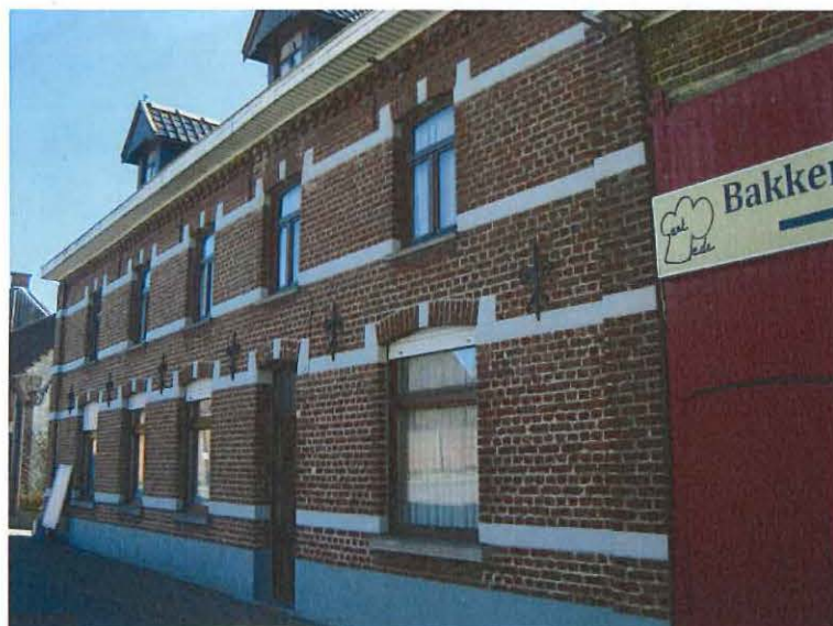
Foto 22: Rozebekeplein 9, boerenwoning van achterliggende hoevesite met poortgebouw
