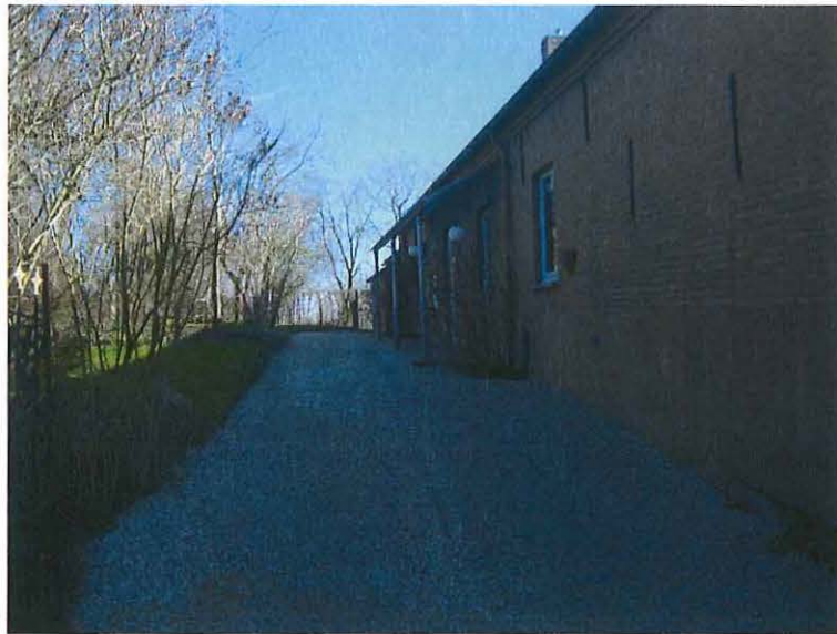
Foto 56: zijgevel Sint-Annastraat 2 met vroegere hoofdvleugel van U-vormige hoevesite
