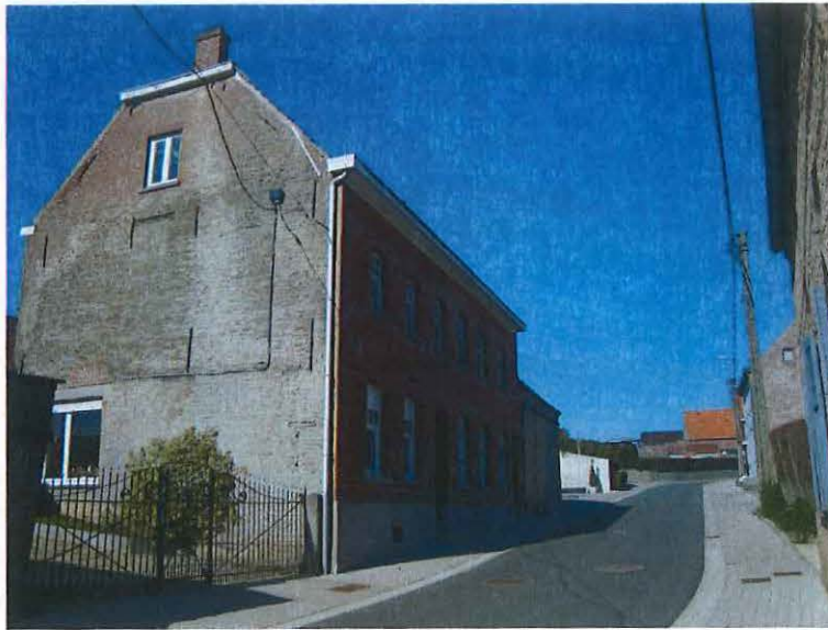
Foto 59: hoeve Sint-Annastraat 3, boerenwoning met laag poortgebouw
