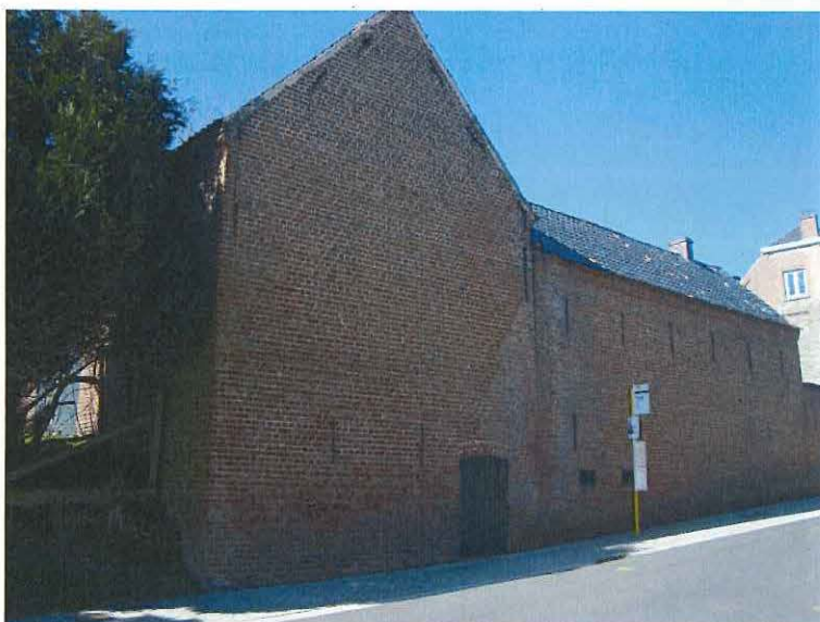
Foto 58: hoeve Sint-Annastraat 3, blinde L-vormige vleugel van stallen en schuur
