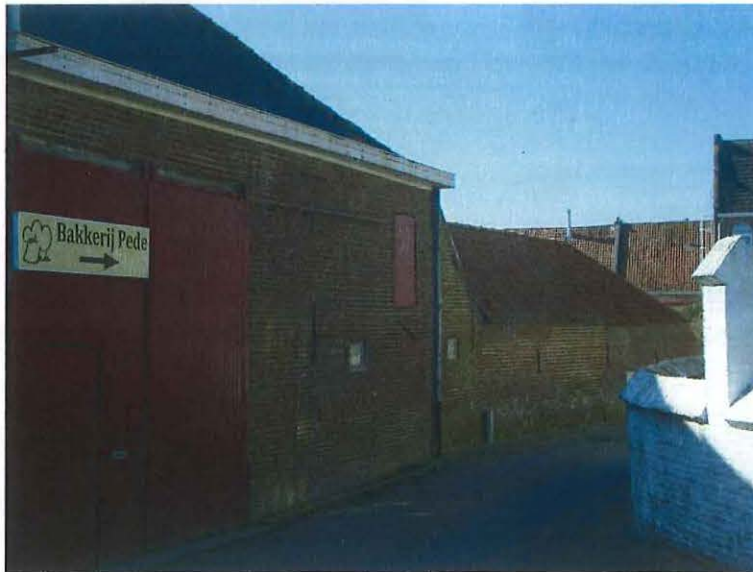
Foto 23: straatwand van Rozebekeplein 9, stallingen en poortgebouw bij achterliggende hoevesite
