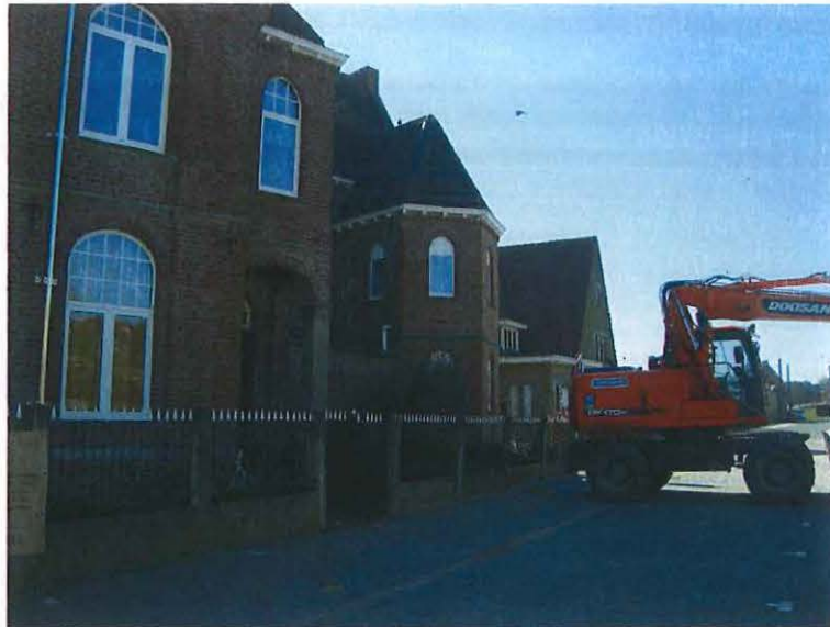
Foto 31: Rozebekeplein 11, voorgevel met voortuintje en hekwerk
