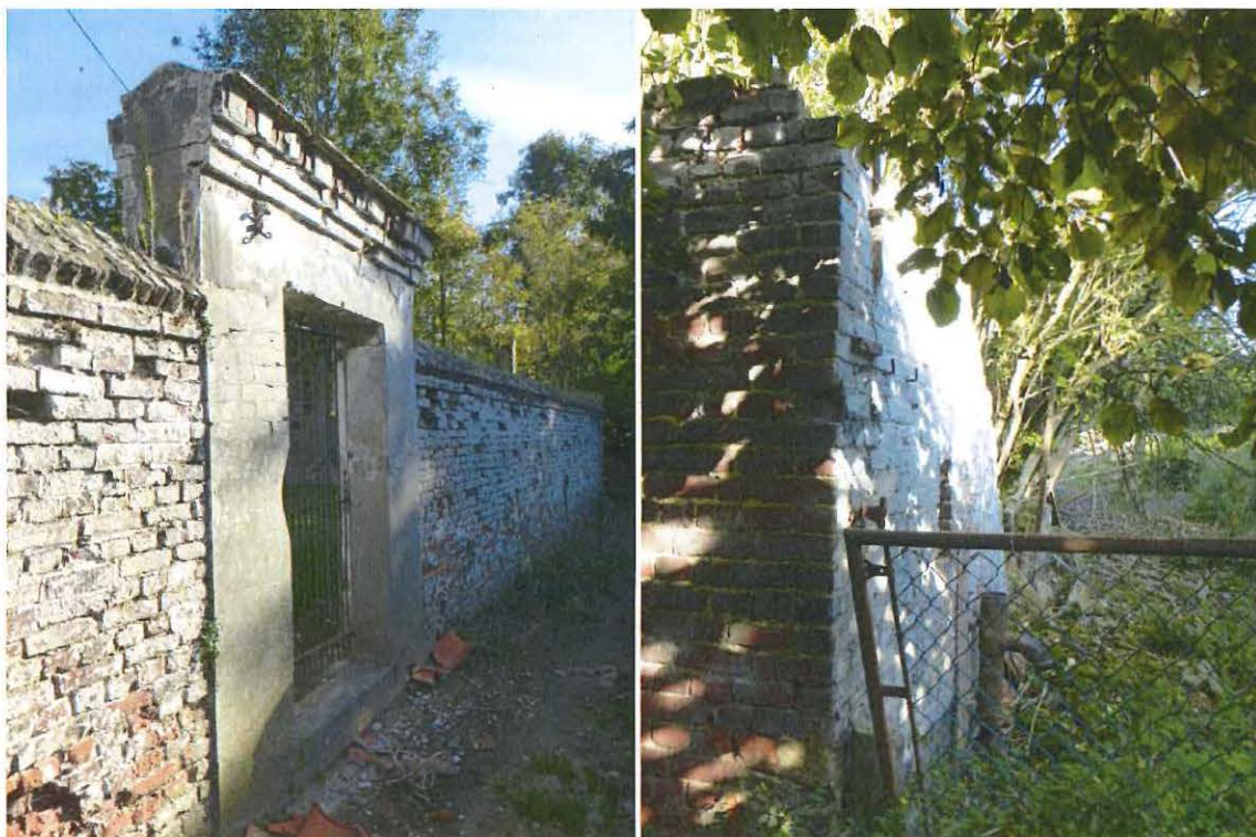
Foto 78: Rozebekeplein 1, oude pastoriemuur (zuidzijde) langsheen voetweg 13 en restant aan oostzijde
