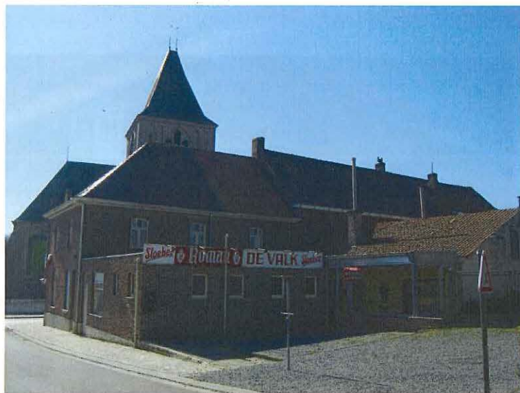
Foto 46: zicht op kerk en achterzijde bebouwing Rozebekeplein 2-4
