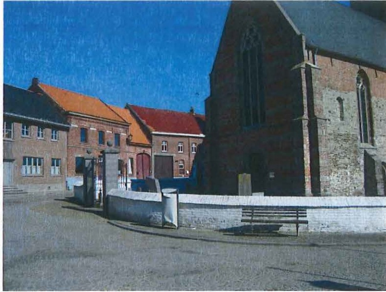
Foto 39: zicht op westzijde kerk en op bebouwing noordzijde Rozebekeplein
