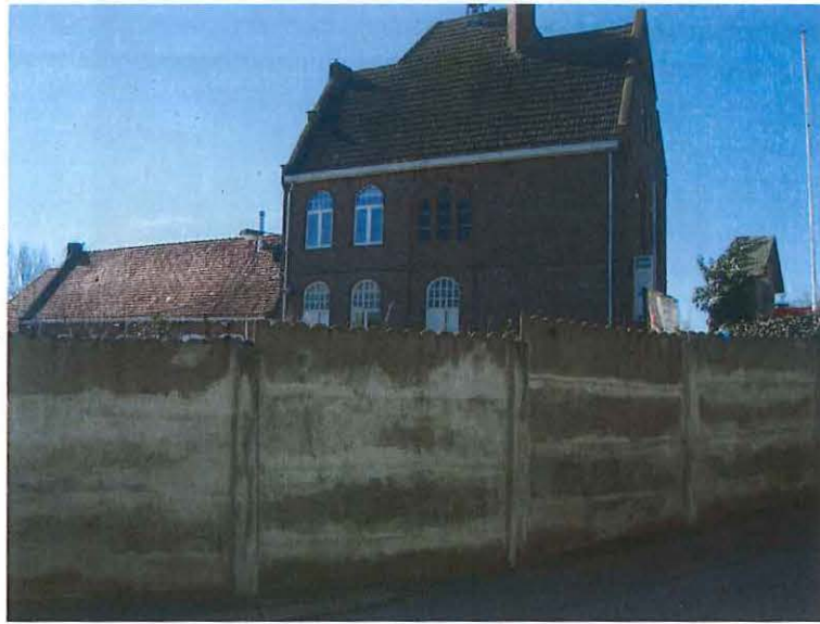
Foto 27: Rozebekeplein 11, zijgevel klooster en kloosterschool gezien vanop Rozebekeplein
