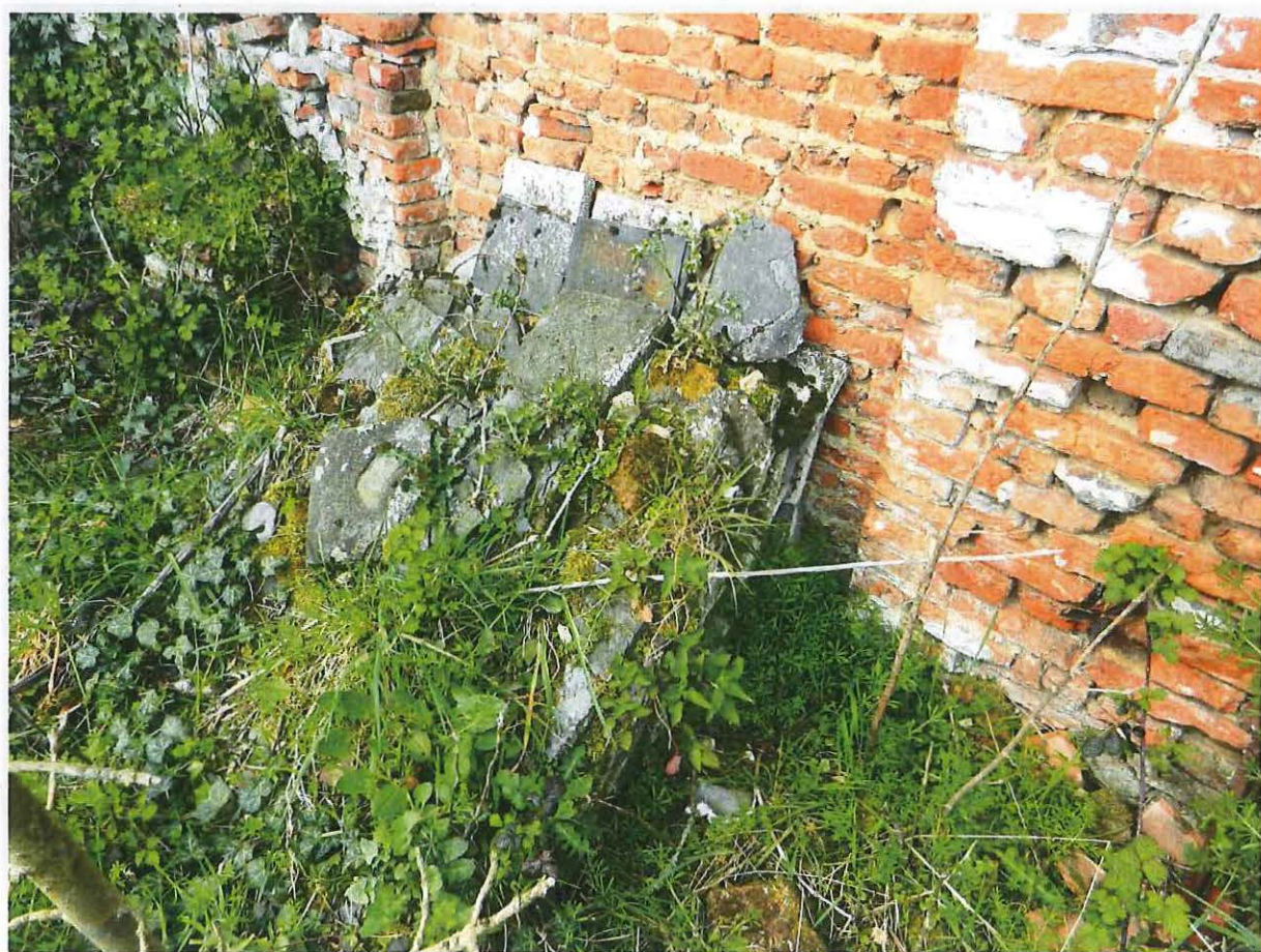
Foto 20: stapel dakleien tegen de noordmuur van de vroegere zuidvleugel.
