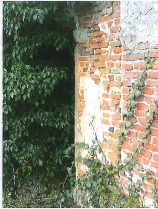
Foto 14: dagkant van de deuropening naast de traptoren.
