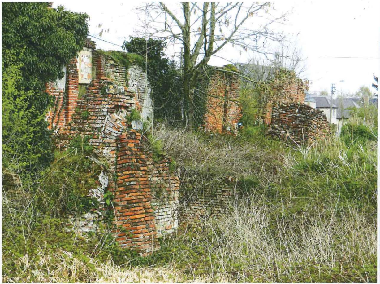
Foto 18: de resten van de noordvleugel, gezien vanuit het westen. Centraal, achter de begroeiing op de voorgrond, de muren van de kelder onder de vroegere zuidvleugel.
