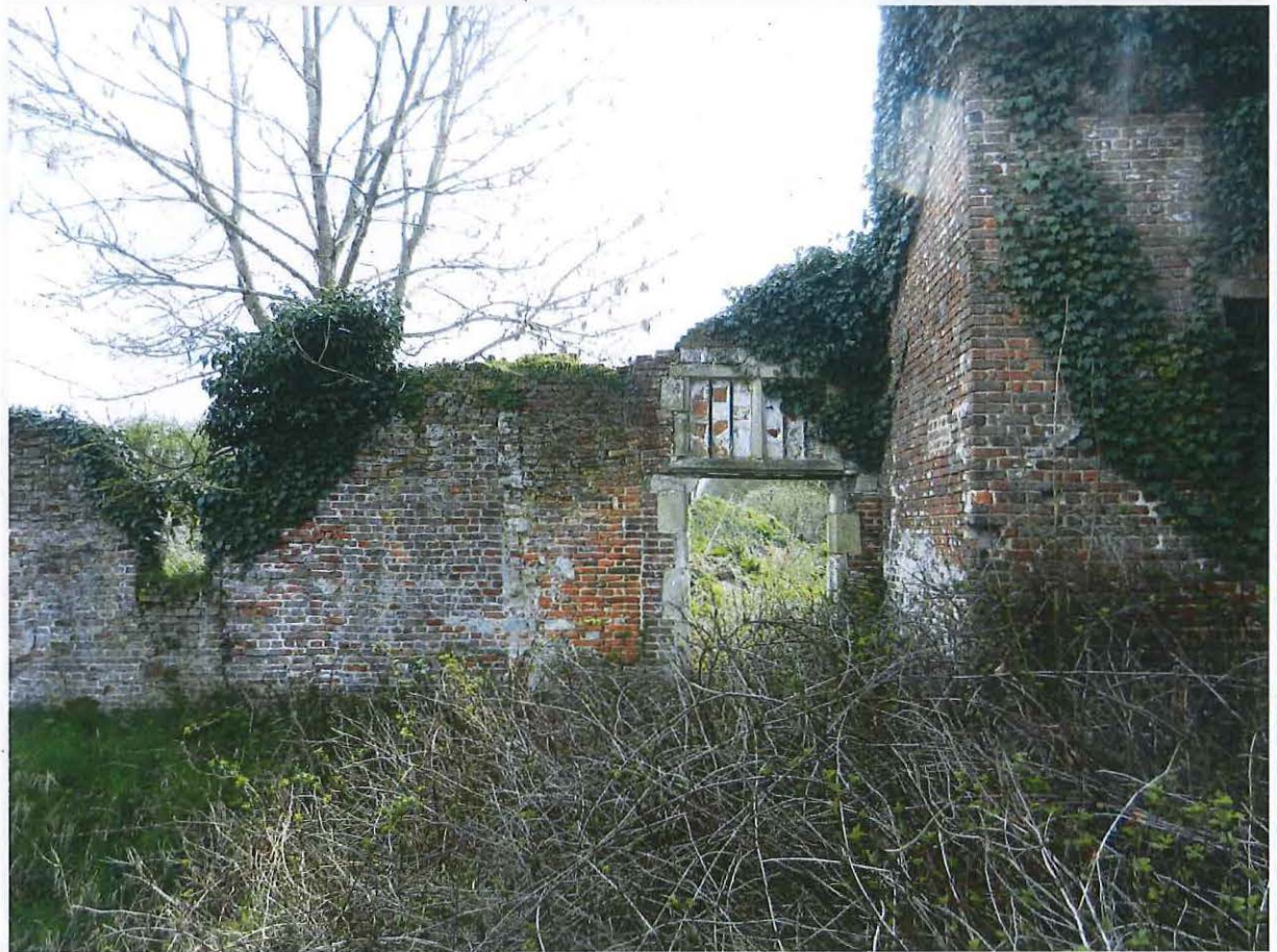
Foto 9: noordmuur van de vroegere zuidvleugel en traptoren.
