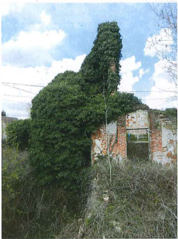
Foto 15: zicht op de traptoren vanuit het zuiden.
