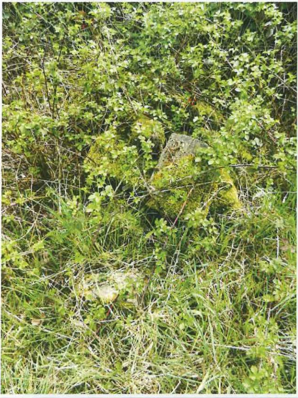
Foto 21: overwoekerde natuurstenen bouwfragmenten naast de noordmuur van de vroegere zuidvleugel.
