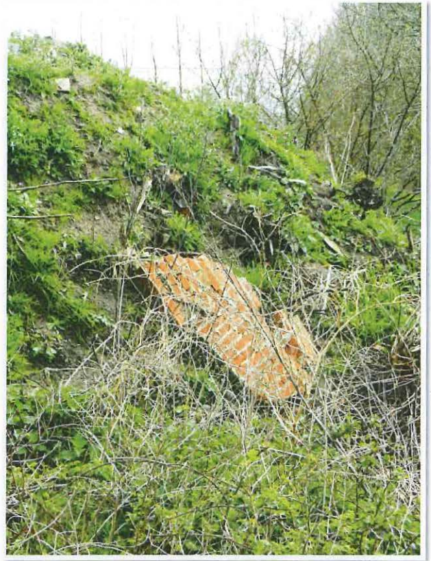
Foto 22: bakstenen bouwfragment ten zuiden van de vroegere noordvleugel.
