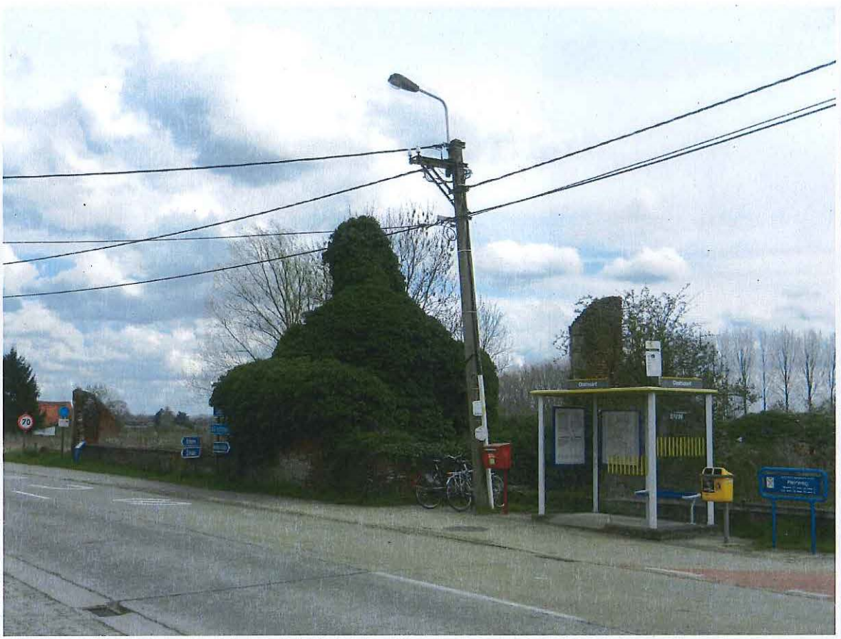
Foto 4: de ruïne van het hof van Coudenborn gezien vanuit het noordwesten. Het bushokje staat op de brug over de Oostvaart.
