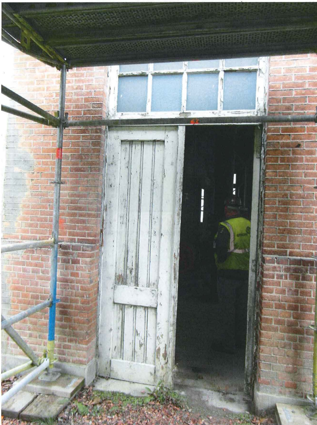
Foto 3: De toegangsdeur tot de gelijkvloerse verdieping.
