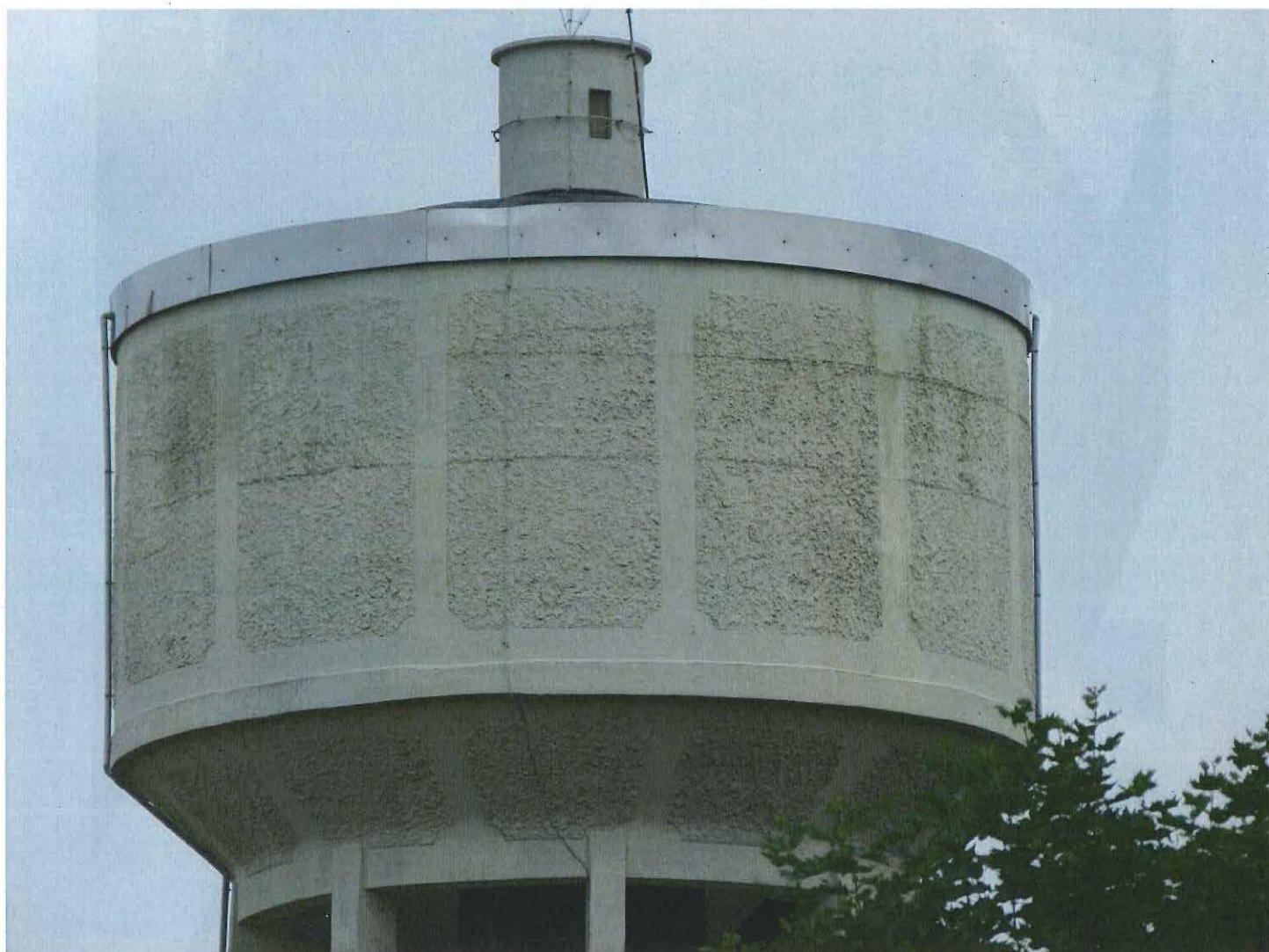
Foto 5: Het uitkragende Intze 1-reservoir in beton.
