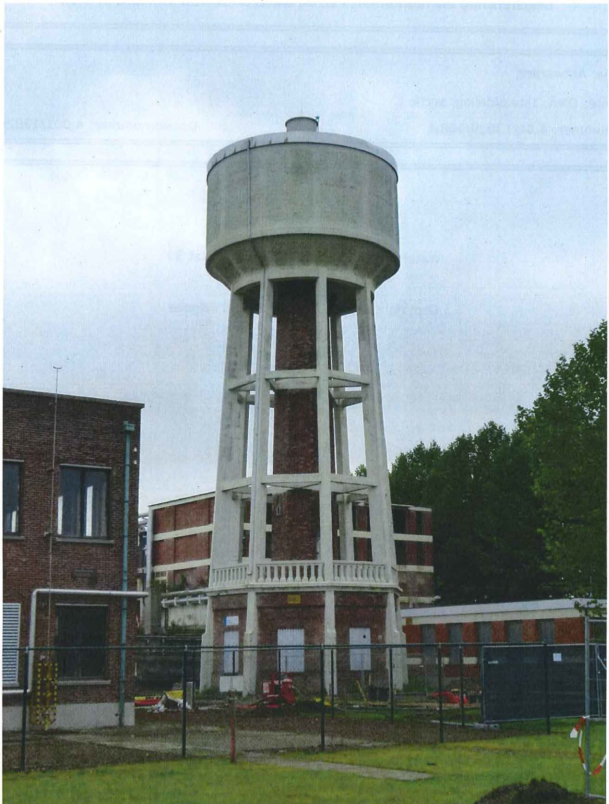
Foto 1: Algemeen zicht op de watertoren.
